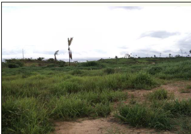
Foto 4 – Parte superior do Talude em recuperação. RONDONMAR sub Jazida 1C Dezembro/2011
