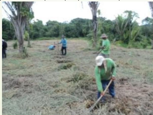
Atividades de coroamento e abertura de covas
