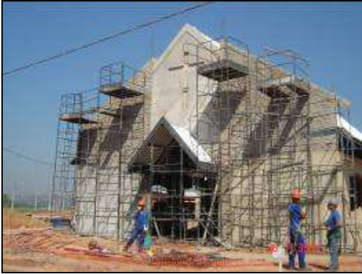
Foto 116: Construção da igreja católica de Nova Mutum Paraná. Fonte: CNEC, 2010
