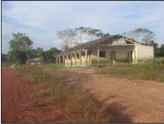
Foto 93: Ramal São Francisco – Escola Municipal. Fonte: CNEC, 2010
