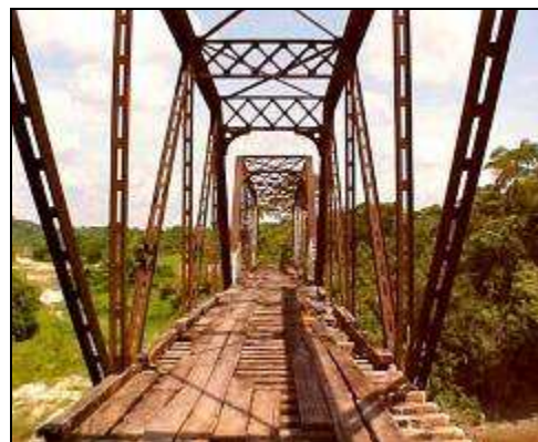
Foto 130: Sítio Mutum-Paraná: Ponte metálica em treliça sobre o rio Mutum-Paraná. Fonte: FURNAS et al, 2005, EIA, TOMO B, Volume 8, p. IV-1331
