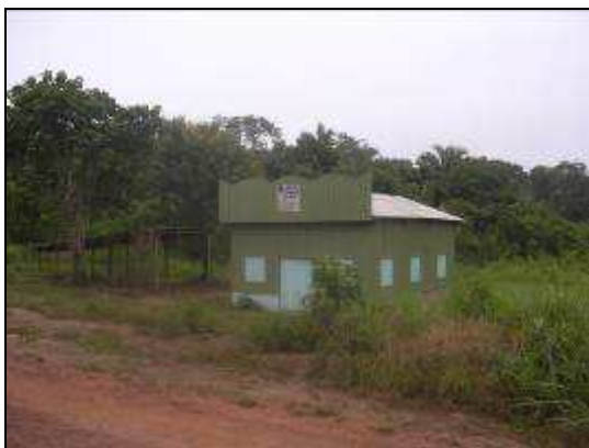
Foto 66: Ramal do Arrependido – Igreja. Fonte: CNEC, 2010
