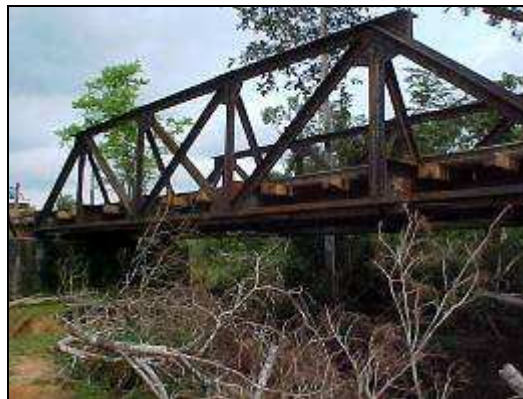
Foto 128: Sítio Primavera – ponte metálica, em treliça, localizada sobre o rio Trinta, no ramal Primavera.
