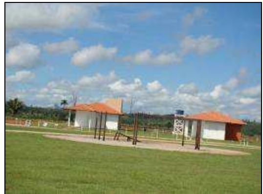
Foto 111: Margem direita - local de construção da Nova Mutum Paraná. Fonte: CNEC, 2010
