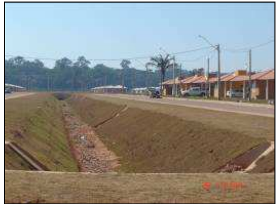
Foto 113: Construção da Nova Mutum Paraná – área residencial. Fonte: CNEC, 2010
