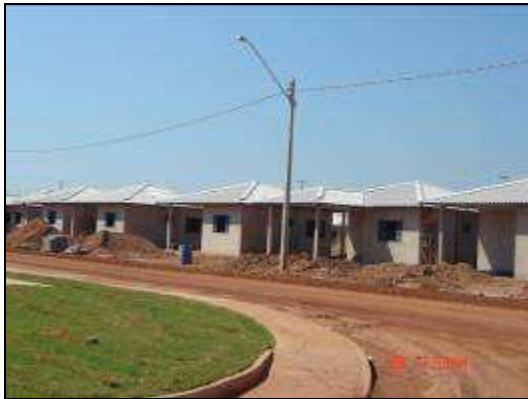
Foto 112: Construção da Nova Mutum Paraná – habitações. Fonte: CNEC, 2010
