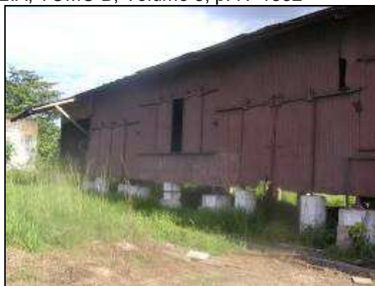
Foto 133: Galpão da ferrovia EFMM em Abunã, com cobertura e laterais em chapas metálicas. Fonte: CNEC, 2010
