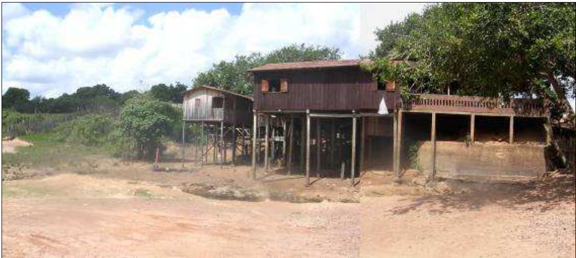
Foto 70: Sede Distrital de Mutum-Paraná – Habitações sobre palafitas, lado oeste da rodovia.
