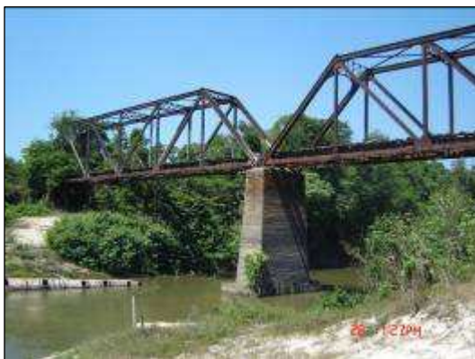
Foto 80: Antiga ponte da EFMM sobre o rio Mutum-Paraná. Fonte: CNEC, 2010
