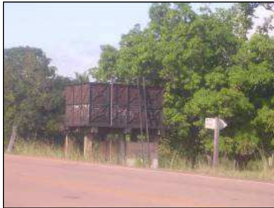
Foto 68: Localidade Jirau – Caixa d'água metálica, pertencente ao patrimônio da Estrada de Ferro Madeira-Mamoré. Fonte: CNEC, 2010
