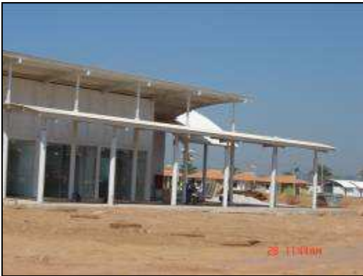
Foto 124: Construção do Centro Comercial de Nova Mutum-Paraná. Fonte: CNEC, 2010
