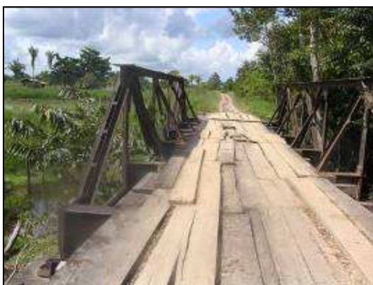
Foto 96: Ramal Primavera – Ponte de Ferro sobre o igarapé Trinta. Fonte: CNEC, 2010
