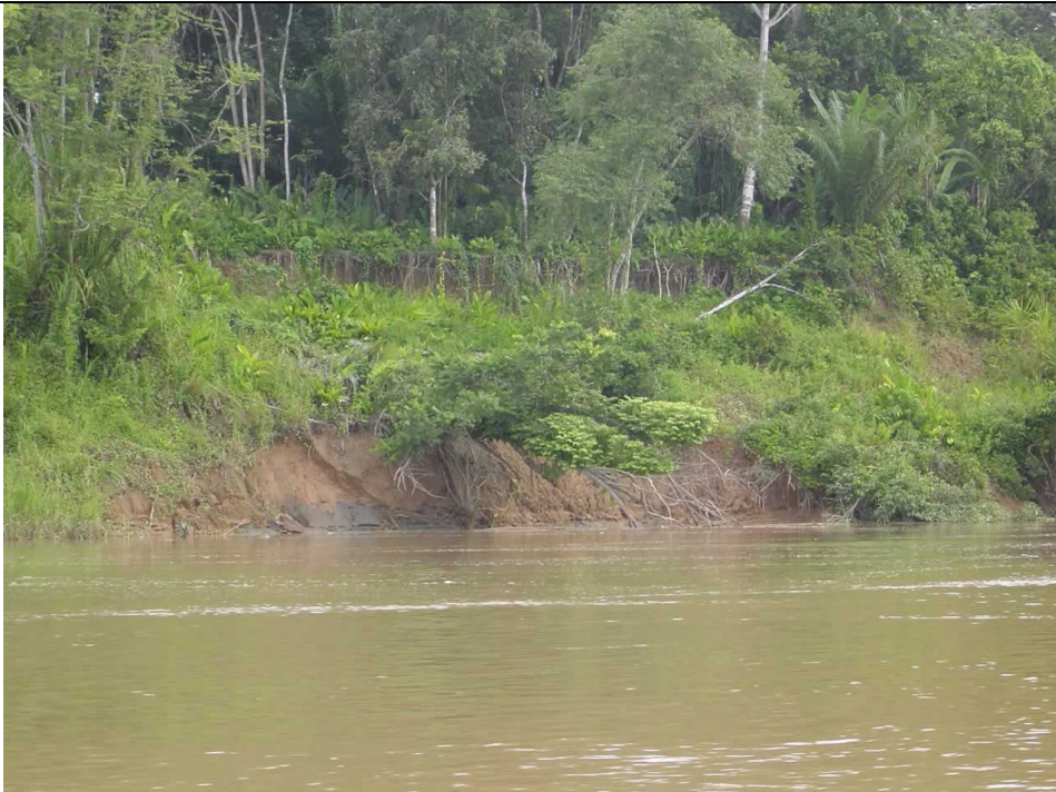
Fenômeno de “terras caídas”, pouco a montante da barragem de Santo Antônio. Neste local, as margens são mais estáveis que na ilha mostrada anteriormente, mas sofrem solapamento na base, durante a estiagem, que às vezes desestabiliza o barranco.
