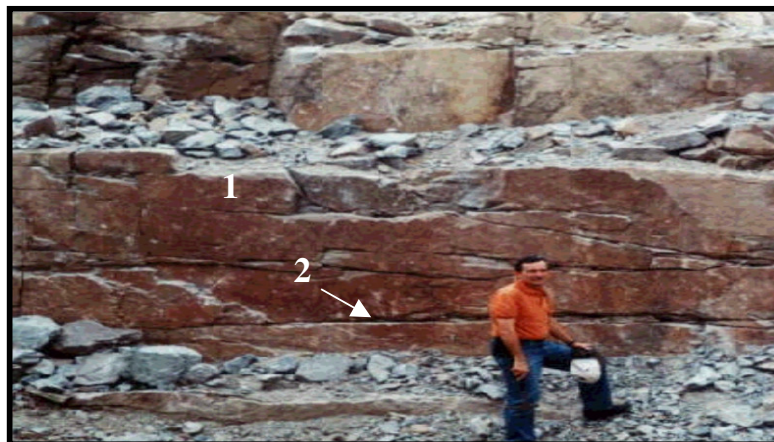
FOTO B.IV. 53 – Exposição no interior da cava da pedreira da Rondomar, onde se observa plano de falha (1) com atitude segundo N 45 E / subvertical. Em (2), fraturas subhorizontais correspondentes ao alívio de pressão litostática.
