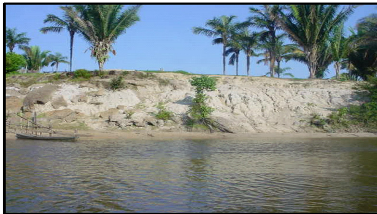
FOTO B.IV. 26 – Erosão provocada pela supressão da mata ciliar.
