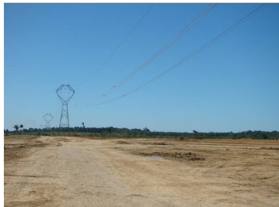
Figura 17 - Sub-estação coletora Porto Velho em construção, ponto final das 3 LTs (UTM 394085/9014189).
