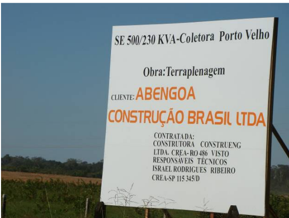
Figura 16 – Sub-estação coletora Porto Velho em construção, ponto final das 3 LTs (UTM 394085/9014189).
