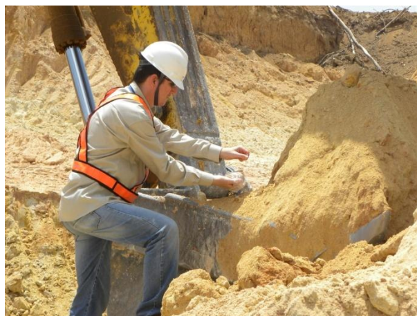
Foto 4.7.6 - Coleta de material de interesse ambiental no Canteiro de Obras.
