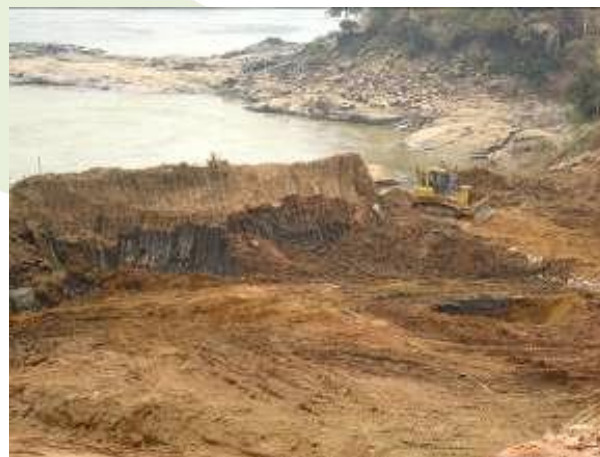
Foto 4.9.2 - Monitoramento das escavações na Ilha do Padre (Ago/2010).
