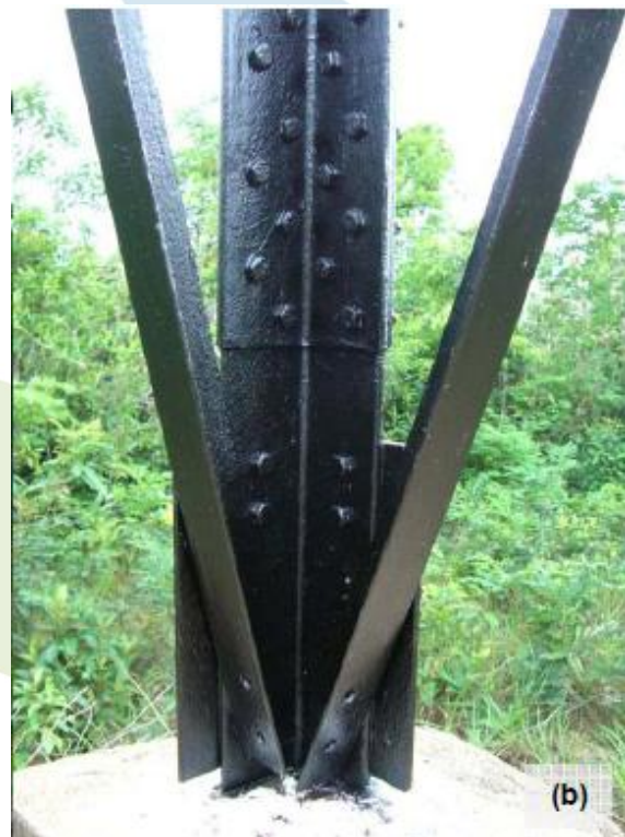
Foto 4.26.2 - Estrutura metálica de torre da LT de 230 kV com aplicação de tinta de base (Primer).
