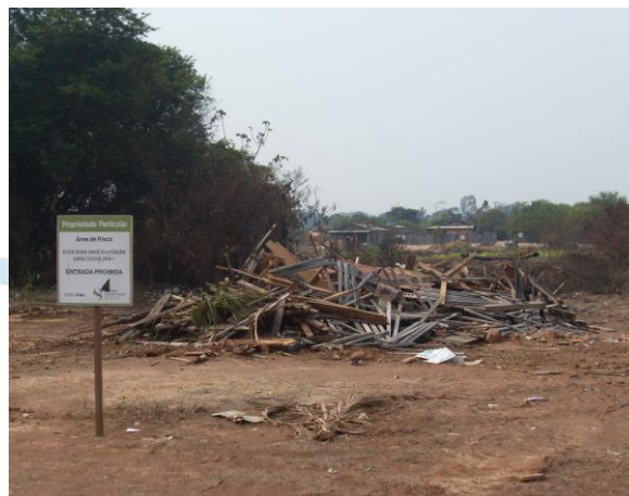
Foto 2.14.2 - Demolição das benfeitorias na área urbana de Mutum Paraná.
