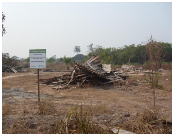
Foto 2.14.1 - Demolição das benfeitorias na área urbana de Mutum Paraná.
