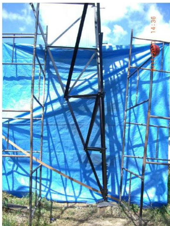
Foto 4.26.3 - Estrutura metálica da torre 395 com aplicação da segunda mão de alcatrão de hulha.
