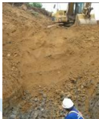
Foto 4.9.13 - Utilização de retro-escavadeira para retirada de sedimentos sobre troncos (Nov/2010).
