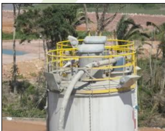
Foto 4.2.16 – Controle na usina de concreto
