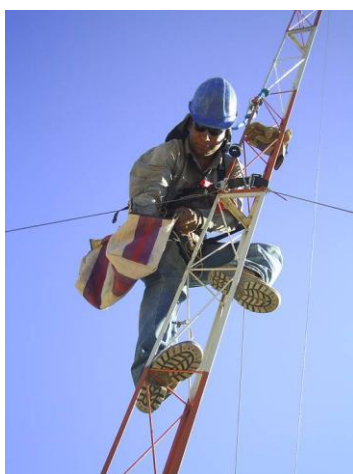
Foto 4.4.1 - Instalação da torre. (Jul/2010).
