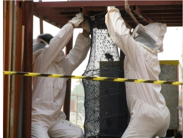
Foto 4.16.12 - Resgate de enxame migratório de abelhas no Canteiro de Obras.
