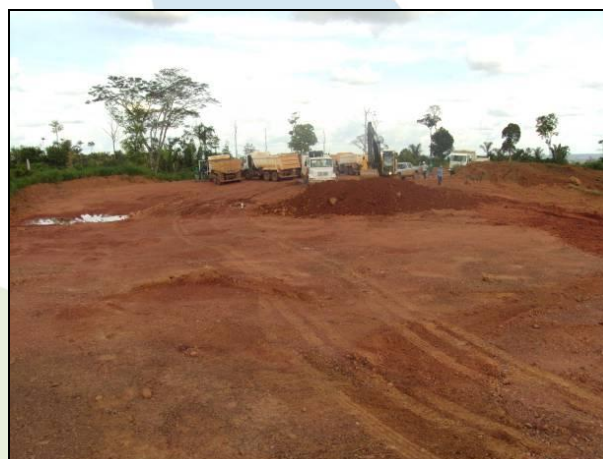
Foto 4.13.12 - Regularização topográfica na área da cascalheira 1.
