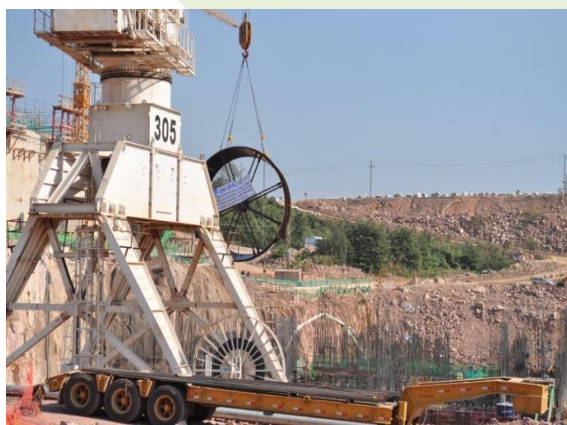
Foto 4.20.18 – Lançamento da 1ª Virola na Casa de Força I
