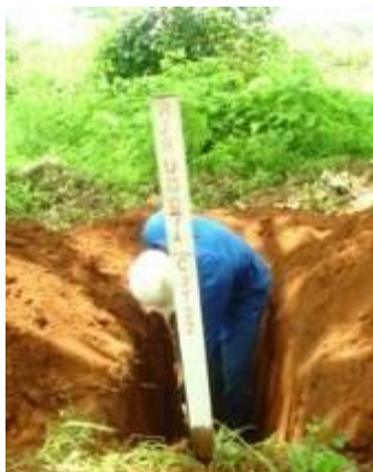
Foto 4.25.3 – Execução dos trabalhos de remoção dos campos santos
