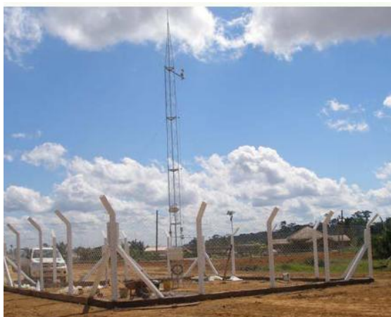
Foto 2.18.1 - Estação climatológica instalada no Canteiro de Obras do AHE Jirau.
