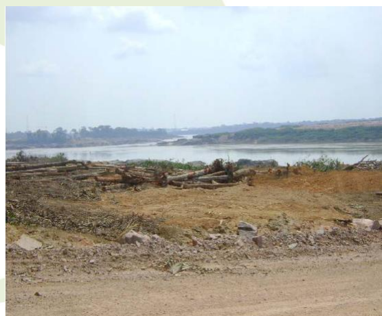
Foto 4.14.9 - Supressão de vegetação na área do futuro reservatório localizada no Canteiro de Obras (Out/2010).
