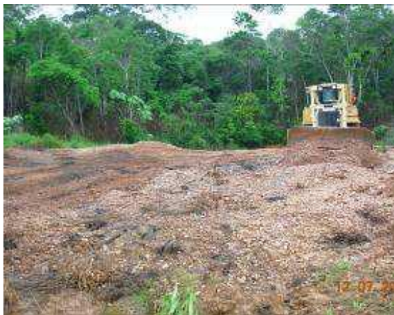
Foto 4.13.5 - Ordenamento das linhas de drenagem.
