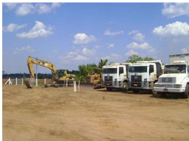
Foto 4.14.2 - Equipamentos da empresa WPG mobilizados no Canteiro de Obras (Jul/2010).
