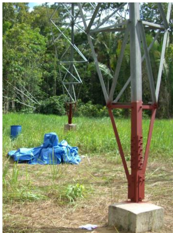
Foto 4.26.4 - Pintura de fundo na torre 400.
