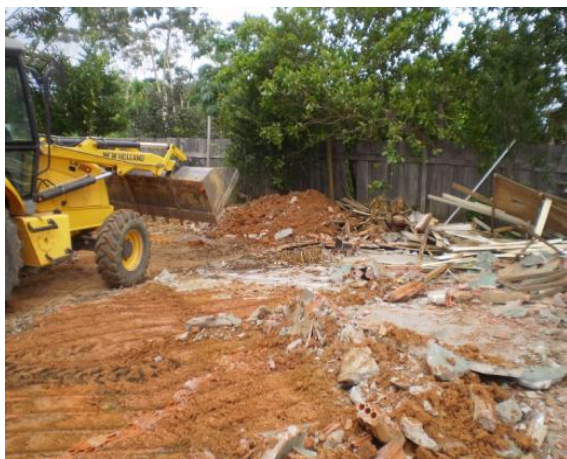
Foto 4.25.5 - Demolição de benfeitorias adquiridas
