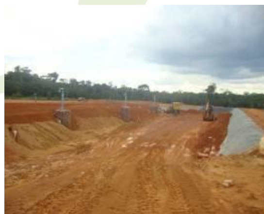
Foto 4.2.10 – Terceira vala do aterro sanitário
