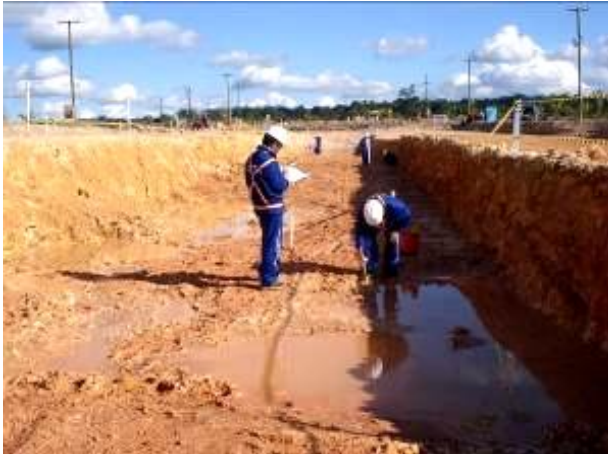
Foto 4.9.3 - Identificação de "canalículos" durante o monitoramento das escavações para construção da barragem na margem direita (Jun/2010).
