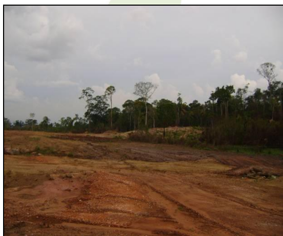
Foto 4.13.13 - Recomposição topográfica na área da cascalheira 2.
