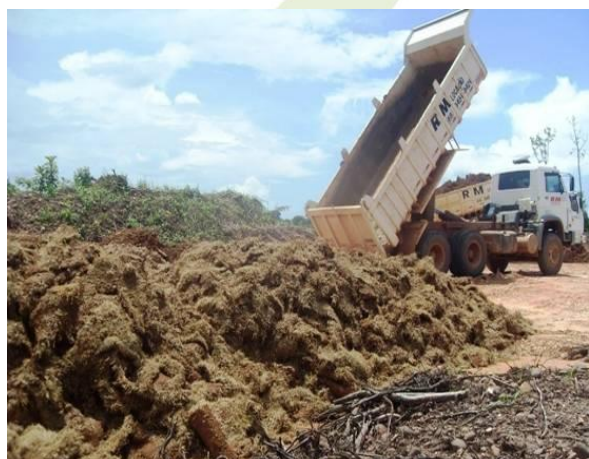
Foto 4.13.11 - Deposição da camada orgânica.
