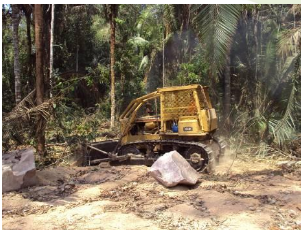
Foto 4.14.8 - Supressão de vegetação na área do futuro reservatório localizada no Canteiro de Obras (Set/2010).
