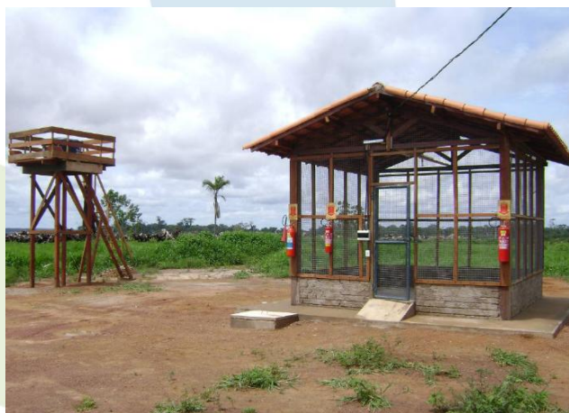
Foto 4.16.4 - Recinto de combustíveis na Base de Resgate do Canteiro de Obras (Nov/2010).
