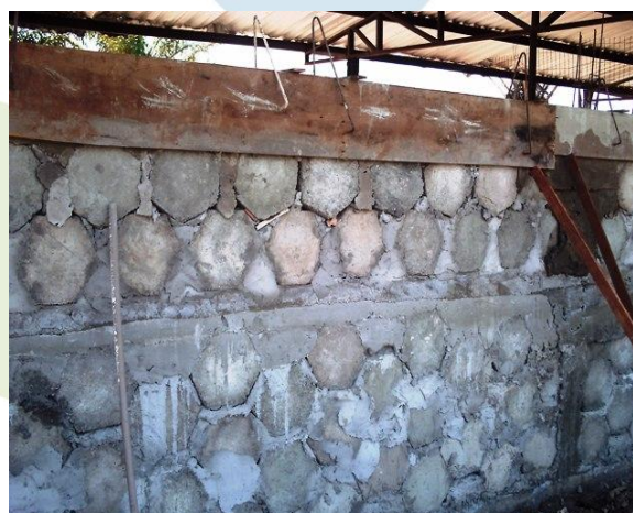
Foto 4.2.4 – Parede das baias com bloquetes
