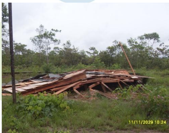
Foto 2.14.4 - Demolição das benfeitorias na área urbana de Mutum Paraná.
