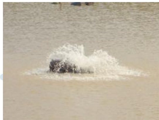
Foto 4.18.5 - Aerador de fundo em funcionamento no Recinto 4.
