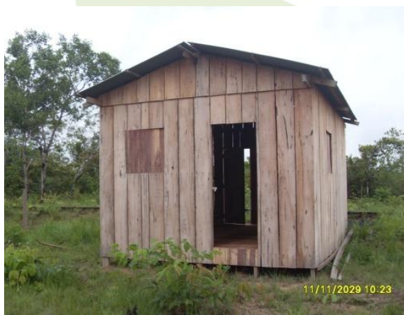
Foto 2.14.3 - Demolição das benfeitorias na área urbana de Mutum Paraná.
