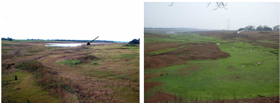
Figuras 19 e 20. PNB80. Ponto de referência demonstrado a pouca variação no nível do reservatório desde a campanha de outubro de 2010 (seta branca) em relação a presente campanha de fevereiro de 2011 (seta preta)
