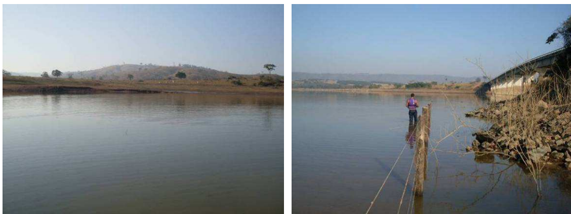
Figuras 9 e 10. Ponto de amostragem PIR10, rio Piracanjuba, próximo à ponte da rodovia GO-210.
