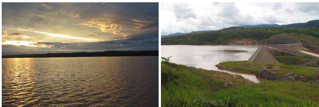
Figura 1. Detalhe do reservatório e da barragem da UHE Itapebi.
