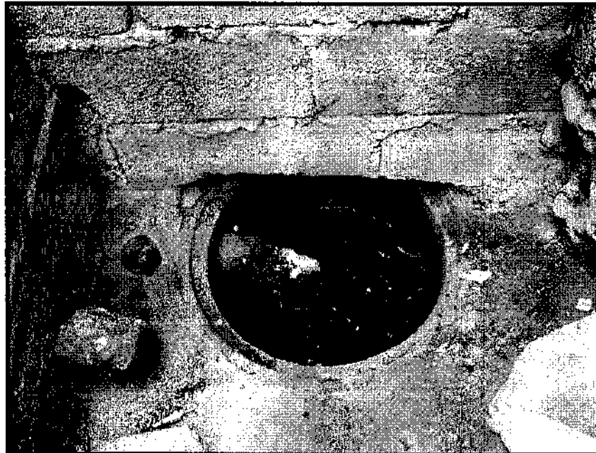
Foto 14: Detalhe da caixa de gordura do sistema de esgotamento da moradia nº 331 na Rua Porto Velho, onde há retorno do esgoto na época das chuvas
