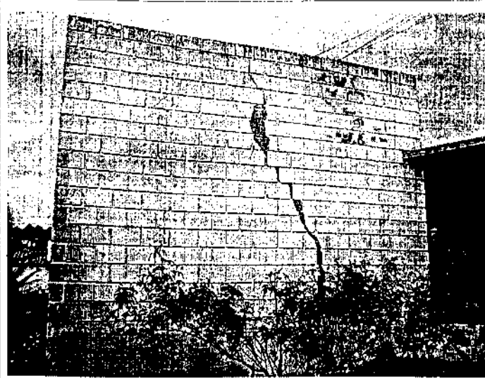
Foto 7: Detalhe de trinca na edificação.
