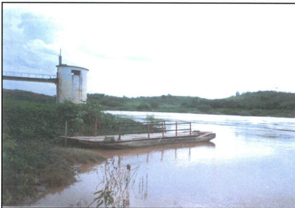
Foto 1 - Vista geral da balsa do Sr. Manoel Messias. Ao fundo, avista-se a torre da tomada d'água da COPASA.
