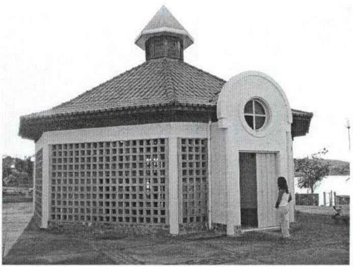
Foto 4: Lavanderia construída pela UHE Itapebi. Encontra-se abandonada.
