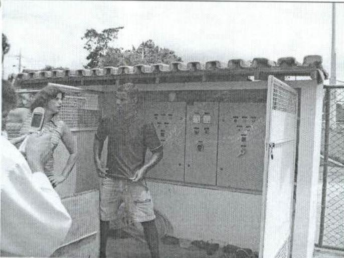
Foto 5: Quadro de comando das bombas de esgotamento.
