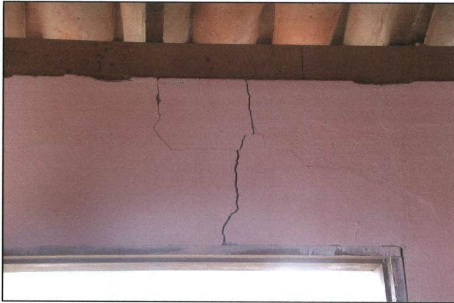
**Foto 6** – Trinca acima de janela – falta de verga e cintamento associados à concentração de cargas provocada pela peça do telhado (ver detalhe abaixo).
