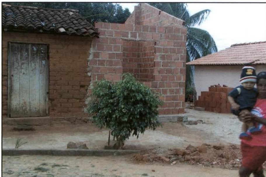
**Foto 12** – Ampliação de imóvel – uso de materiais distintos (adobe e blocos cerâmicos) cria zona de fissuração devido aos efeitos da dilatação térmica – mais uma vez a falta de verga sobre a janela.
