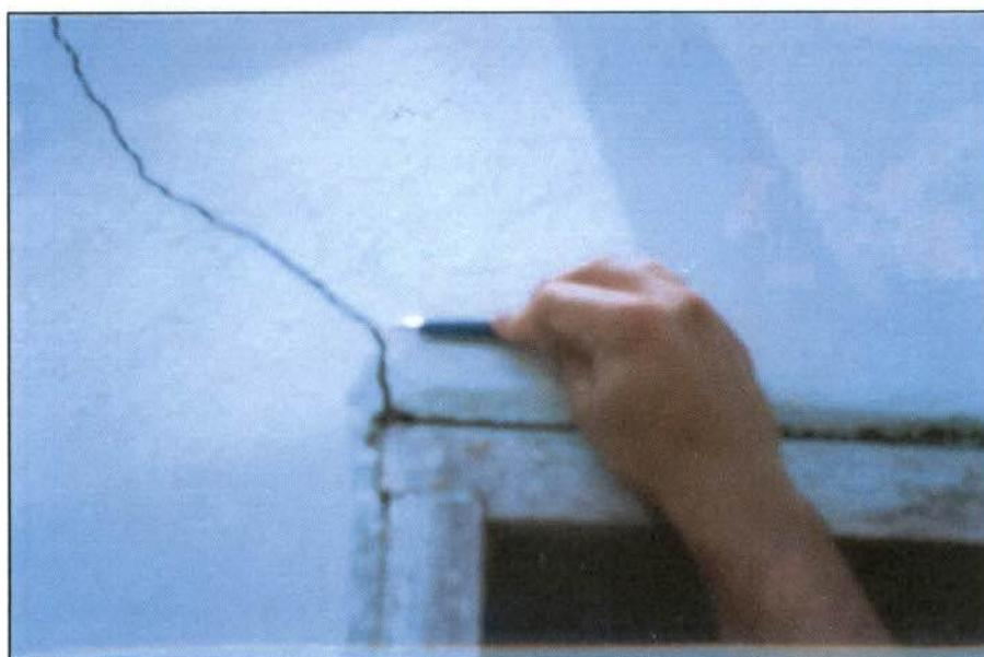
**Foto 3** – Detalhe de fissura - constatado preenchimento de tinta – evidência de que o problema é antigo.
