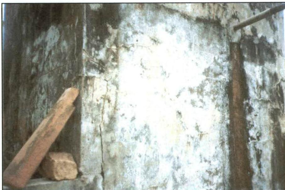
**Foto 4** – Fissura reclamada – proliferação generalizada de fungos, inclusive no interior das trincas – indicativo de que o problema é antigo.
