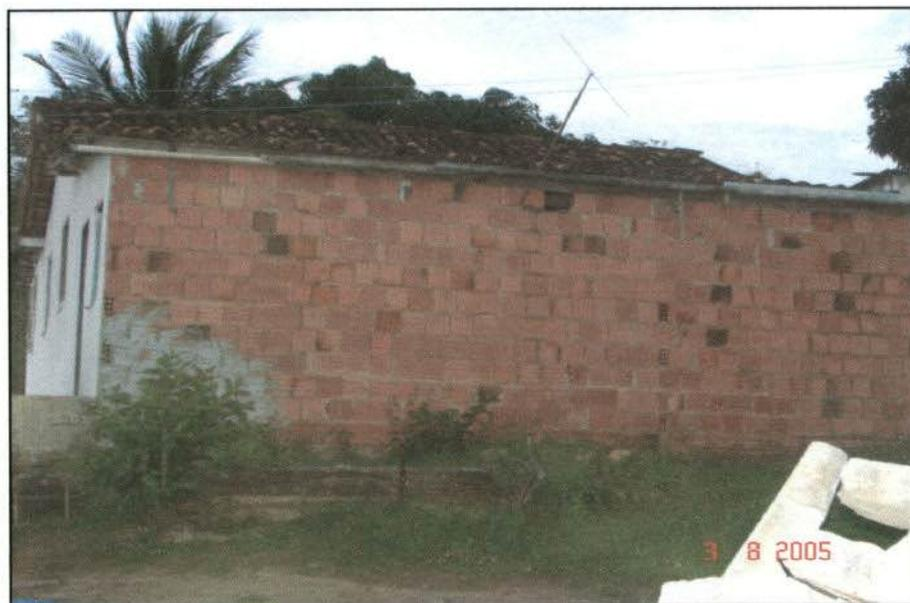
**Foto 10** – Blocos cerâmicos utilizados na posição errada para o levante de alvenaria – uma das causa da fissuração.
