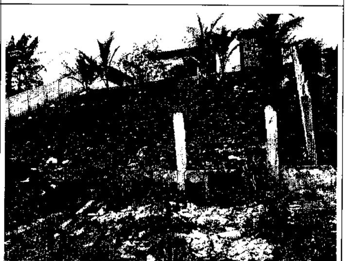
Foto 30: Muros danificados nas residências da Vila União.
