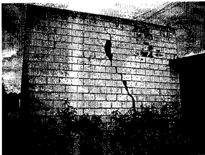
Foto 7: Detalhe de trinca na edificação.
