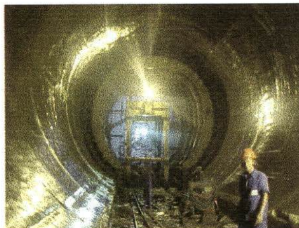
Vista do interior do Conduto 2
