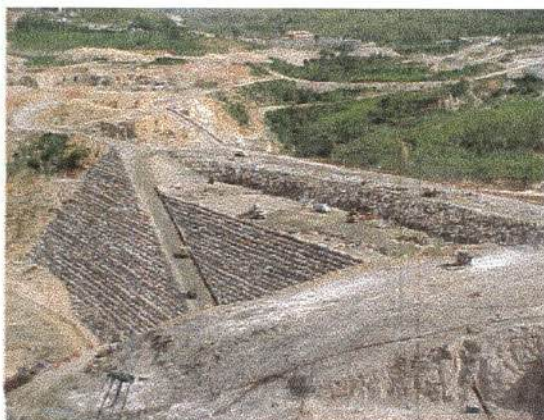
Vista do maciço por jusante
