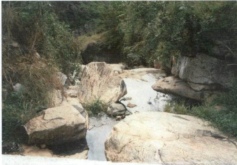
Figura 2-3 Córrego Lava-Pés – Vista do local do “off set” do aterro.
