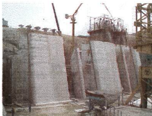
Vista frontal da Tomada D'Água
