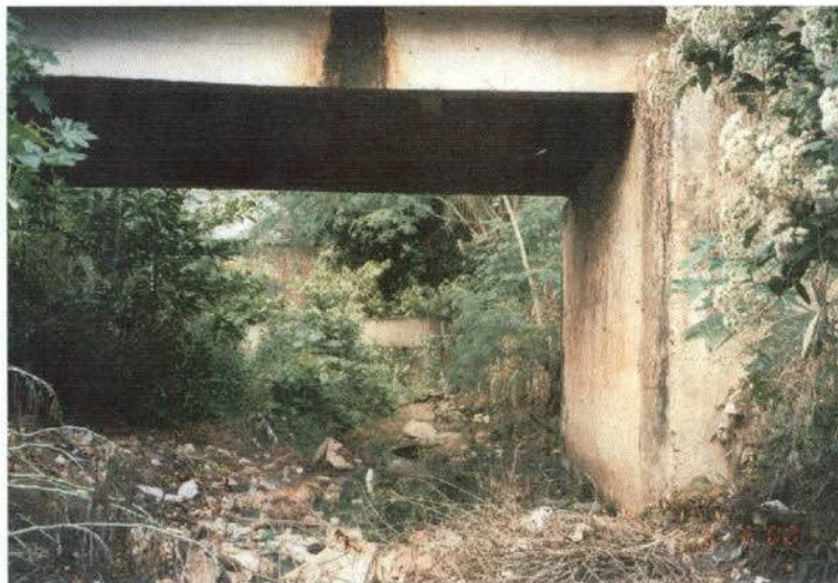
Figura 2-1 Vista de jusante da ponte sobre o Córrego Lava- Pés, rua Samuel Lima
