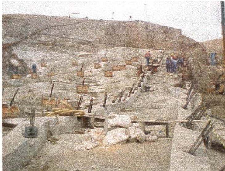
Estabilização da ombreira esquerda com tirantes protendidos
