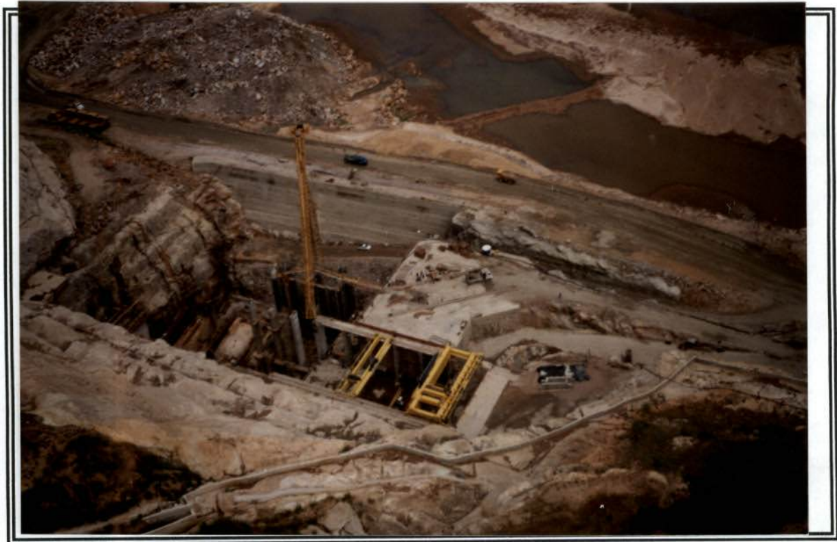
Escavação da Casa de Força, local possível para instalação do PCH de 25 MW.
