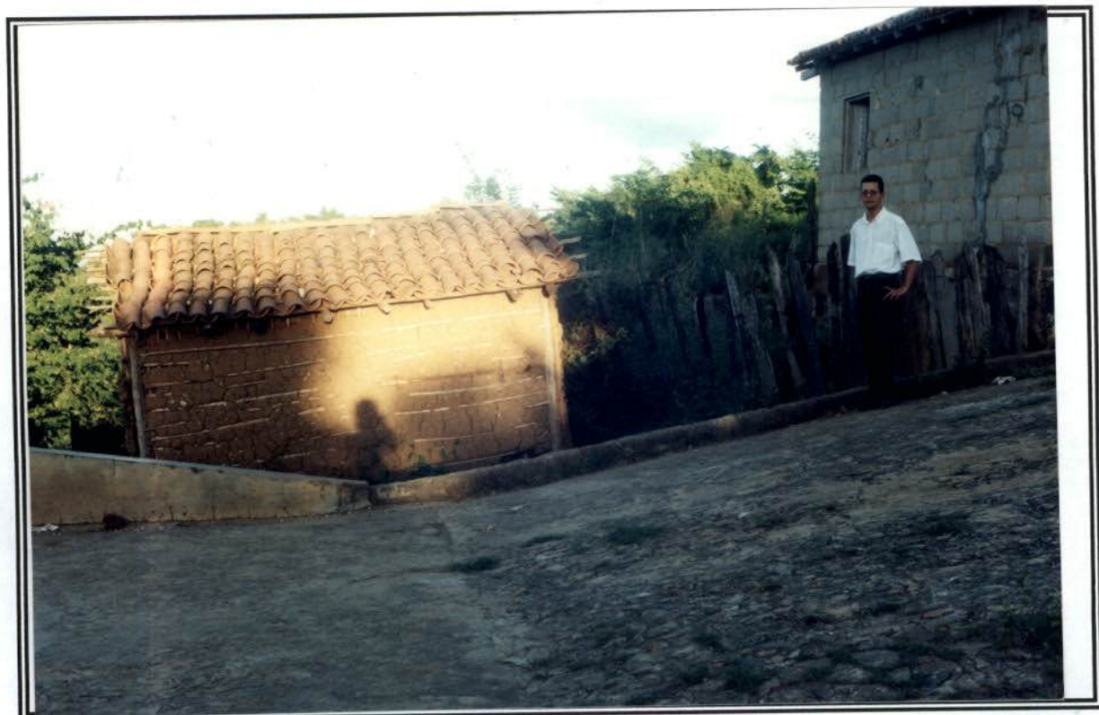
Residência atingida pela cota do reservatório na cota 110m.
