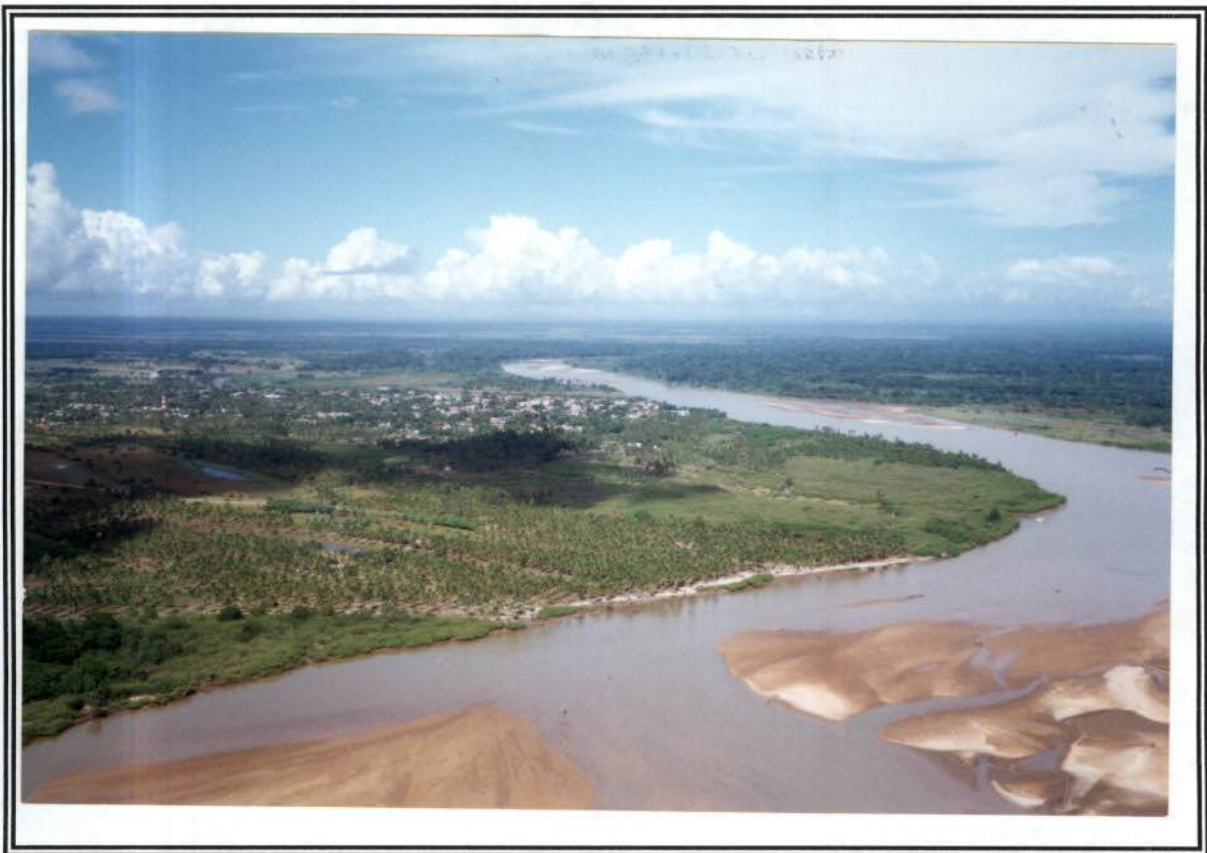
Cidade de Belmonte BA, notar plantação de coqueiro, erosão das margens comprometendo a cidade
