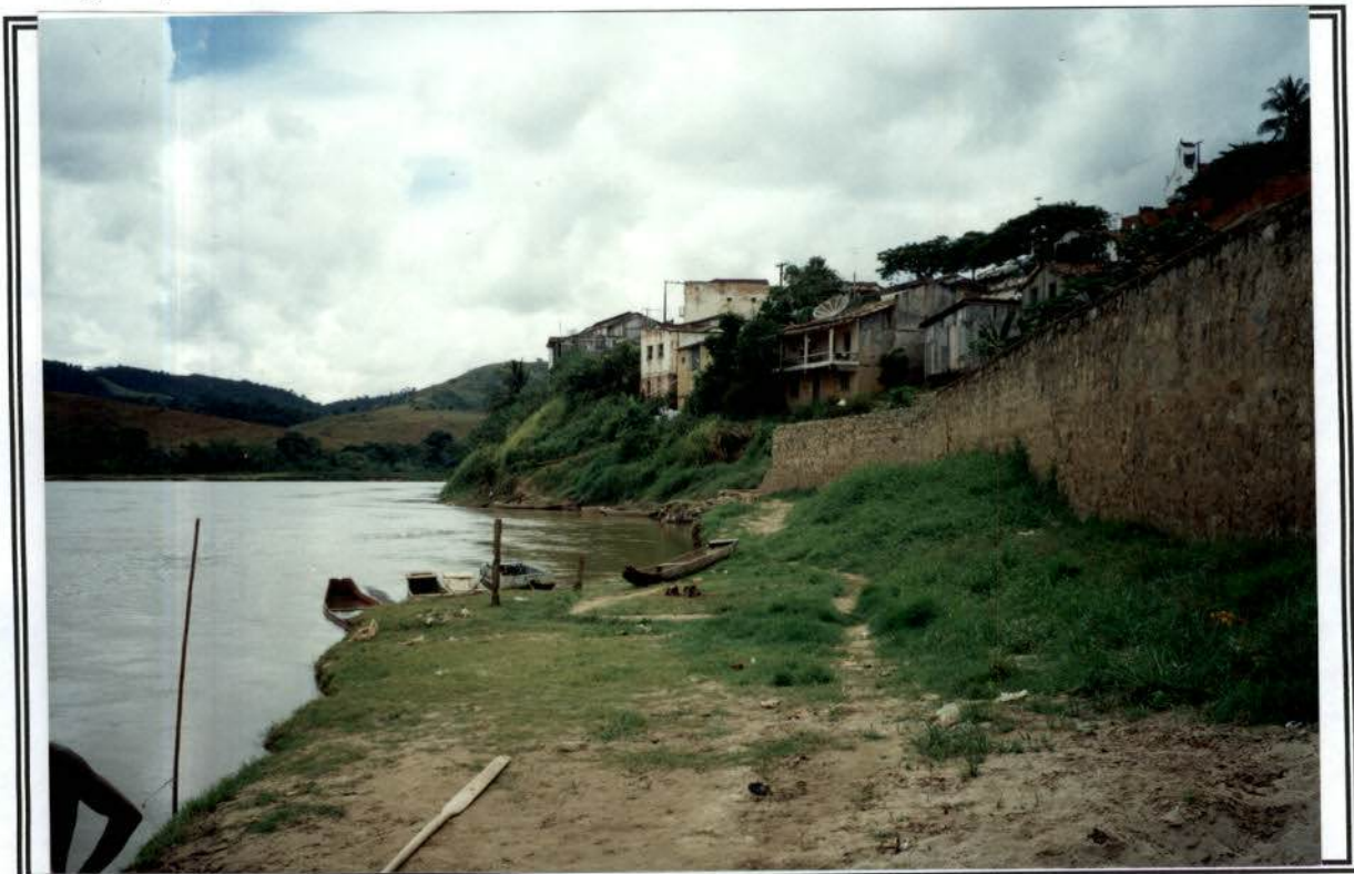
Moradia em Salto da Divisa atingida pela cota do reservatório na cota 110m
