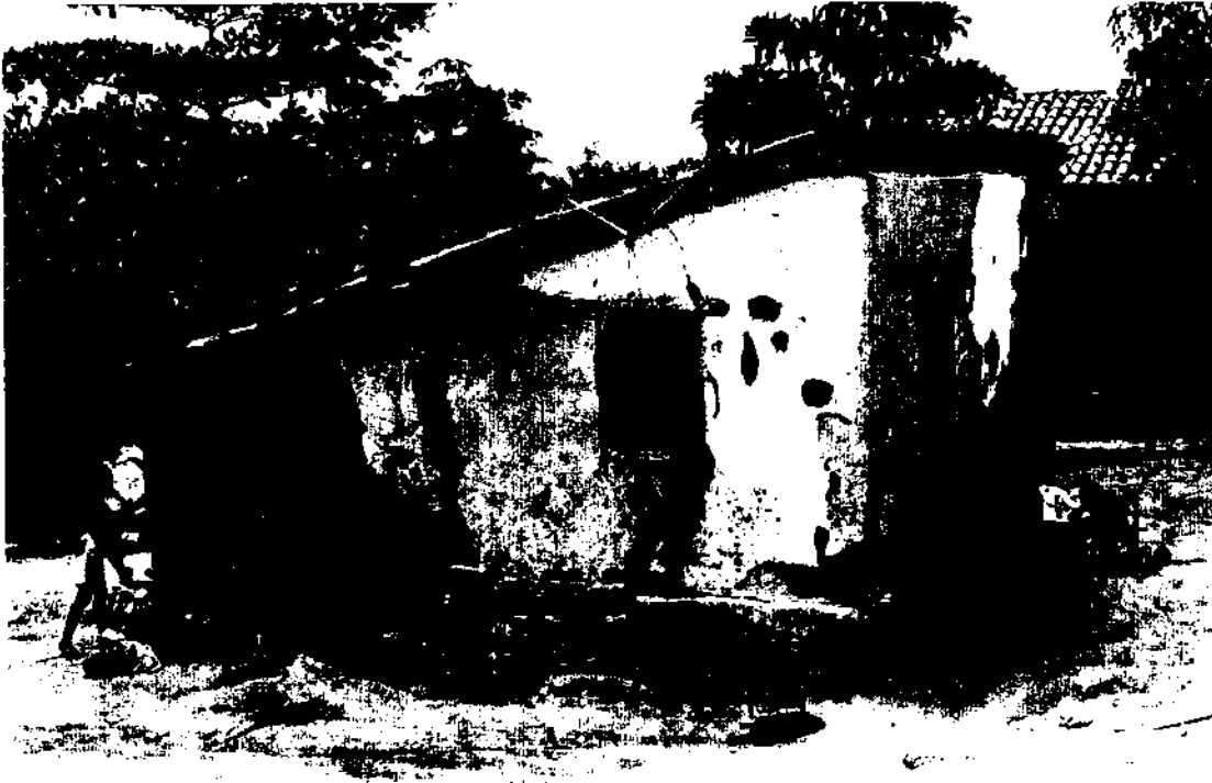
Foto nº 27: Moradia localizada à rua Beira Rio ( margem do Rio Jequitinhonha).
