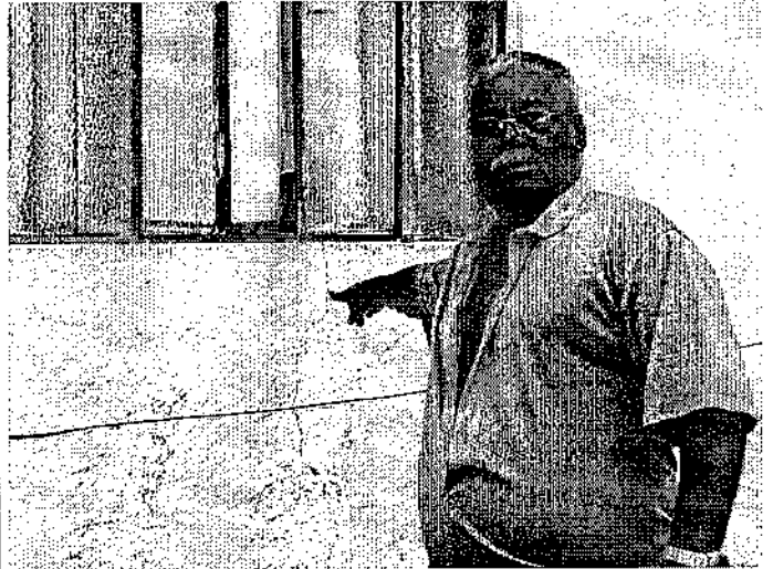
Foto 14: Sr. Ermazino Maurício dos Santos. Mora a aproximadamente 8 anos na residência. Quando mudou as trincas já existiam. Rua Clemente Martins, 173. Reclamou de carros pesados.
