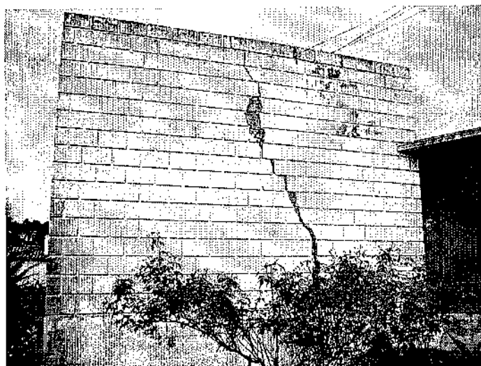
Foto 7: Detalhe de trinca na edificação.
