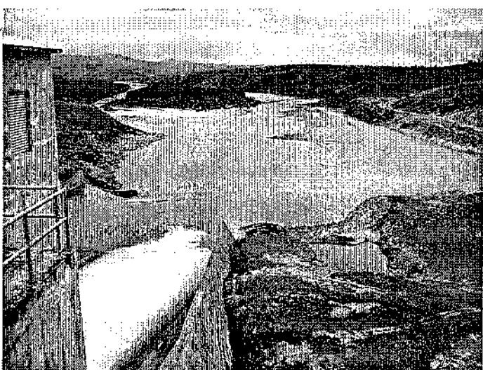
Foto 35: Vista da jusante da barragem.
