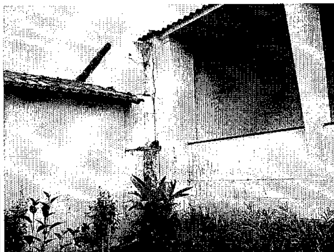
Foto 8: Detalhe de trinca na edificação.
