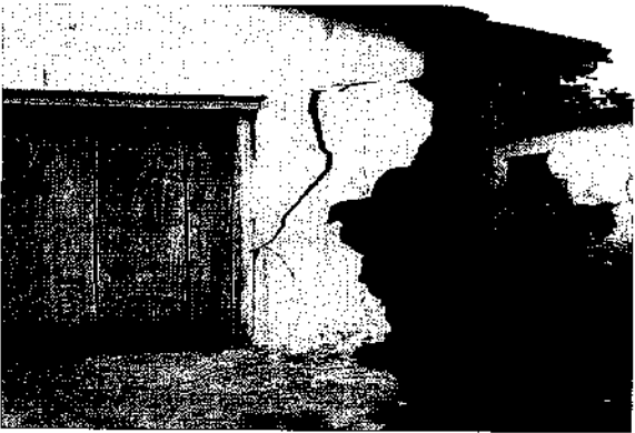
Foto 17: Detalhes das rachaduras da segunda casa visitada, município de Salto da Divisa, MG
