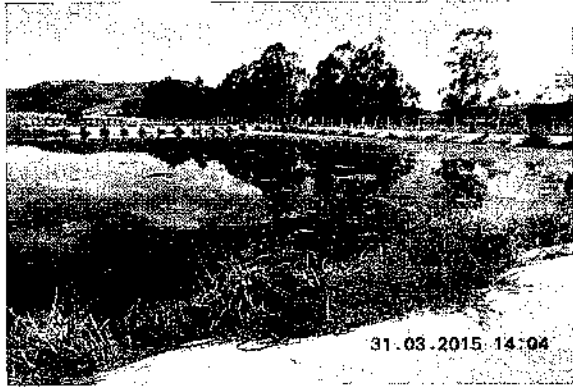
Foto 39: Estação de tratamento de esgoto (ETE, Salto da Divisa, MG)
