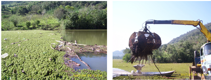
Figura 7.5 - Rio Jacutinga - Cabo de contenção e Retirada
