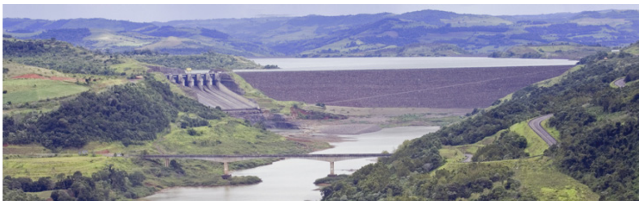
Figura 1-II: Barramento e vertedouro da UHE Itá
