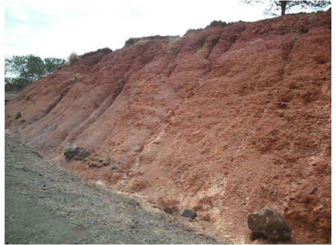
FIGURA 68 – Sulcos erosivos em talude de corte de antiga cava de mineração desativada, localizado em Aparecida do Taboado – MS, na área de influência direta do reservatório da UHE Ilha Solteira.
