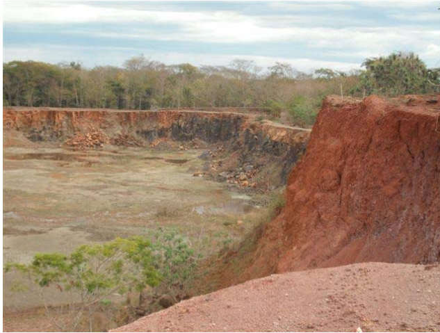
FIGURA 67 – Cava abandonada de extração de basalto em mineradora desativada, com desenvolvimento de sulcos erosivos nos taludes. Localiza-se em Aparecida do Taboado – MS, em área de influência direta do reservatório da UHE Ilha Solteira.
