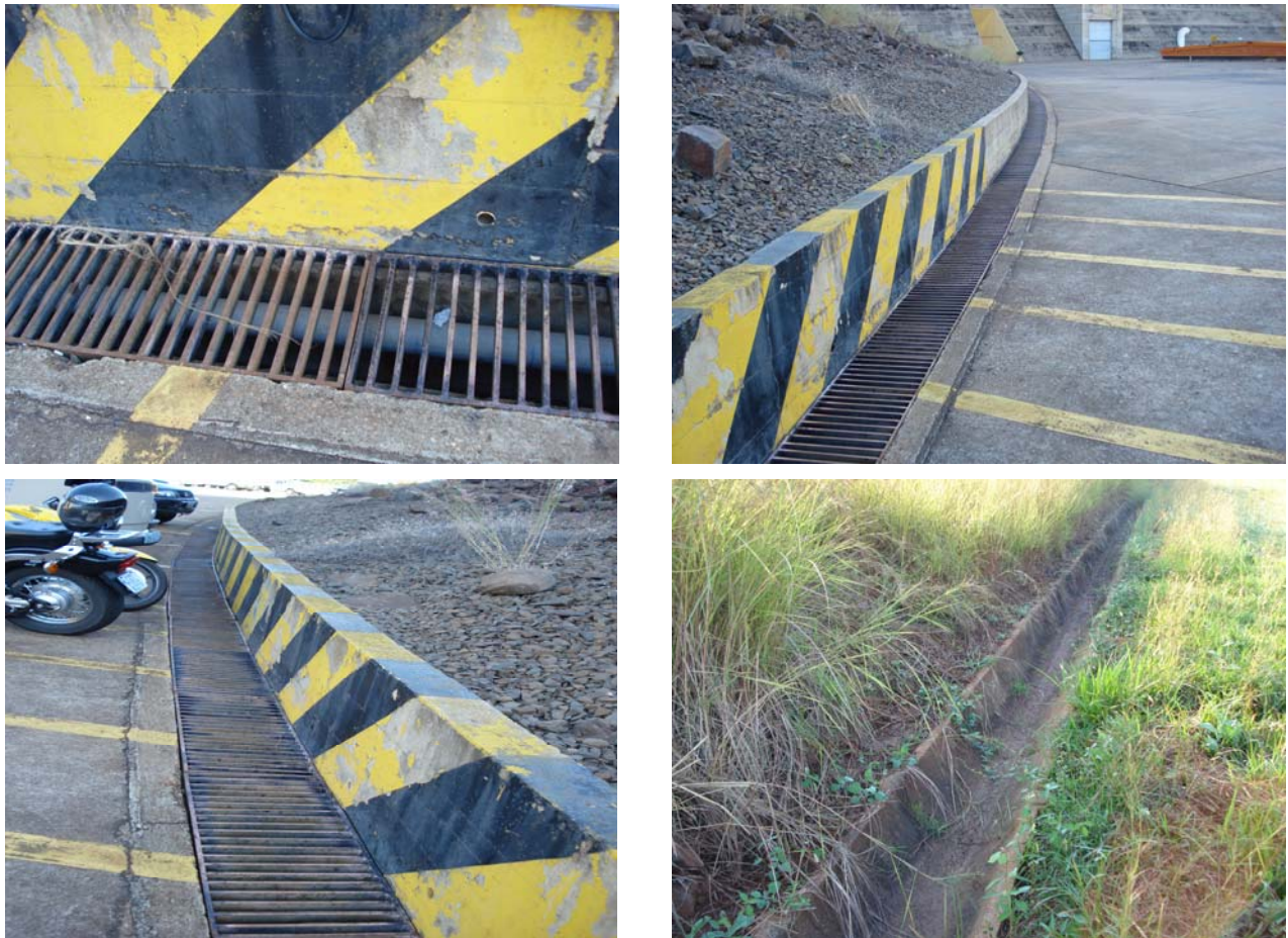
FIGURA 9 – Canaletas de águas pluviais na UHE Ilha Solteira.
