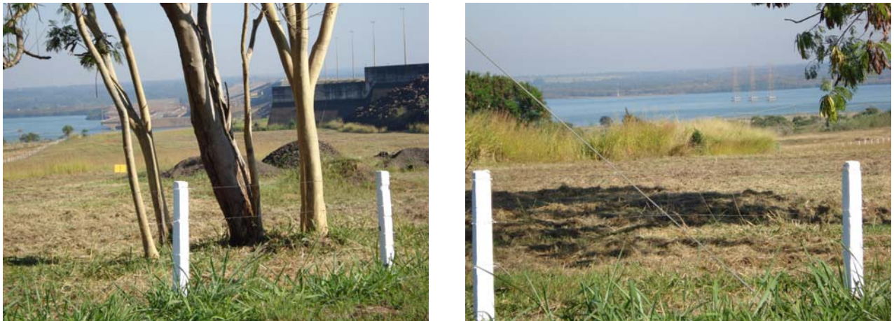
FIGURA 4 – Alguns palanques da UHE Ilha Solteira que serão caídos.
