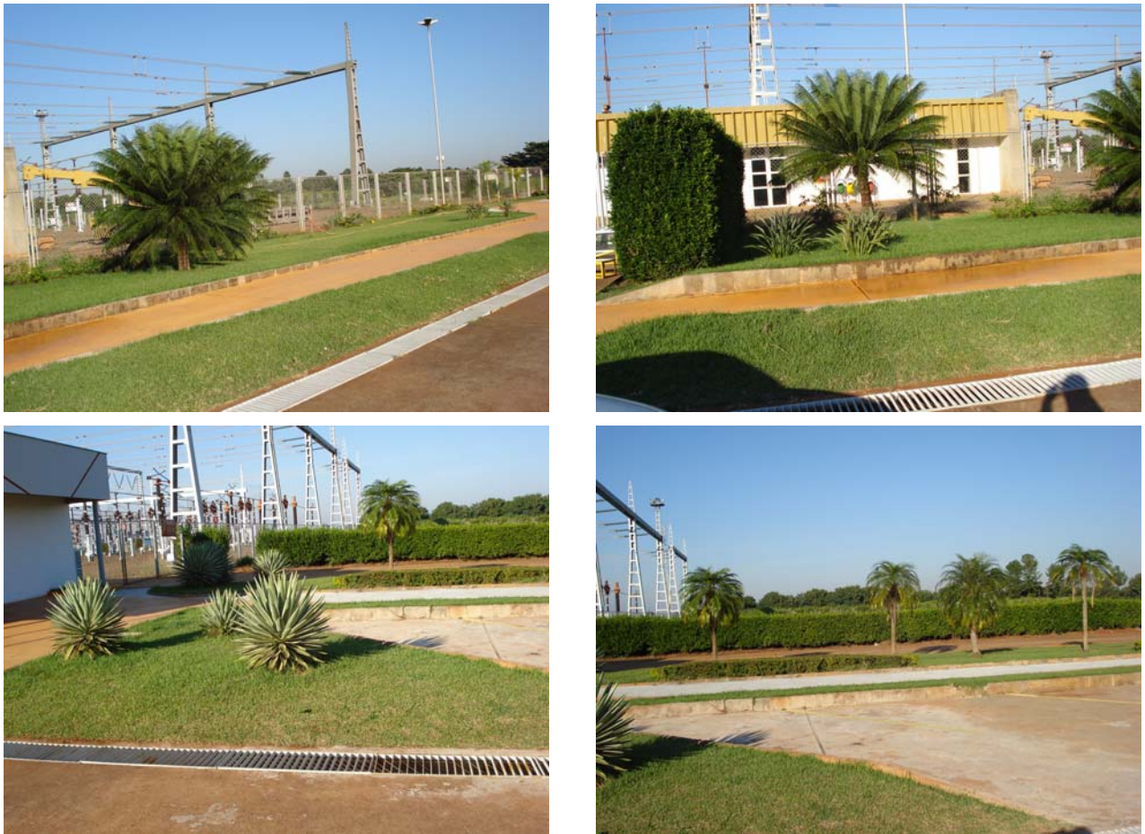
FIGURA 6 – Áreas da UHE Ilha Solteira que são conservadas com serviços de paisagismo.
