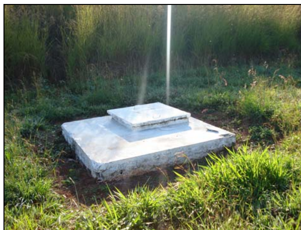
FIGURA 8 – Caixa de captação de água pluvial da UHE Ilha Solteira.
