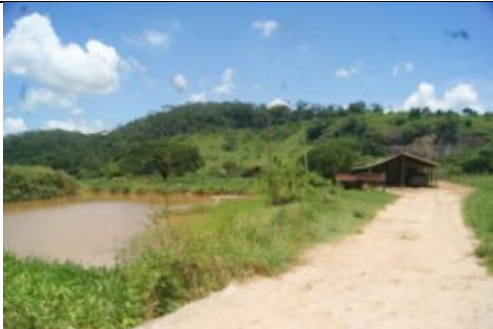
Figura 16: Planície de inundação com água acumulada devido a presença de estrada. Data: Fev/19.
