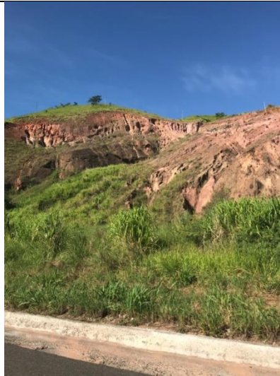
Figura 42: Erosão concentrada em sulcos identificada na AII do empreendimento. Data: 28/01/2019.
