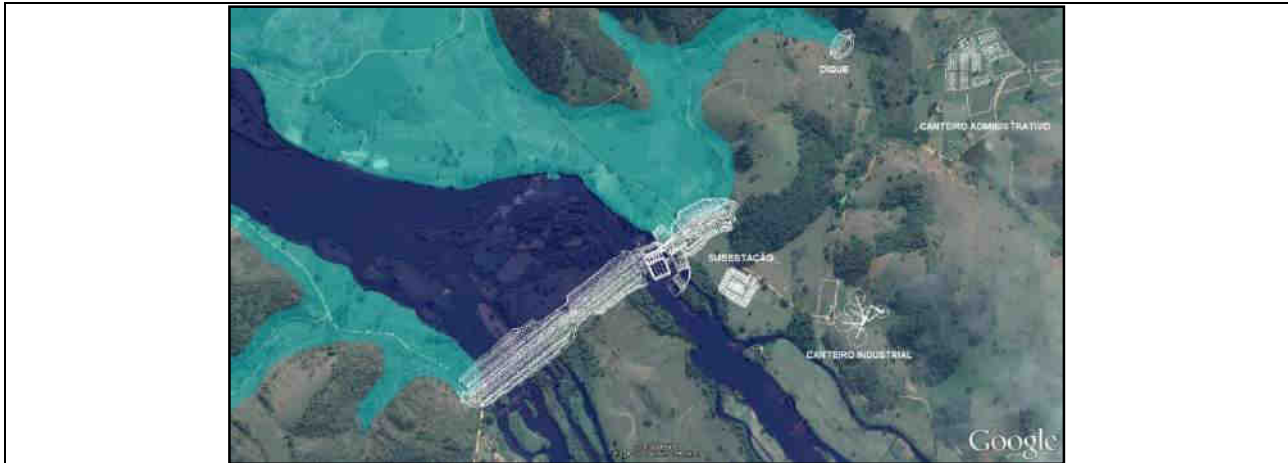
Figura 70: Barragem, Vertedouro e Casa de Força concluídas. Fonte: Ecology Brasil, 2017.
