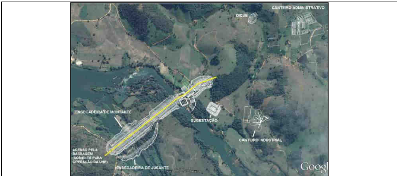
Figura 68: Desvio do Rio de 2ª fase – Execução da Barragem. Fonte: Ecology Brasil, 2017.
