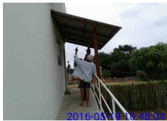
Fig. 17- Autor: MARLETTA.H 19/05/2016. Descrição: Cobertura na parte externa.
