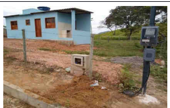
Fig. 31- Autor: VIEIRA P. 04/05/2016. Descrição: Vista frontal da casa pronta.
