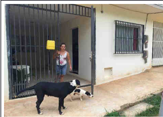
Fig. 24- Autor: FULY M.P 25//01/2016. Descrição: Fachada da residência.
