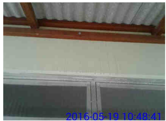
Fig. 18- Autor: MARLETTA.H 19/05/2016. Descrição: Cobertura em telha fibrocimento.
