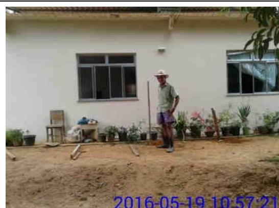
Fig. 10 – Autor: MARLETTA.H 19/05/2016. Descrição: Vista frontal da residência.
