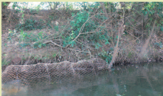
Redes do tipo "Fike-nets" instaladas na área de implantação da UHE Itaocara.
