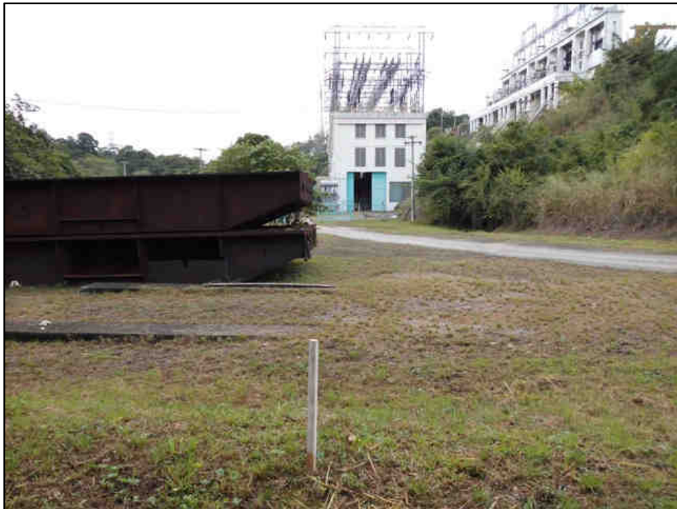
Figura 2: Ponto de Apoio P-01
