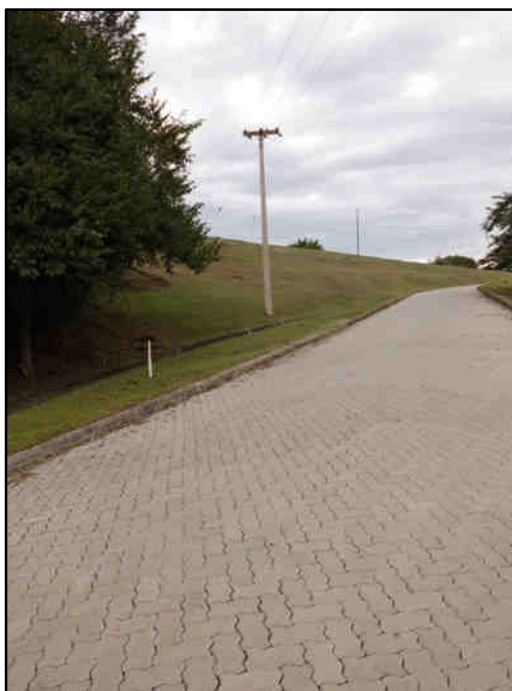
Figura 3: Ponto de Apoio P-02
