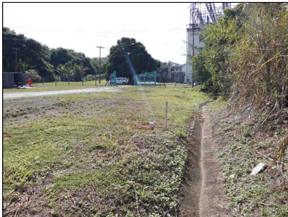
Figura 25: Pórtico - Ilha dos Pombos
