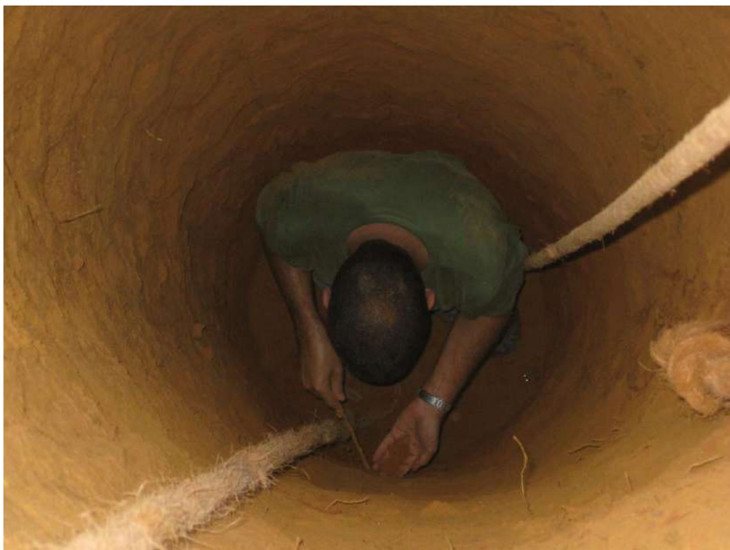
Foto 15 – Inspeção de poço (PEC-05) na margem esquerda.
