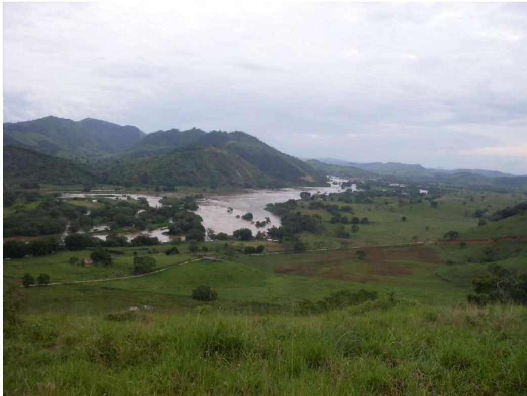
Foto 9 – Vista da margem esquerda para montante na região do eixo.
