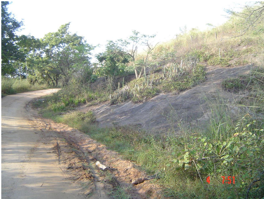
Foto 11 – Afloramento de rocha na ombreira direita.
