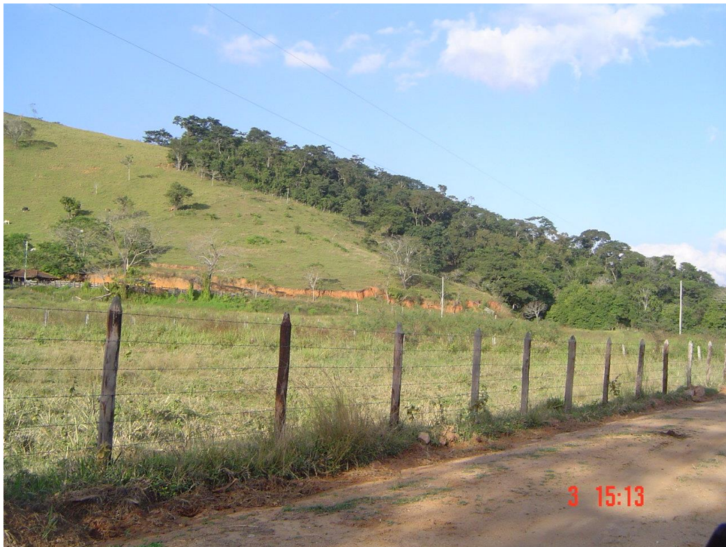
Foto 5 - Vista de montante pra jusante da ombreira esquerda do barramento.
