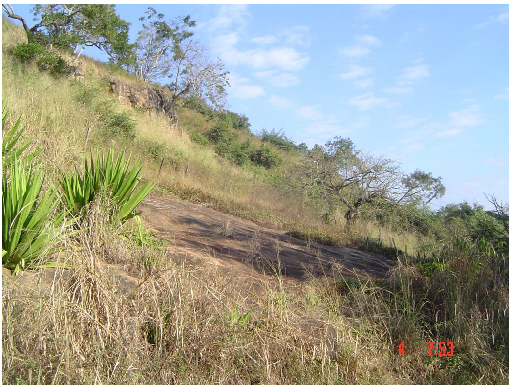
Foto 12 – Afloramento de rocha na ombreira direita.
