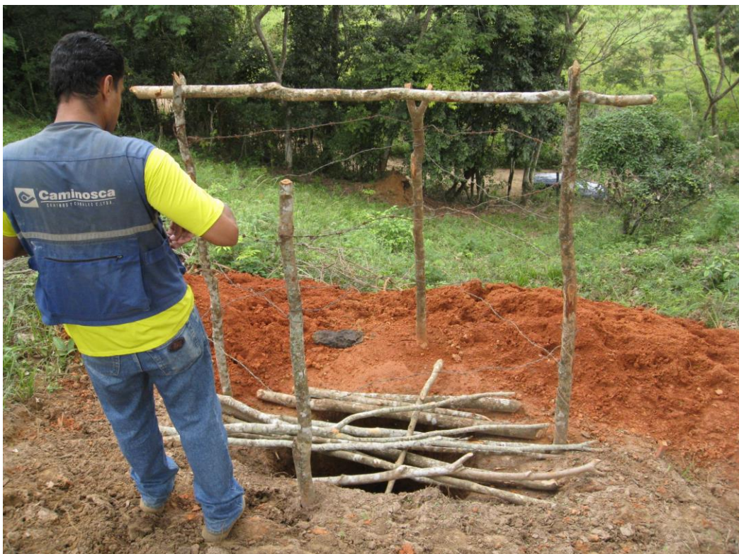
Foto 14 – Poço de Inspeção (PI-02) na margem esquerda.
