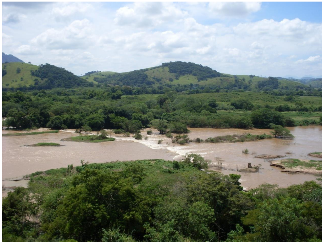
Foto 3 – Vista da margem direita para a margem esquerda no eixo do barramento.
