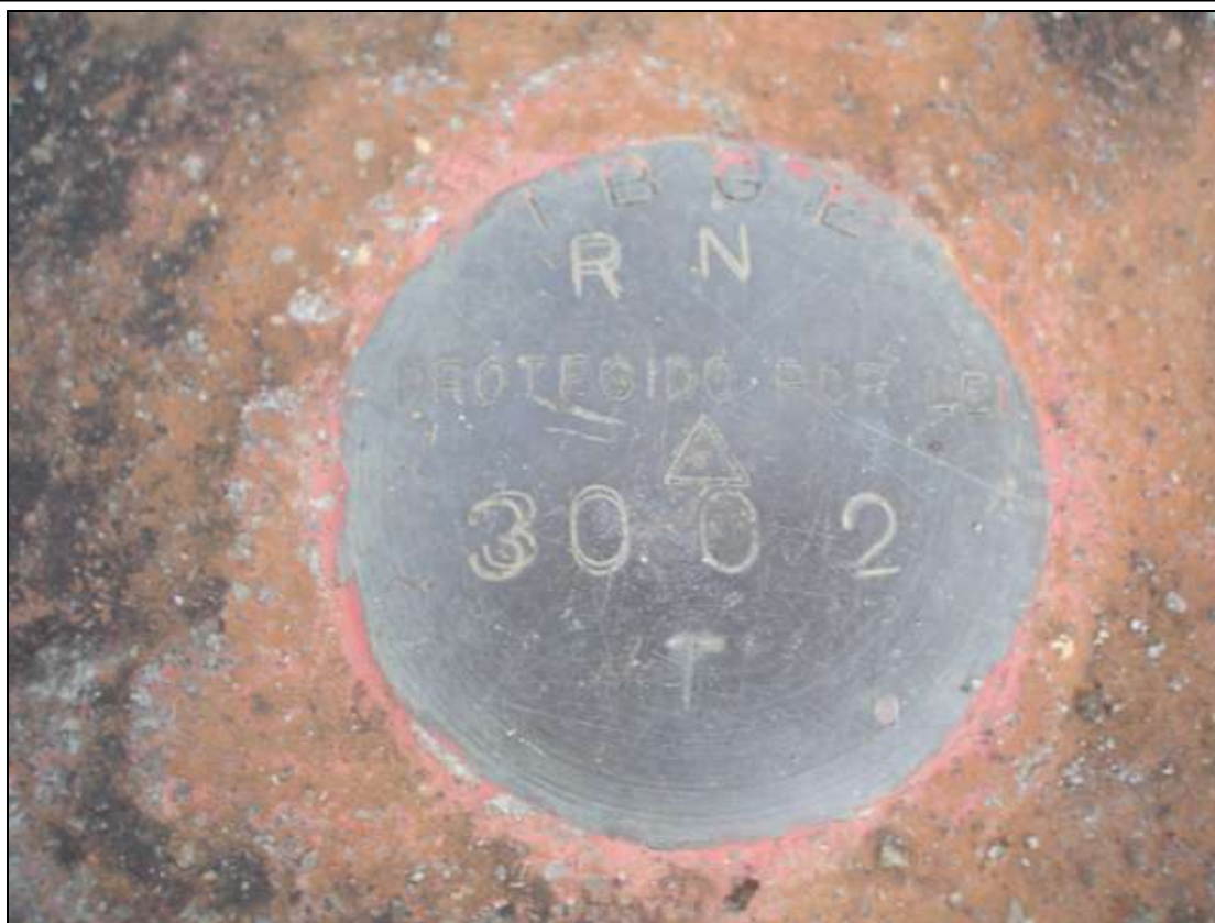
Foto 25. Marco do IBGE na UHE Ilha dos Pombos - RN 3002 T
