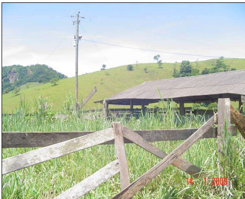
Foto 12. Vista da margem esquerda do Rio Paraíba do Sul - galpão
