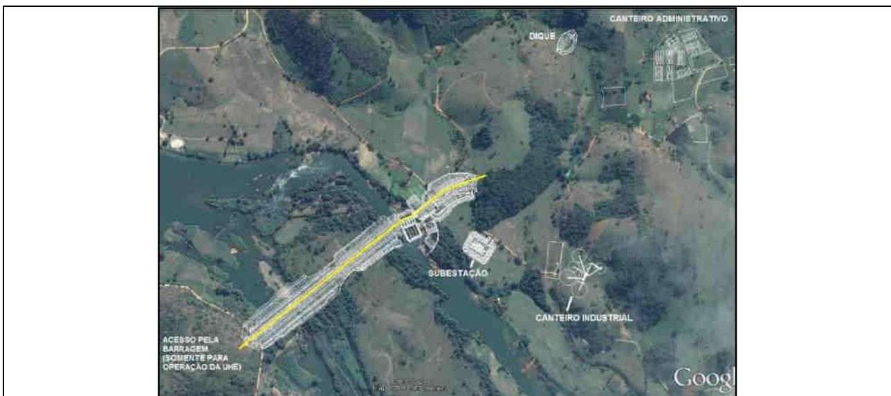
Figura 69: Desvio do Rio de 2ª fase – Execução da Barragem – Retirada das Ensecadeiras. Fonte: Ecology Brasil, 2017.
