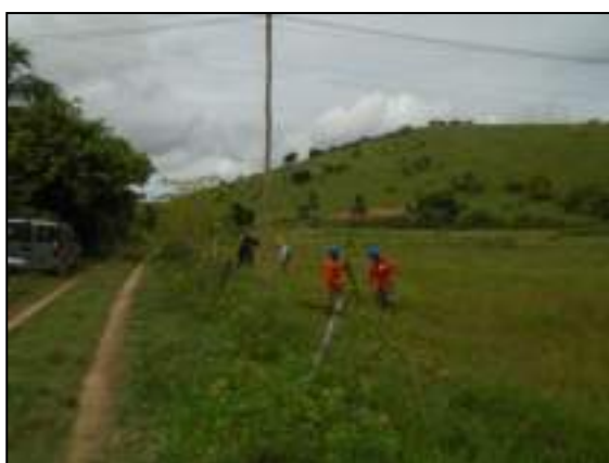
Imagem 7.1.1-9 Equipe durante execução das intervenções preliminares.
