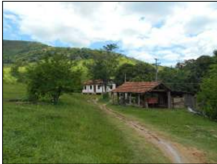
Figura 3.2.1.2 – Vista geral da sede da propriedade IT 68A. Coordenadas UTM 787580 E, 7597127 N.
