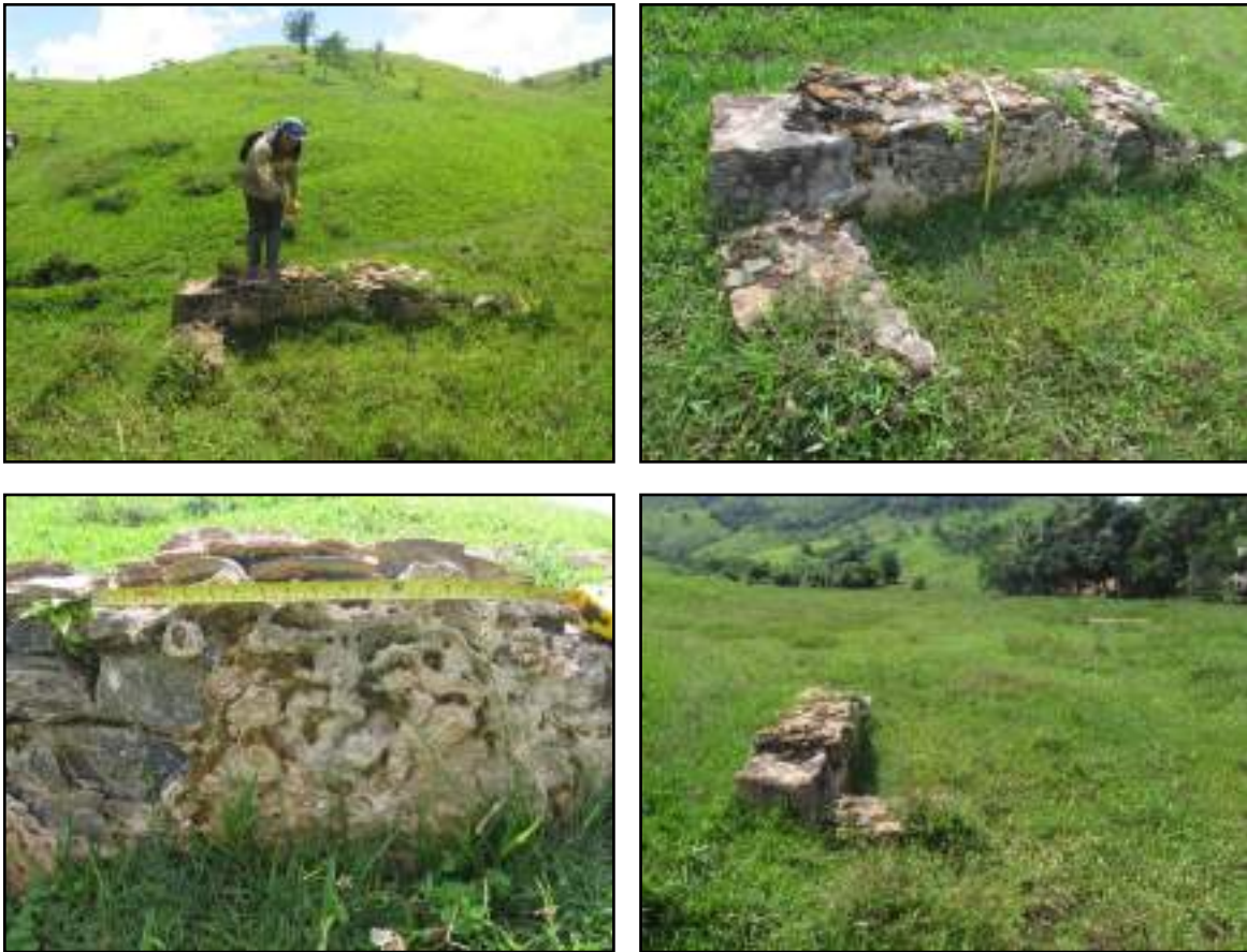
Figura 3.2.1.8 – Restos de alicerces com argamassa e cacos de telhas. Coordenadas UTM 787492 E, 7597514 N.
