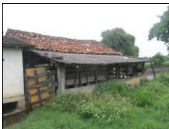
Figura 3.2.2.5 – Complementação da cobertura com telhas mais recentes. Coordenadas UTM 781597 E, 7596023 N.
