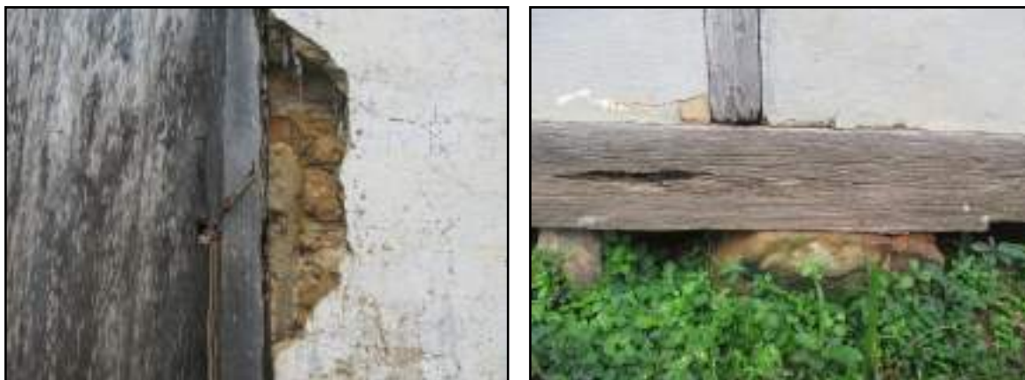
Figura 3.2.2.3 – Detalhes das estruturas. Pau-a-pique e alicerce de pedra. Coordenadas UTM 781597 E, 7596023 N.
