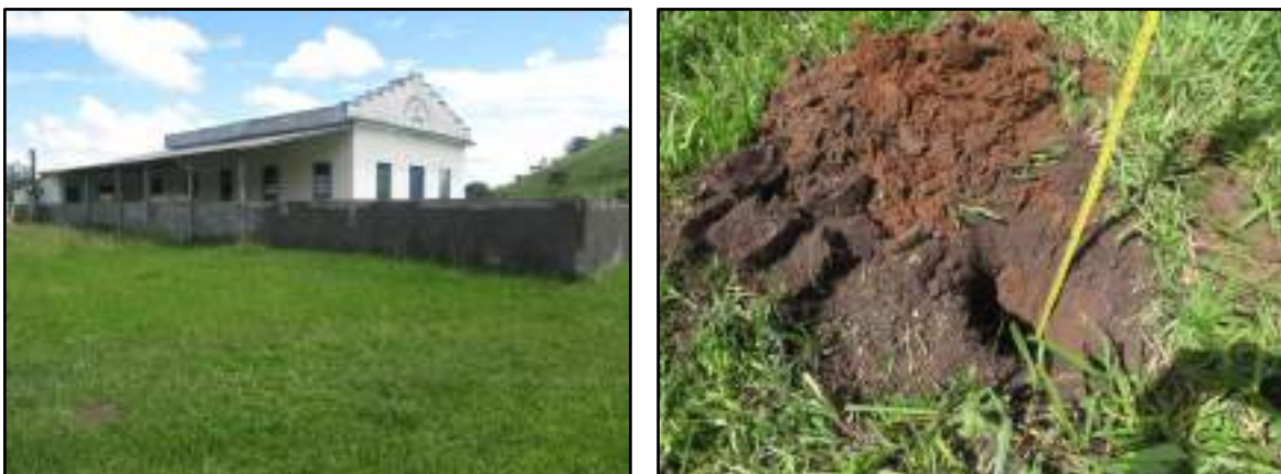
Figura 3.1.23 – Vista da Igreja da Assembleia de Deus e tradagem. Propriedade CG 50. Coordenadas UTM 782762 E, 7595572 N.
