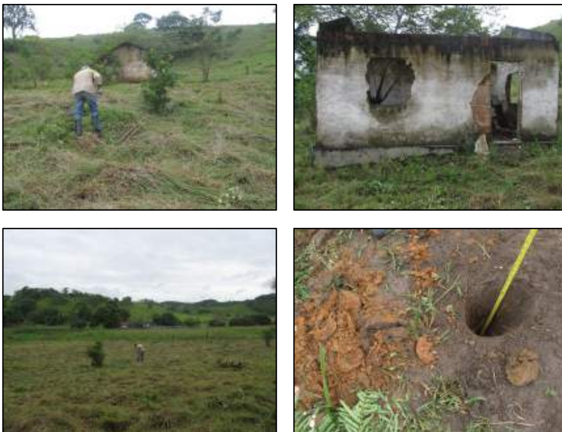
Figura 3.1.11 – Registro de edificação recente em ruínas e tradagem. Propriedade PA 125. Coordenadas UTM 784446 E, 7597845 N.
