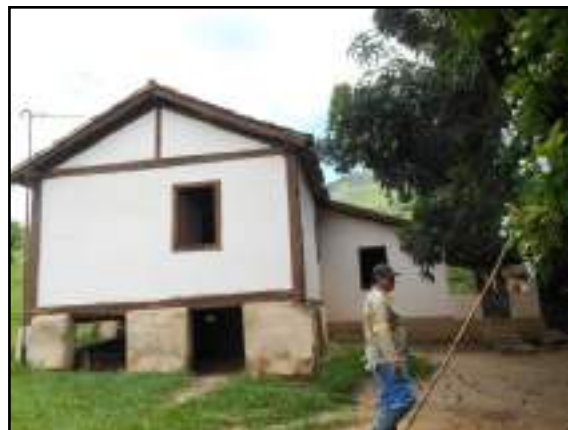
Figura 3.2.1.3 – Edificação principal da sede da fazenda. Coordenadas UTM 787580 E, 7597127 N.
