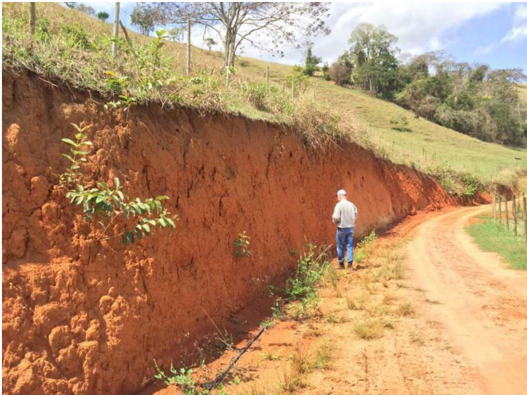
Figura 4.55 - Perfil de Material Coluvionar em Corte na Estrada da Margem Esquerda a Montante do Eixo do Barramento.
