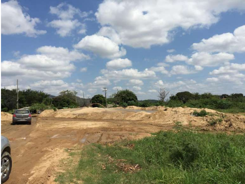
Figura 4.57 - Areal Existente na Margem Esquerda a Jusante do Barramento.
