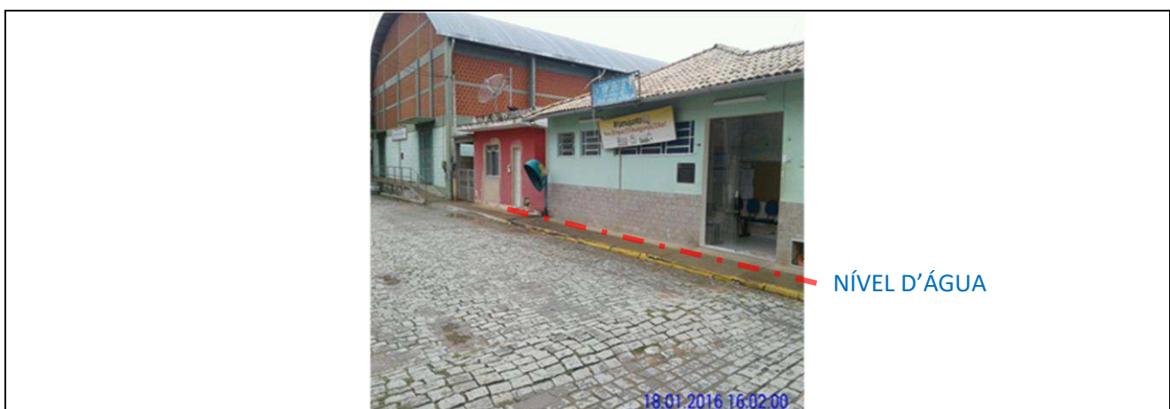
Figura 53: Nível d'água (linha tracejada vermelha) atingido na área central do distrito de São Sebastião do Paraíba, próximo ao Ginásio Poliesportivo, inserido na área de risco R2-Médio (Coloração amarela no mapa de risco de inundação). Fonte: UHE Itaocara S.A., 2016.
