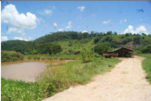
Figura 16: Planície de inundação com água acumulada devido a presença de estrada. Data: Fev/19.
