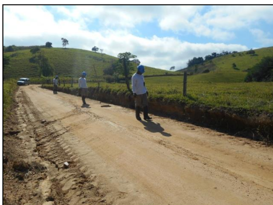
Imagem 8.1-3 Equipe realizando levantamento em área de corte da estrada.
