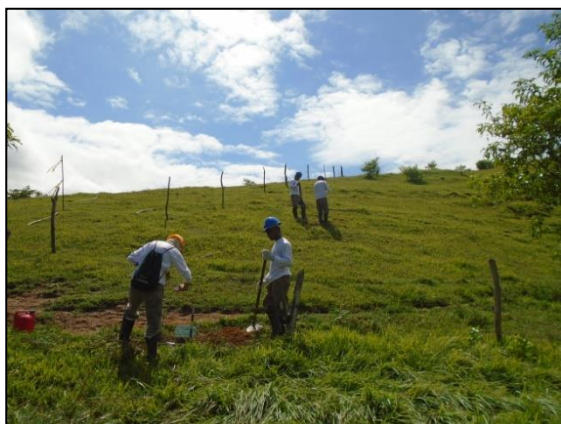
Imagem 7.1.1-1 Equipe executando intervenções em linha
