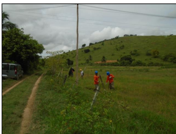
Imagem 7.1.1-9 Equipe durante execução das intervenções preliminares.
