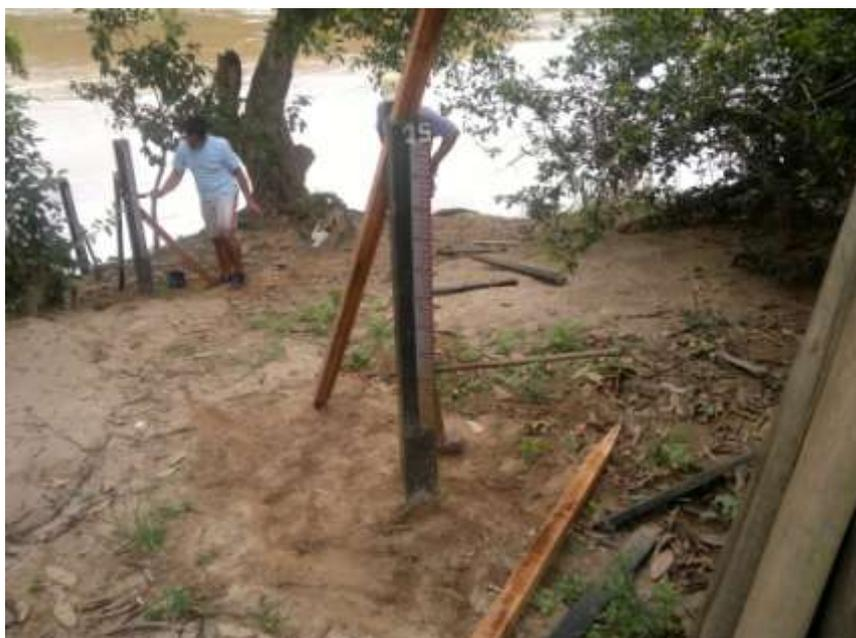
Foto 20 – Substituição, manutenção e pintura dos lances de réguas da estação Itaocara II São Sebastião do Paraíba no rio Paraíba do Sul.
