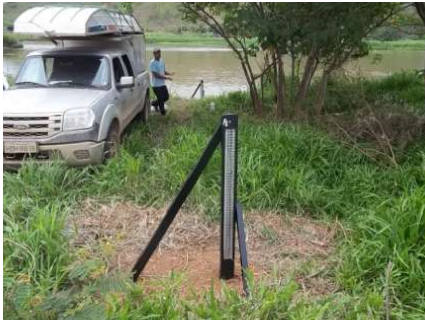
Foto 10 – Vista geral do local de instalação da estação Itaocara Roda D'água no rio Paraíba do Sul.
