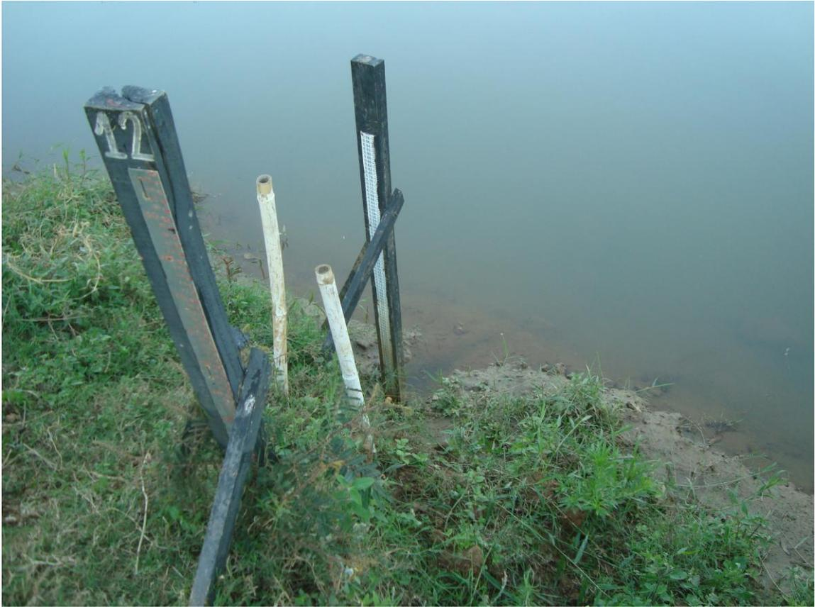
**Foto 01** – Reinstalação dos lances de régua da estação fluviométrica de Fazenda Atoleiro no rio Paraíba do Sul.
