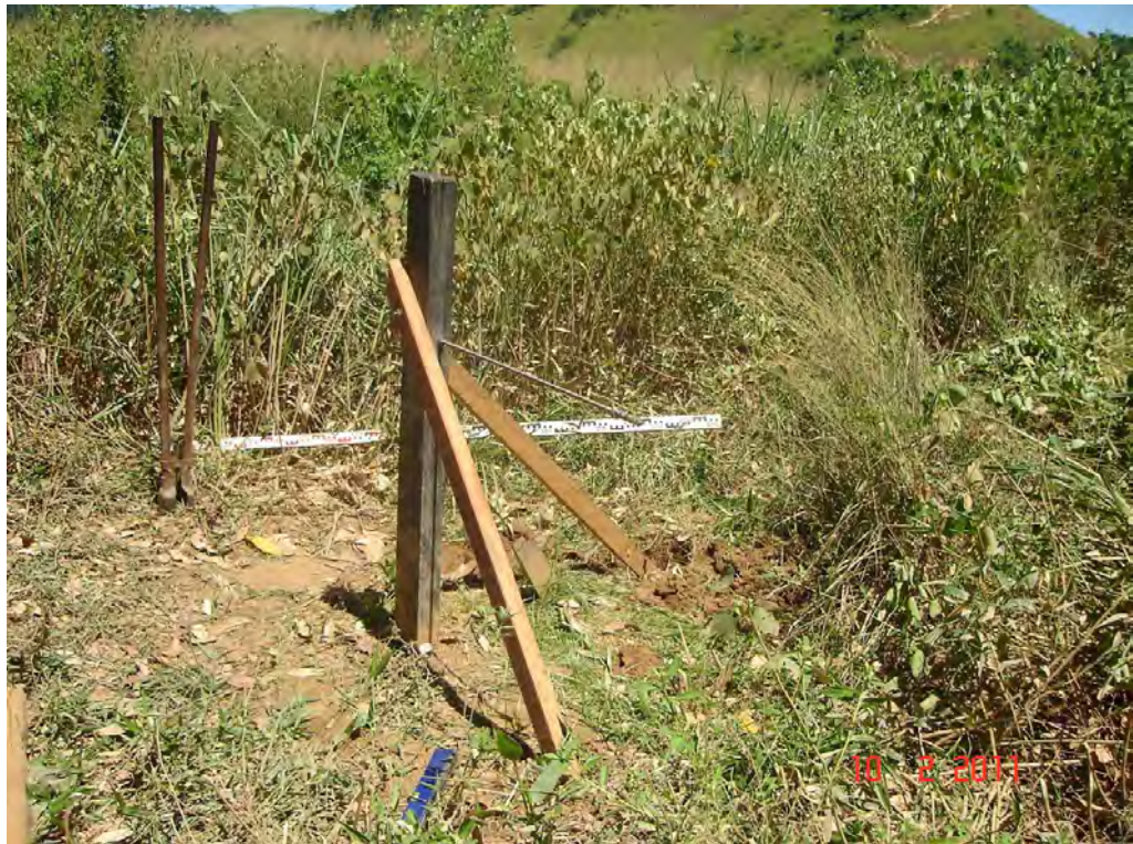
Foto 09 - Reinstalação do lance de réguas 18,00 a 19,00 da estação fluviométrica de Itaocara II Formiga Montante.
