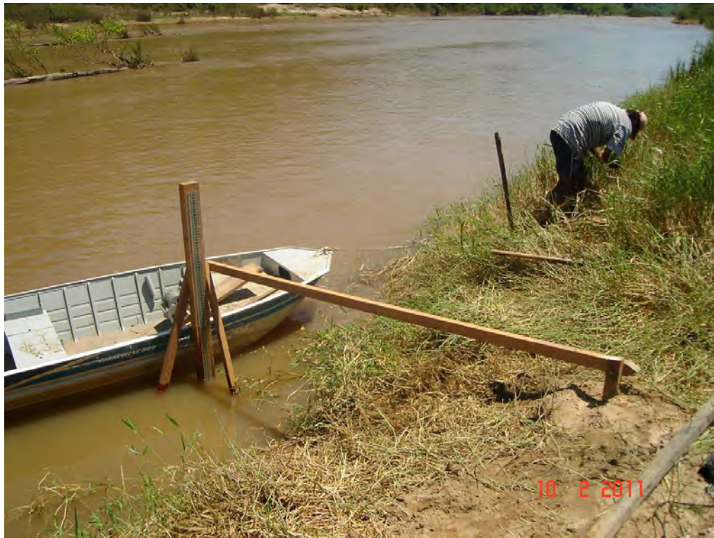
Foto 07 – Reinstalação do lance de réguas 16,00 a 18,00 da estação fluviométrica de Itaocara II Formiga Montante.
