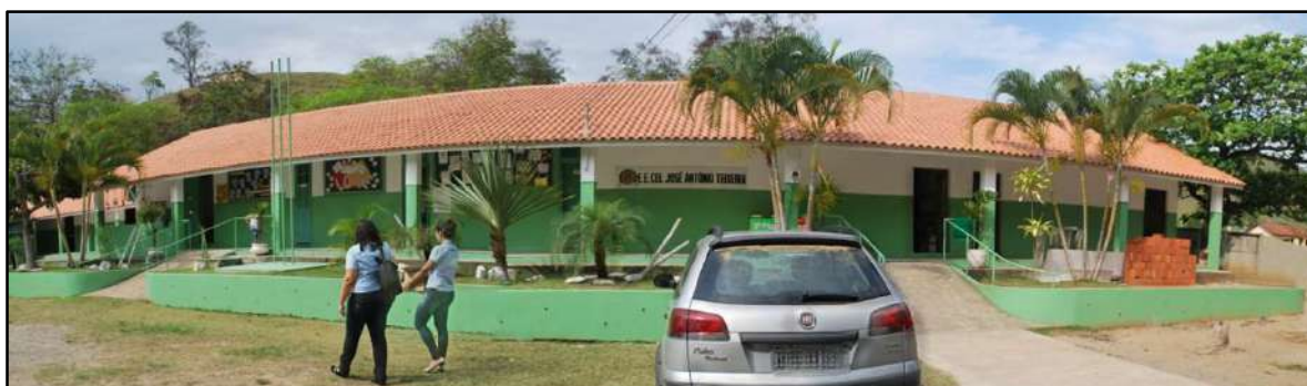
Figura 3.5.5.1 – Fachada da E.E. Cel. José Antônio Teixeira. Localidade de Batatal, Itaocara, RJ.
