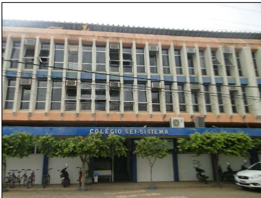
Figura 3.5.5.1 – Fachada do SEI. Sede de Itaocara, RJ.
