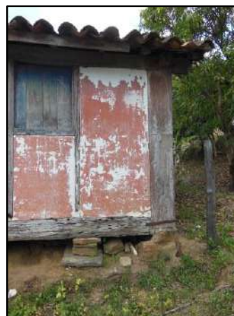
Figura 3.4.2.4.1.2 – Aspectos da edificação. Lateral e blocos rochosos de sustentação na parte frontal. Coordenadas UTM 777332 E, 7593041 N.
