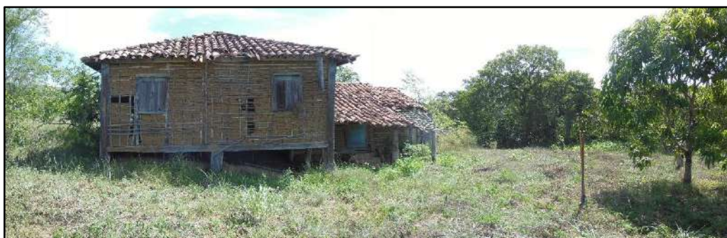
Figura 3.4.2.4.9.2 – Edificação de pau-a-pique. Coordenadas UTM 781549 E, 7595446 N.
