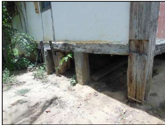
Figura 3.4.2.4.1.3 – Detalhe do esteio que aparenta ser reutilizado.
