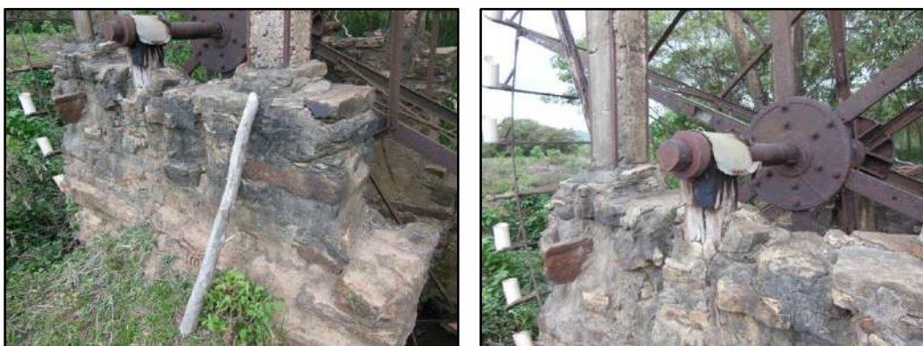
Figura 3.4.2.1.1.2 – Base da roda d'água feita com blocos rochosos. Coordenadas UTM 773421 E, 7593715 N.
