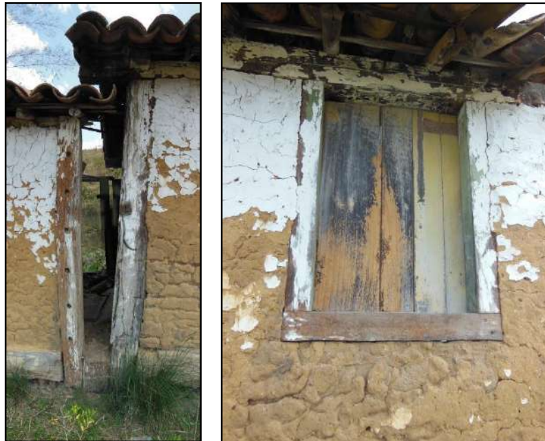
Figura 3.4.2.4.4.3 – Vão na edificação e detalhe da janela.
