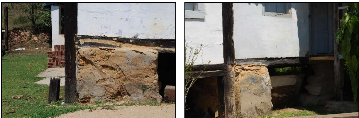
Figura 3.4.2.2.6.5 – Detalhe das estruturas de sustentação da sede em rocha e argamassa similar a saibro.
