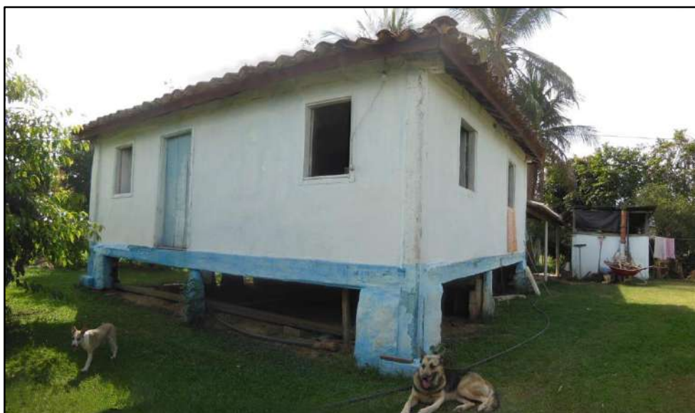
Figura 3.4.2.4.10.1 – Edificação principal da AIC 13. Coordenadas UTM 782863 E, 7596065 N.
