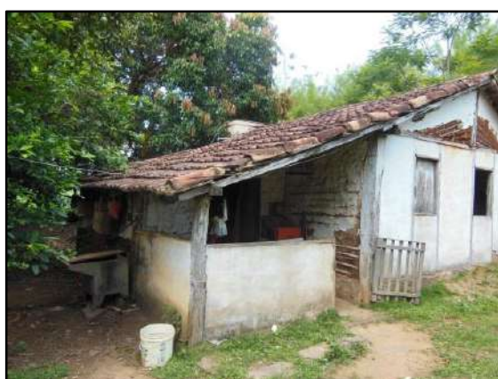
Figura 3.4.2.4.14.1 – Detalhes do telhado e estrutura de pau-a-pique.
