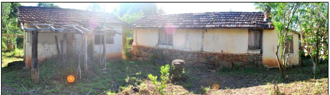
Figura 3.4.2.4.15.6 – Edificação da sede da fazenda com alicerce de pedras.
