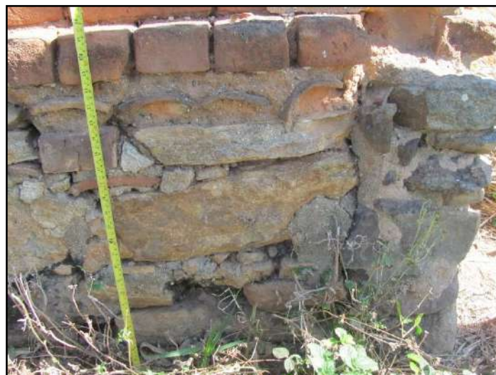
Figura 3.4.2.5.7.8 – Detalhe do alicerce do armazém com inclusão de fragmentos de telha. Coordenadas UTM 794645 E, 7597650 N.
