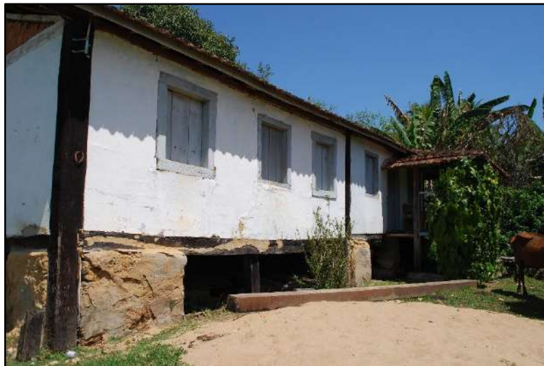
Figura 3.4.2.2.6.4 – Vista da parte frontal da sede.
