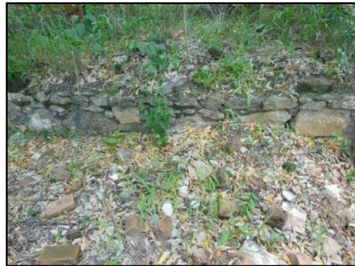
Figura 3.4.2.5.7.12 – Vista de uma edificação com estrutura de pedras e material construtivo na superfície.
