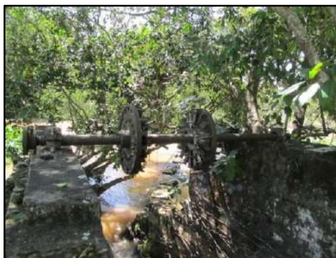
Figura 3.4.2.4.6.2 – Eixo de metal da roda d'água. Coordenadas UTM 780046 E, 7594676 N.
