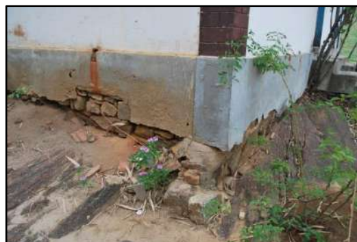
Figura 3.4.2.5.3.3 – Aspectos construtivos. A edificação se encontra sobre um afloramento rochoso e blocos de pedra foram utilizados no alicerce.
