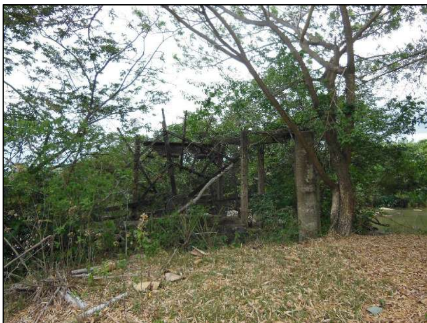
Figura 3.4.2.1.3.1 – Roda d'água. Coordenadas UTM 777762 E, 7594172 N.
