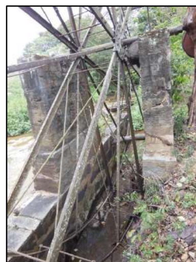
Figura 3.4.2.1.2.2 – Estrutura de sustentação da roda d'água. Coordenadas UTM 776400 E, 7593400 N.
