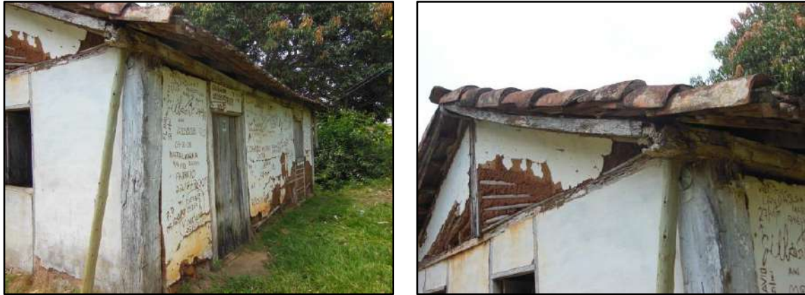
Figura 3.4.2.4.14.2 – Detalhes da edificação, estrutura de pau-a-pique e telhado.
