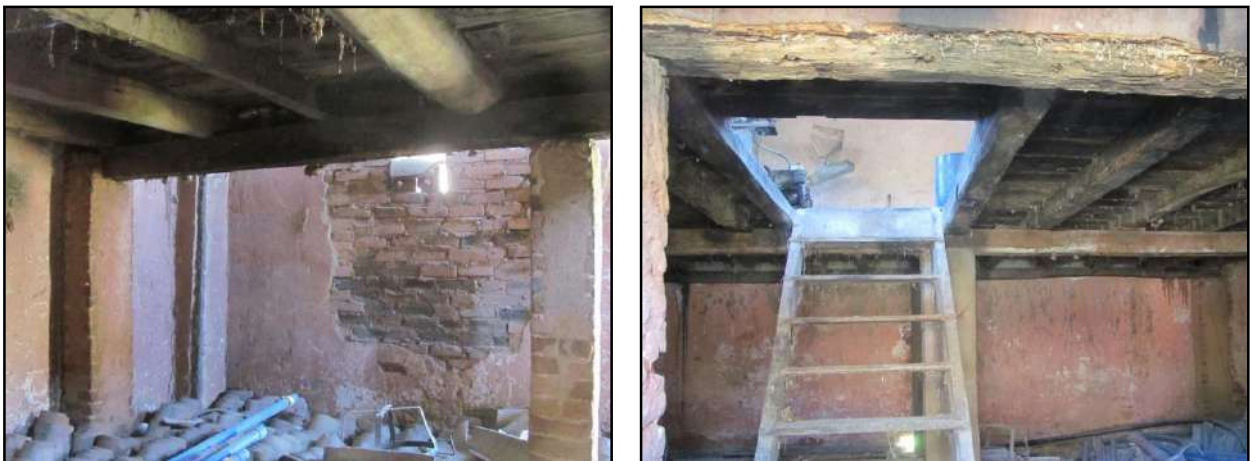
Figura 3.4.2.5.7.7 – Interior do armazém.
