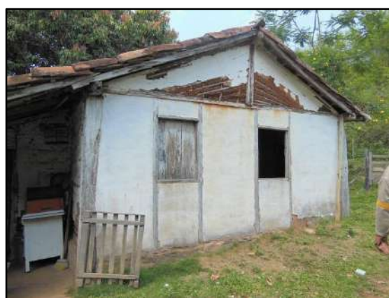
Figura 3.4.2.4.14.1 – Detalhes do telhado e estrutura de pau-a-pique.
