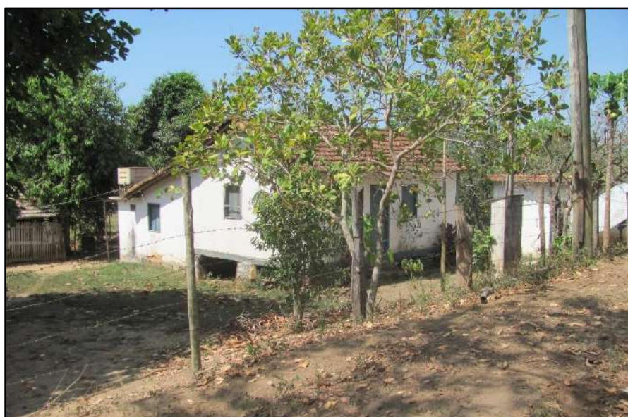
Figura 3.4.2.5.4.1 – Edificação principal da AIC 27 na base da encosta. Coordenadas UTM 790107 E, 7599230 N.
