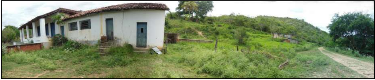
Figura 3.4.2.5.7.3 – Vista da sede da fazenda Cachoeira Alegre com edificação anexa. Coordenadas UTM 794645 E, 7597650 N.
