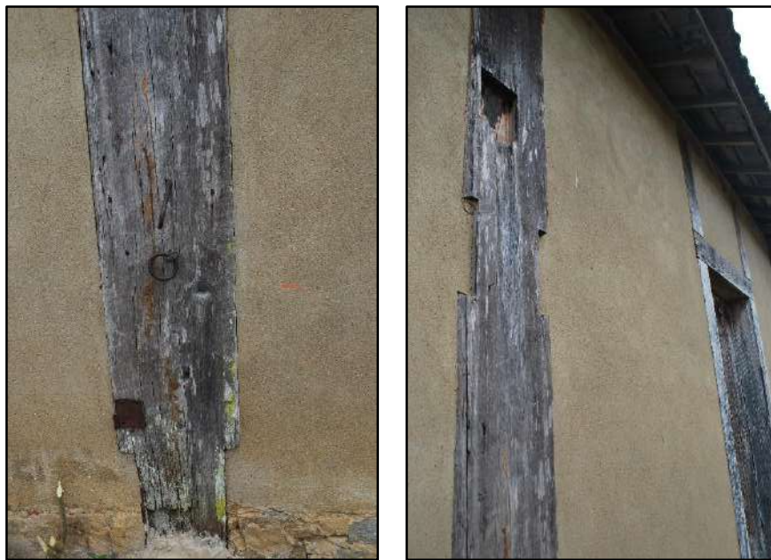
Figura 3.4.2.2.5.2 – Encaixes e dobradiça de outras estruturas construtivas.
