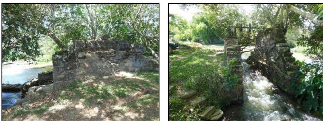
Figura 3.4.2.4.6.1 – Base de sustentação da roda d'água. Coordenadas UTM 780046 E, 7594676 N.
