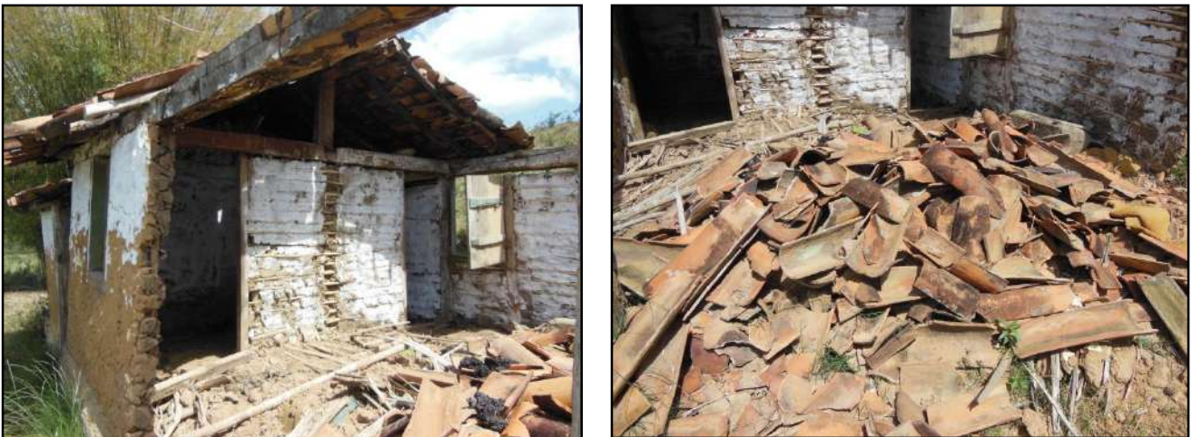
Figura 3.4.2.4.4.4 – Paredes de pau-a-pique e telhas canal.
