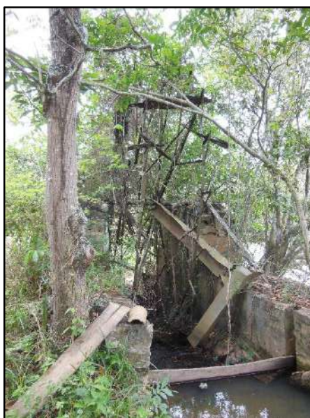
Figura 3.4.2.2.2.2 – Roda d'água. Coordenadas UTM 782517 E, 7599834 N.
