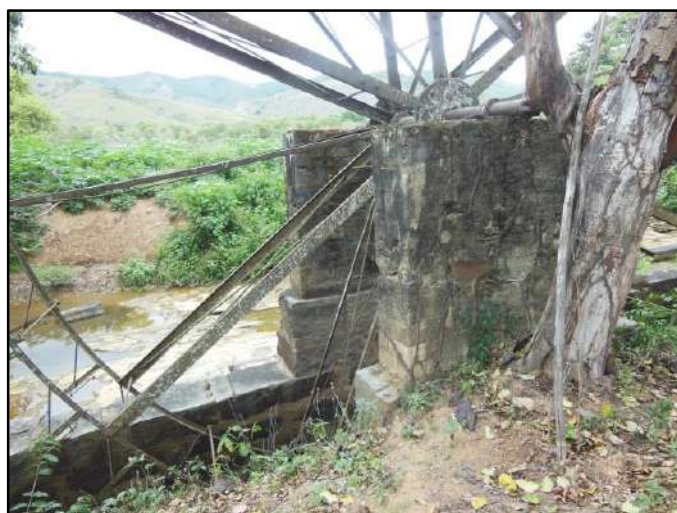
Figura 3.4.2.1.2.2 – Estrutura de sustentação da roda d'água. Coordenadas UTM 776400 E, 7593400 N.
