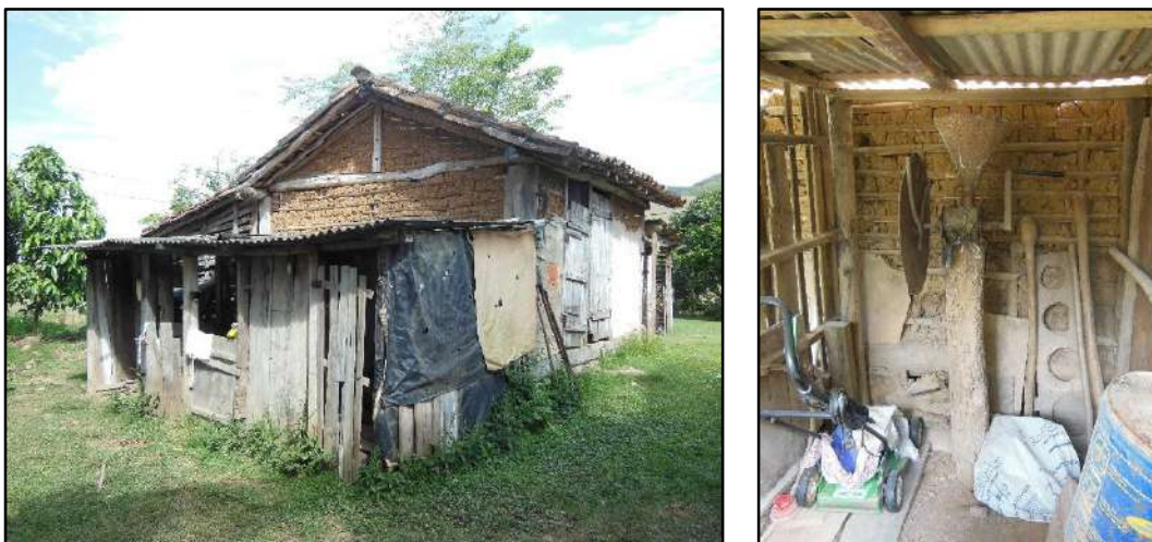
Figura 3.4.2.4.10.3 – Edificação de pau-a-pique utilizada para guardar materiais. No centro e a direita, registra-se um moedor de café e uma trempe de fogão.
