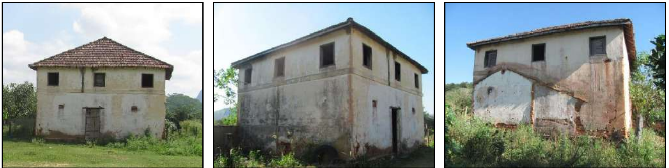
Figura 3.4.2.5.7.6 – Armazém. Coordenadas UTM 794645 E, 7597650 N.
