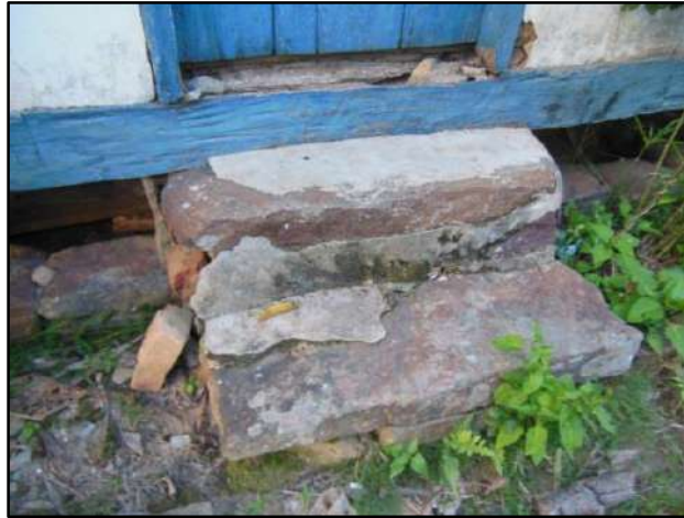
Figura 3.4.2.5.4.3 – Detalhes do degrau com blocos de pedra.
