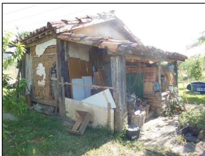
Figura 3.4.2.4.7.1– Edificação antiga da AIC 10. Coordenadas UTM 790987 E, 7594883 N.
