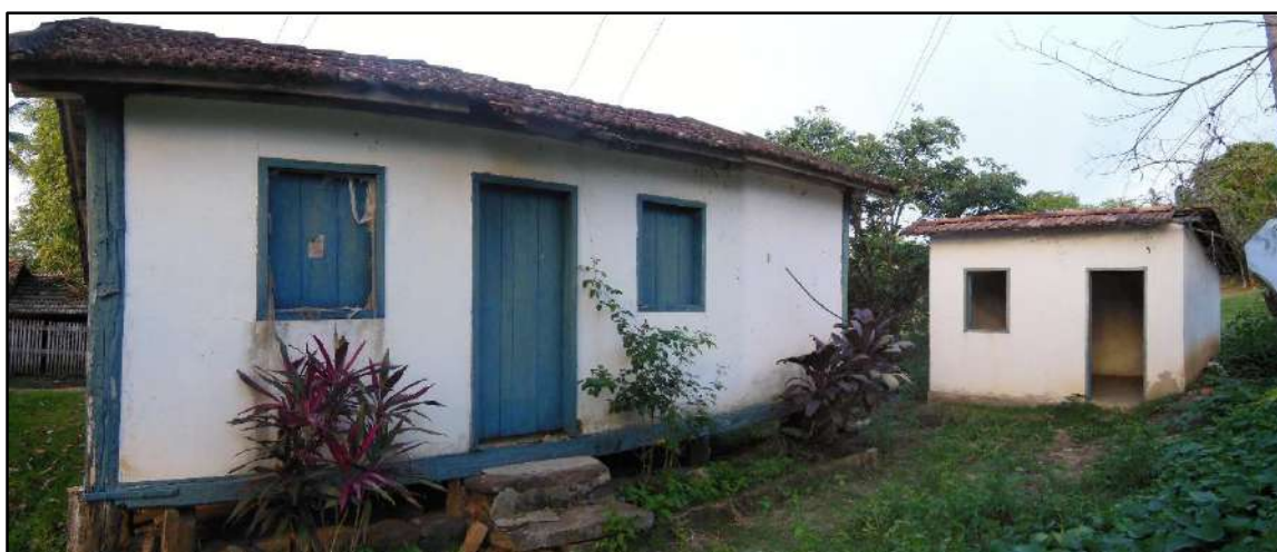
Figura 3.4.2.5.4.2 – Vista da edificação. Coordenadas UTM 790107 E, 7599230 N.
