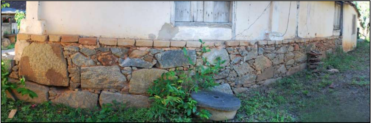
Figura 3.4.2.4.15.7 – Detalhe do alicerce de pedras.
