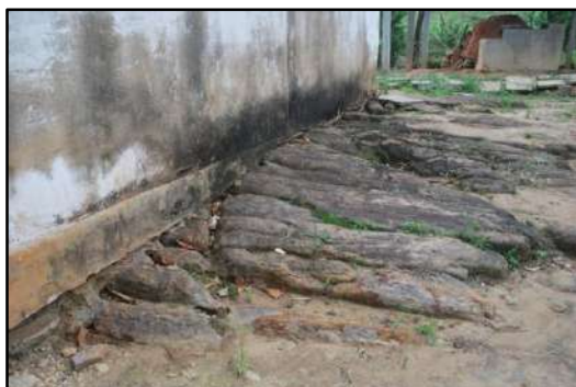
Figura 3.4.2.5.3.3 – Aspectos construtivos. A edificação se encontra sobre um afloramento rochoso e blocos de pedra foram utilizados no alicerce.
