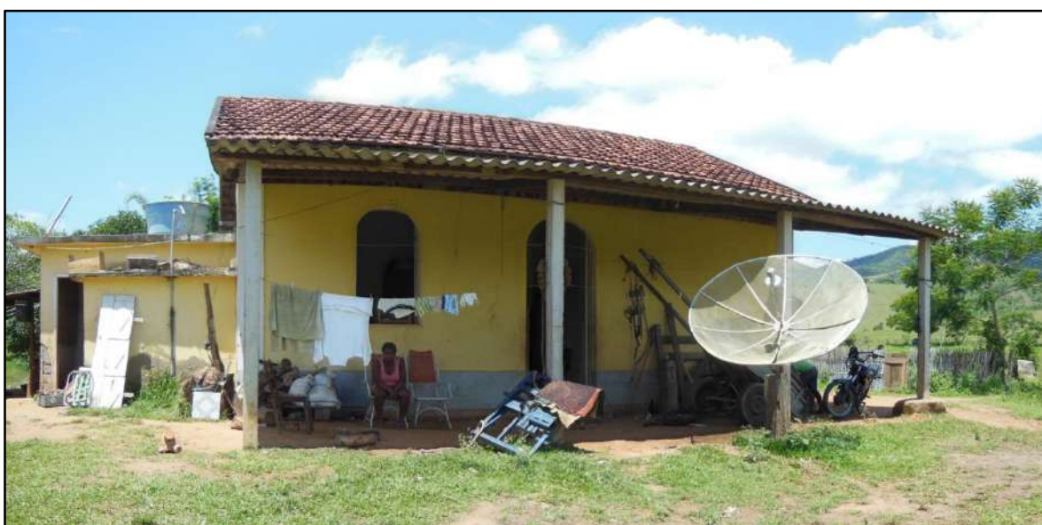
Figura 3.4.2.4.13.2 – Lateral da edificação. Coordenadas UTM 784223 E, 7596523 N.
