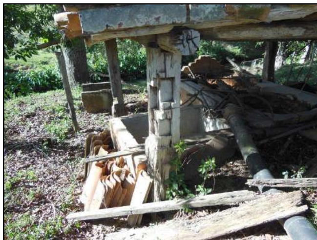
Figura 3.4.2.4.7.4 – Detalhes da coluna de sustentação do engenho. Coordenadas UTM 790987 E, 7594883 N.
