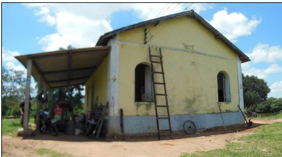
Figura 3.4.2.4.13.1 – Igreja que atualmente é utilizada como residência. Data fachada: 1937. Coordenadas UTM 784223 E, 7596523 N.
