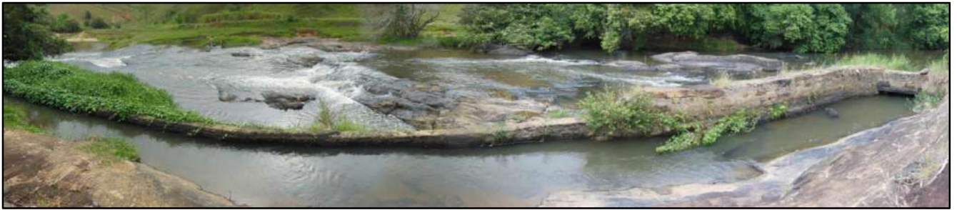
Figura 3.4.2.2.2.7 – Estrutura de pedra para desvio do rio Pirapetinga. Coordenadas UTM 782517 E, 7599834 N.
