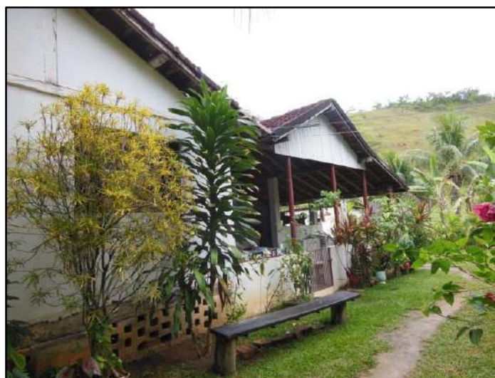
Figura 3.4.2.5.2.2 – Vista lateral esquerda da edificação principal. Coordenadas UTM 789946 E, 7598203 N.
