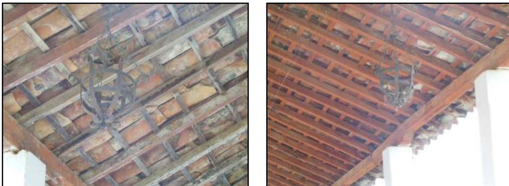
Figura 3.4.2.5.7.10 – Detalhes do telhado da sede. Coordenadas UTM 794645 E, 7597650 N.
