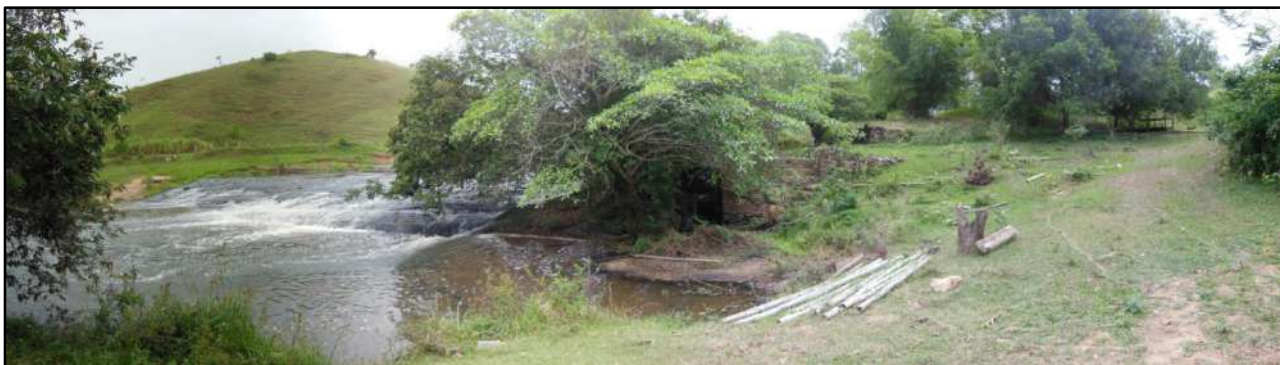
Figura 3.4.2.2.2.1 – Vista geral da AIC 16. Coordenadas UTM 782517 E, 7599834 N.
