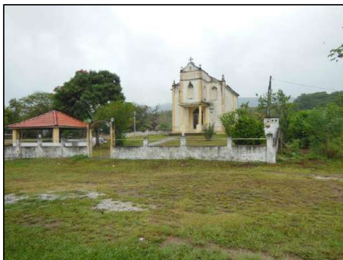
Figura 3.4.2.4.11.1 – Vista geral e de detalhe da AIC 14. Coordenadas UTM 783092 E, 7596291 N.
