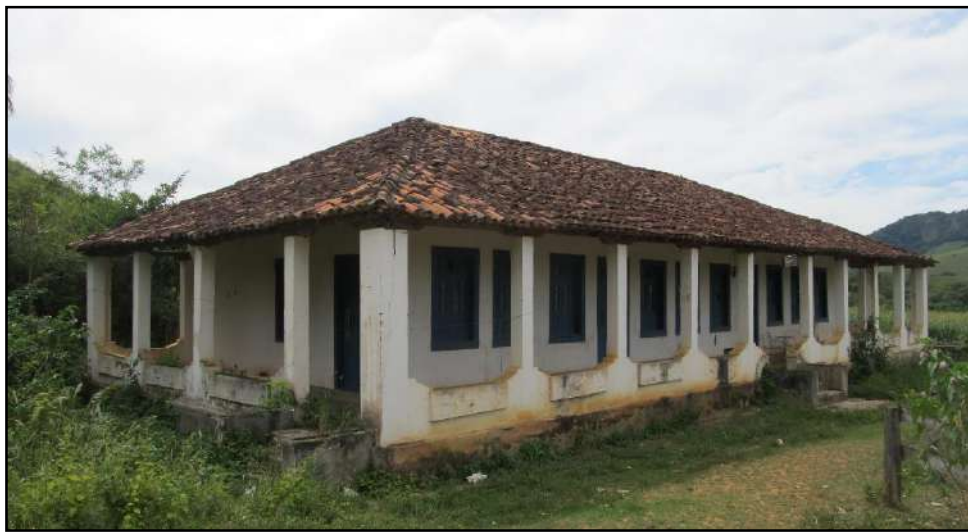
Figura 3.4.2.5.7.4 – Sede da fazenda Cachoeira Alegre. Coordenadas UTM 794645 E, 7597650 N.
