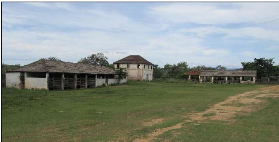
Figura 3.4.2.5.7.5 – Edificações da sede da fazenda Cachoeira Alegre. Coordenadas UTM 794645 E, 7597650 N.
