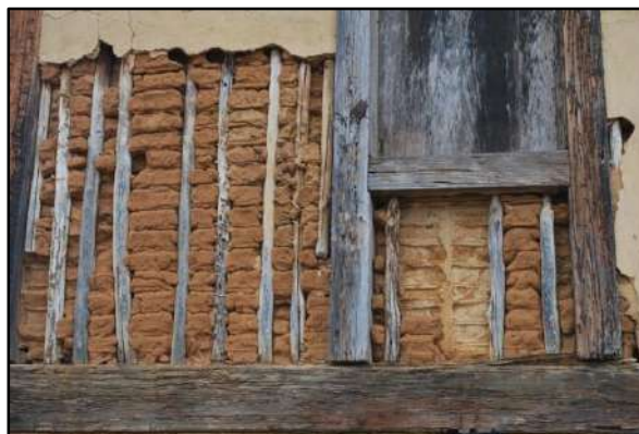
Figura 3.4.2.2.5.1 – Detalhe da parede de pau-a-pique.
