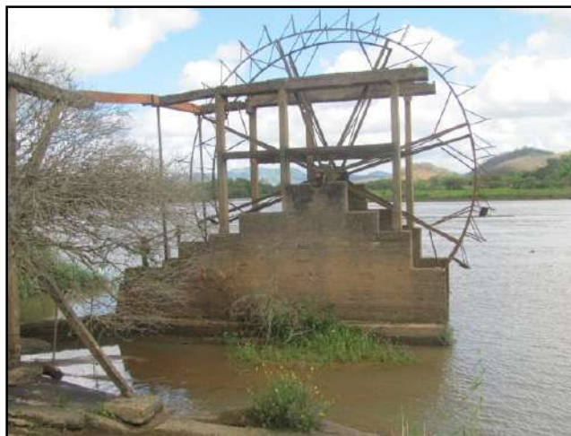
Figura 3.4.2.5.8.2 – Roda d'água. Coordenadas UTM 796398 E, 7597036 N.
