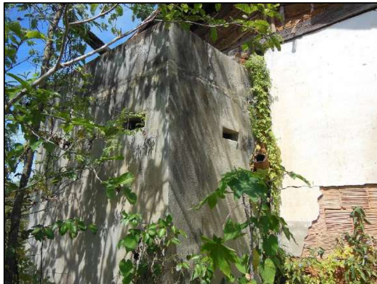
Figura 3.4.2.4.9.5 – Vista do detalhe da construção com material construtivo recente.
