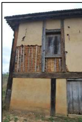
Figura 3.4.2.2.5.1 – Detalhe da parede de pau-a-pique.
