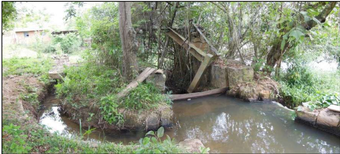
Figura 3.4.2.2.2.3 – Roda d'água e muretas do sistema de desvio da água do rio Pirapetinga. Coordenadas UTM 782517 E, 7599834 N.
