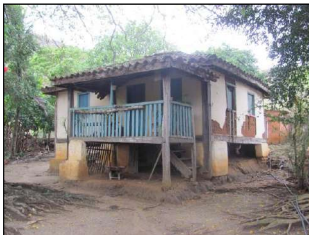
Figura 3.4.1.3.16.2 – Edificação antiga na área do sítio Lagoa 4.
