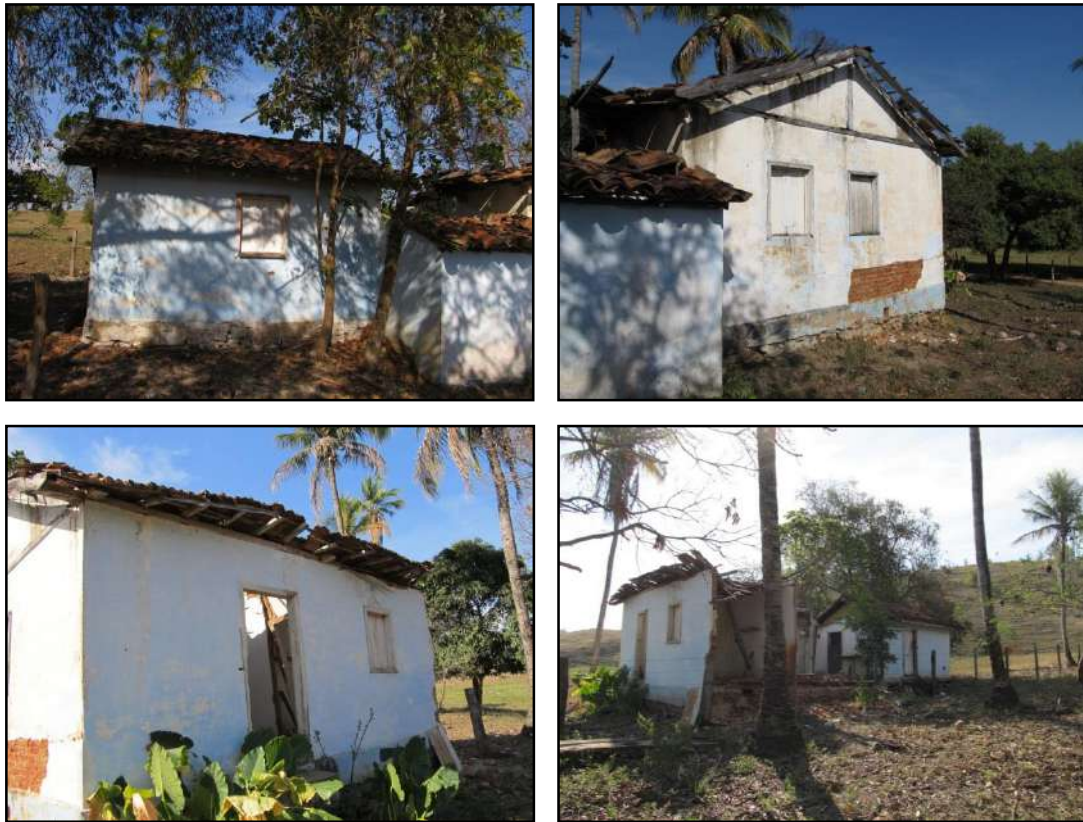
Figura 3.4.1.3.22.7 – Vistas da edificação antiga. Coordenadas UTM 793891 E, 7602784 N.
