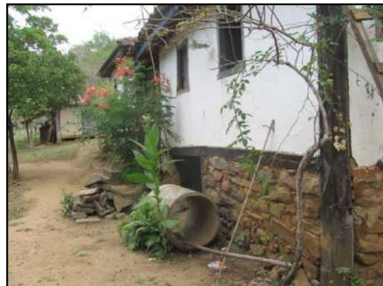
Figura 3.4.1.3.15.4 – Lateral da sede e detalhe da estrutura de alicerce de pedras. Coordenadas UTM 790943 E, 7602800 N.
