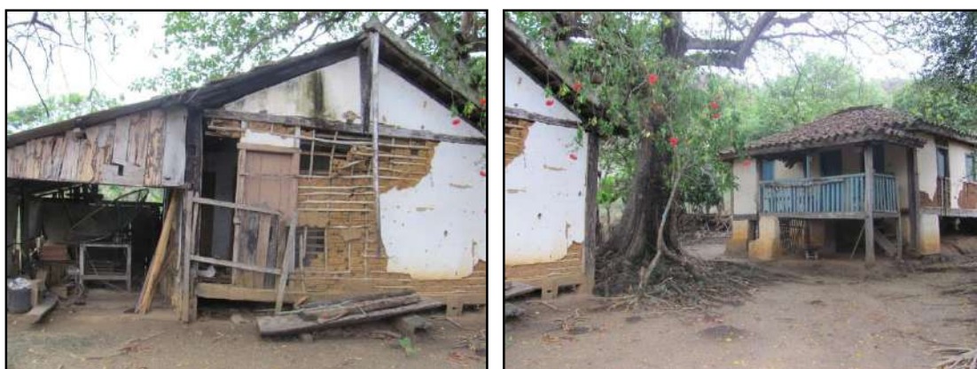
Figura 3.4.1.3.16.3 – Edificações antigas. Ao lado da que está na figura anterior há uma edificação de pau-a-pique.
