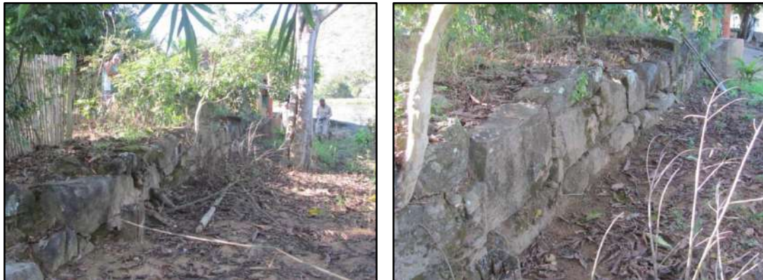
Figura 3.4.1.3.9.2 – Alinhamento de pedras (provável muro de arrimo). Situado no entorno da sondagem com tradagem 1. Coordenadas UTM 792432 E, 7599195 N.
