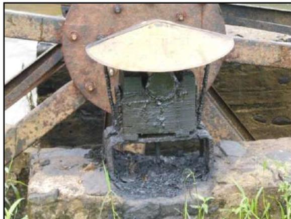
Figura 3.4.1.2.17.6 – Detalhes da estrutura de alvenaria e ferro da roda d'água. Área do sítio Cachoeira dos Patos 1. Coordenadas UTM 782728 E, 7596486 N.
