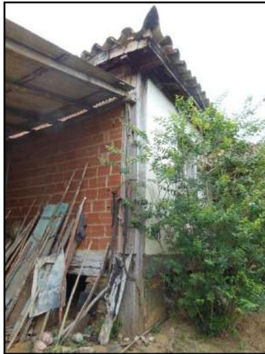
**Figura 3.4.1.2.12.4 – Parte posterior da edificação principal com substituição da parede por material recente.**
