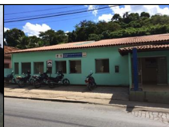
Figura 2. Prédio da Unidade de Saúde da Família 03 em Pirapetinga- MG, local onde foi realizada reunião técnica com gestores e membros da Vigilância Ambiental.
