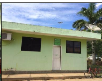
Figura 8. Fachada da entrada do ponto de apoio de agentes de controle de endemias do Programa Municipal de Controle de Dengue de Santo Antônio de Pádua- RJ.
