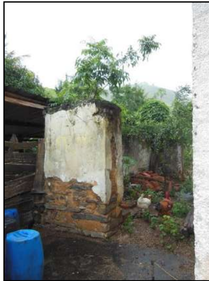
Figura 3.4.1.5.4.7 – Pilar antigo. Lateral da sede atual.
