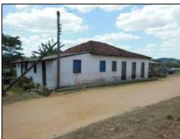
Figura 3.4.2.4.2.2 – Vista da antiga venda. Coordenadas UTM 777527 E, 7593445 N.
