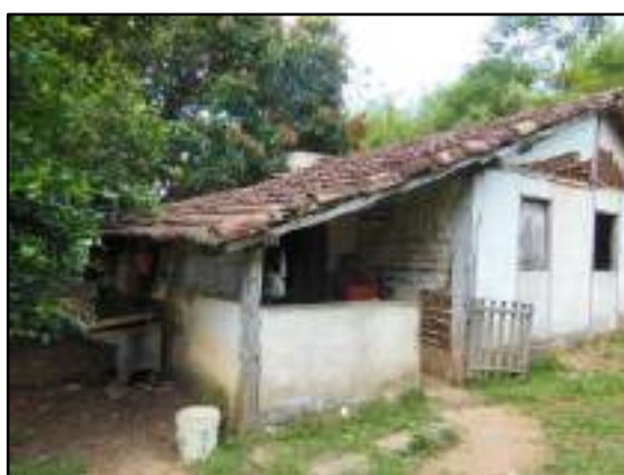
Figura 3.4.2.4.14.1 – Detalhes do telhado e estrutura de pau-a-pique.
