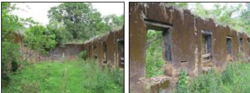
Figura 3.4.1.4.15.5 – Área interna da edificação. Coordenadas UTM 779173 E, 7591204 N.
