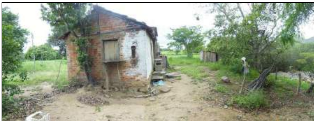
Figura 3.4.1.2.9.2 – Vista da área do sítio Boa Vista 7: edificação e rochas do leito do rio Paraíba do Sul a direita.
