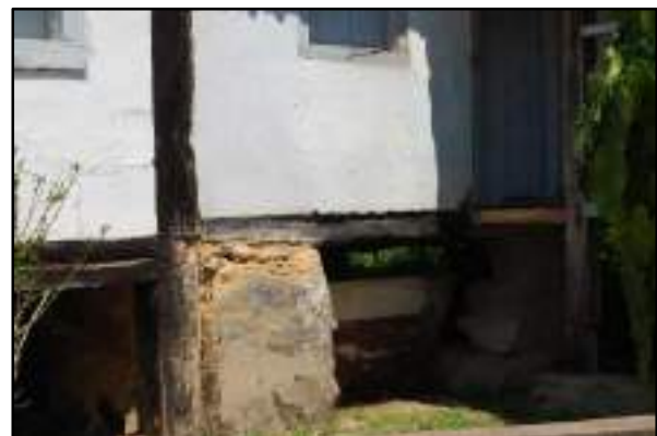
Figura 3.4.2.2.6.5 – Detalhe das estruturas de sustentação da sede em rocha e argamassa similar a saibro.
