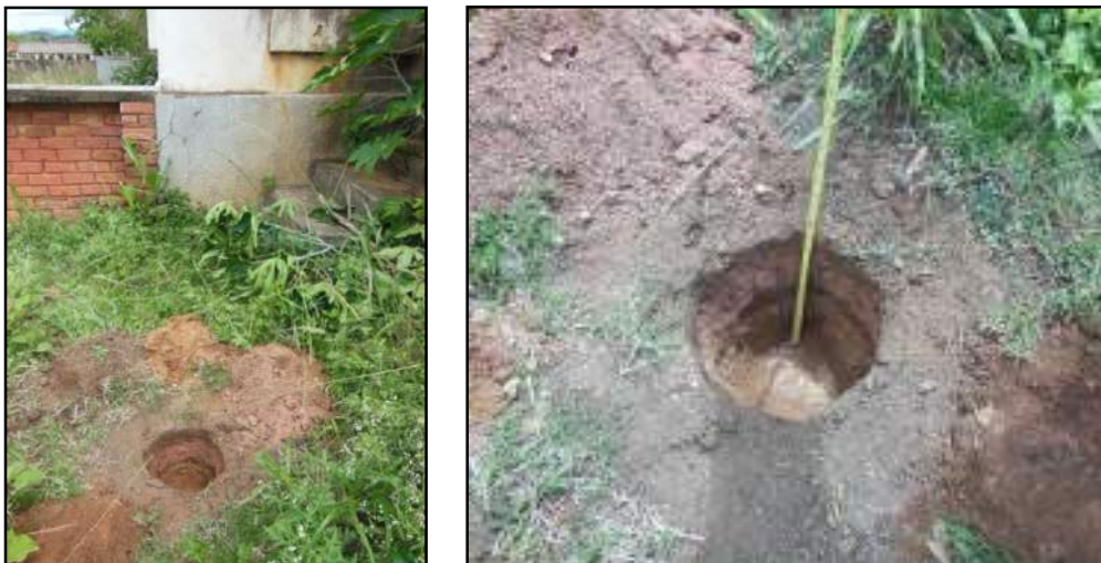
Figura 3.4.2.5.7.11 – Tradagem próximo a sede. Coordenadas UTM 794632 E, 7597655 N.
