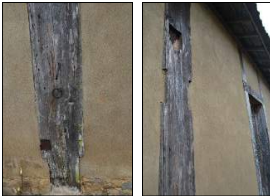
Figura 3.4.2.2.5.2 – Encaixes e dobradiça de outras estruturas construtivas.
