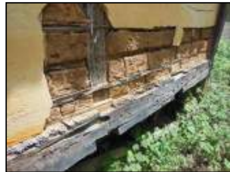
Figura 3.4.1.4.10.6 – Elementos da estrutura da edificação principal com reutilização de peças de madeira.
