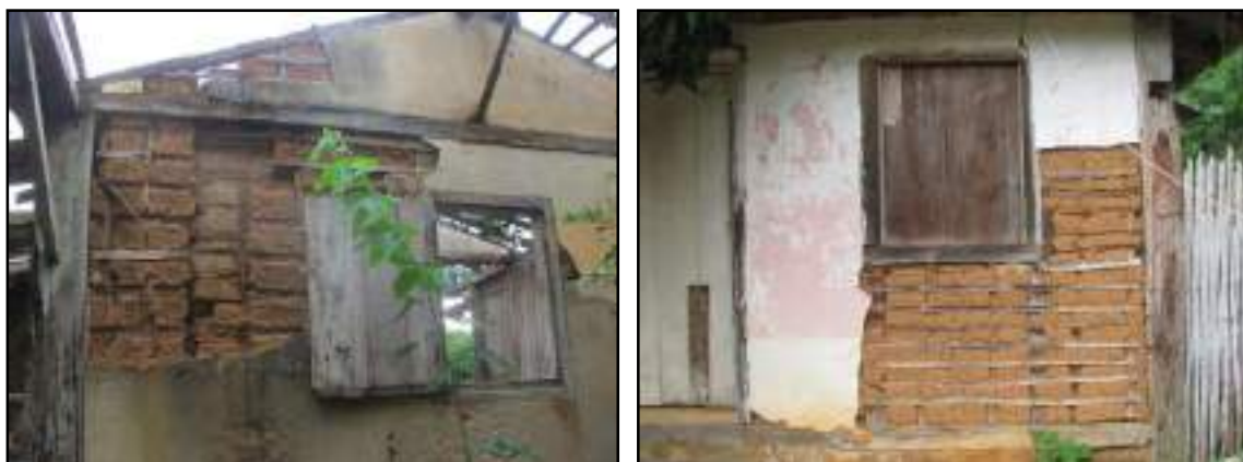
Figura 3.4.1.4.10.5 – Detalhe da estrutura de pau-a-pique da edificação principal.
