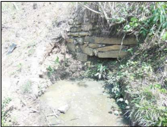
Figura 3.4.1.4.14.8 – Estrutura de pedra na encosta.
