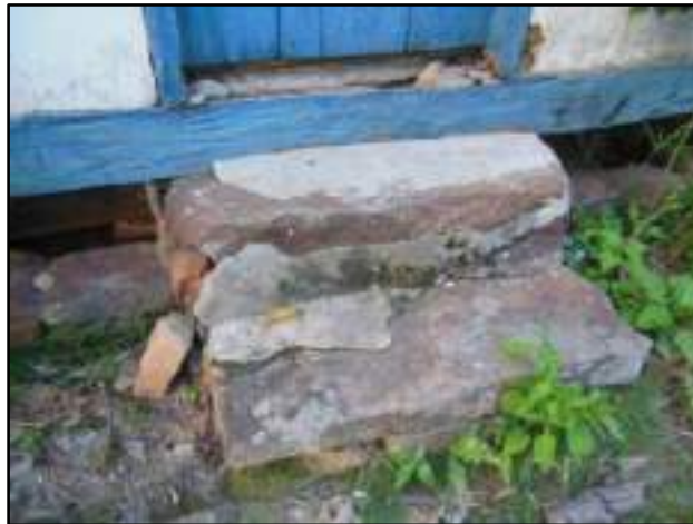
Figura 3.4.2.5.4.3 – Detalhes do degrau com blocos de pedra.
