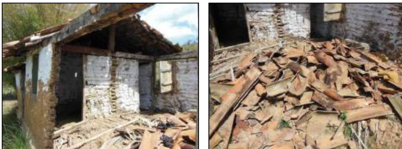
Figura 3.4.2.4.4.4 – Paredes de pau-a-pique e telhas canal.
