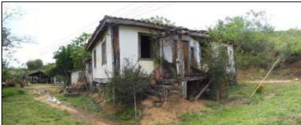
Figura 3.4.1.4.10.4 – Edificação antiga na área de ocupação 1.
