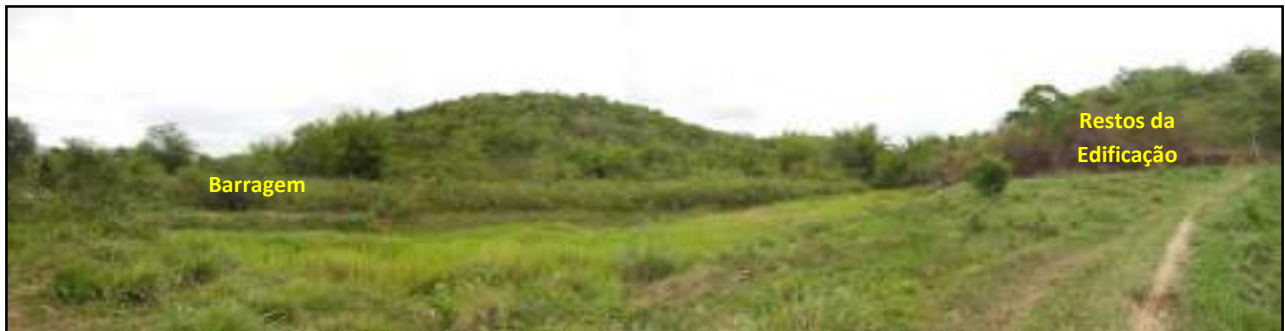
Figura 3.4.1.2.11.2 – Vista geral com barragem e restos da edificação, onde foram feitas as intervenções.
