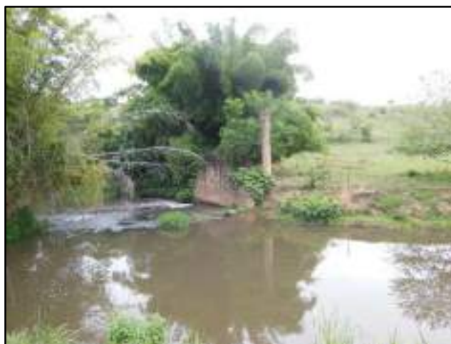
Figura 3.4.2.1.4.1 – Vista geral da roda d'água. Coordenadas UTM 781791 E, 7600444 N.
