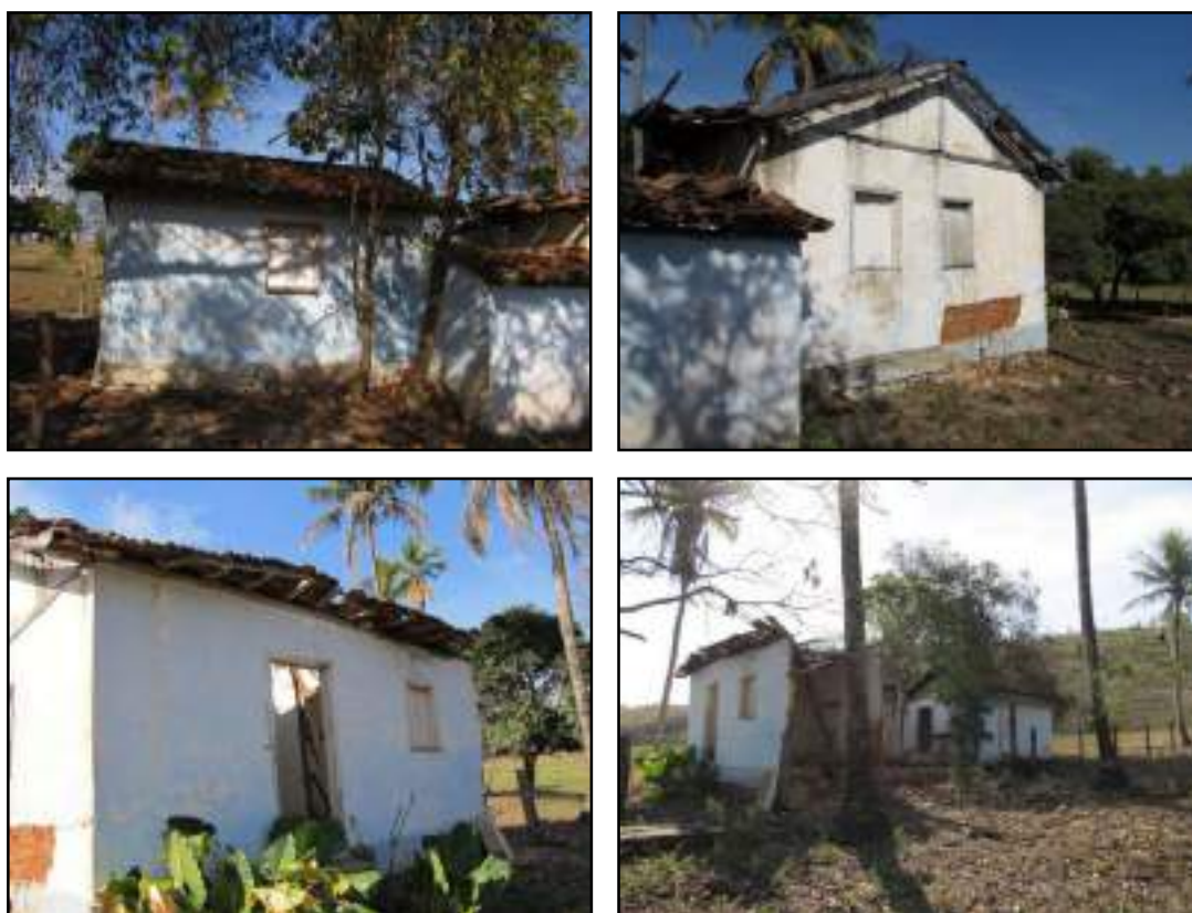
Figura 3.4.1.3.22.7 – Vistas da edificação antiga. Coordenadas UTM 793891 E, 7602784 N.
