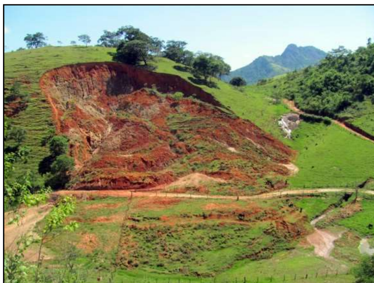
Figura 3.3.26 – Processo erosivo intenso. Coordenadas UTM 796900 E, 7598300 N.
