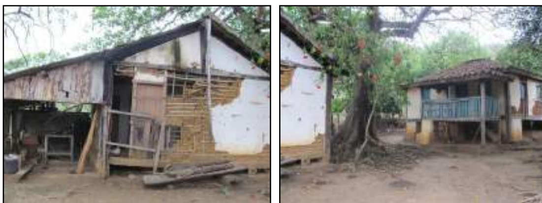
Figura 3.4.1.3.16.3 – Edificações antigas. Ao lado da que está na figura anterior há uma edificação de pau-a-pique.
