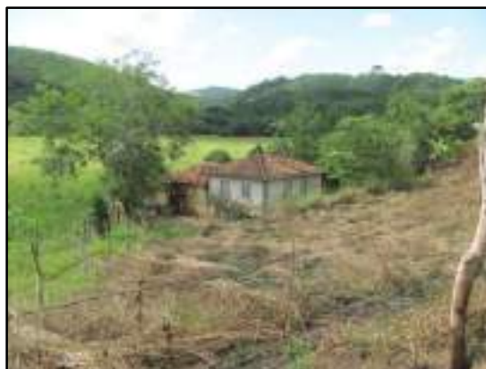
Figura 3.4.2.2.1.1 – Inserção da edificação na paisagem. Coordenadas UTM 782967 E, 7598330 N.
