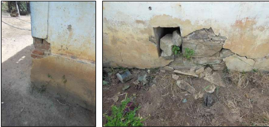
Figura 3.4.1.4.11.6 – Detalhe da construção da sede com tijolos maciços e alicerces de pedra.
