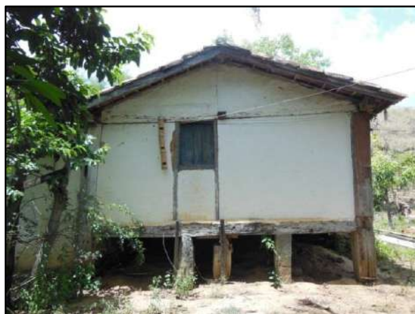
Figura 3.4.2.4.1.2 – Aspectos da edificação. Lateral e blocos rochosos de sustentação na parte frontal. Coordenadas UTM 777332 E, 7593041 N.
