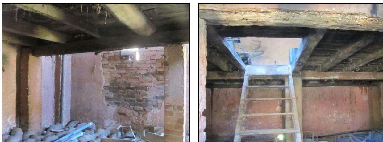
Figura 3.4.2.5.7.7 – Interior do armazém.
