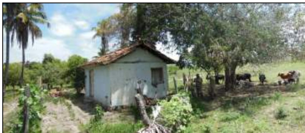
Figura 3.4.1.3.22.8 – Parte posterior da edificação mais antiga com estrada ao fundo.
