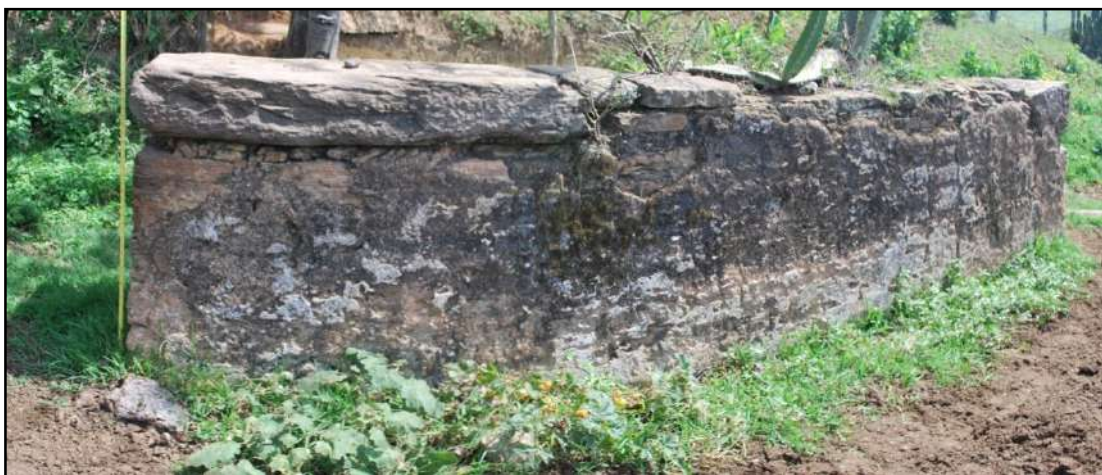
Figura 3.4.1.4.14.4 – Muro de pedra, área do moinho.
