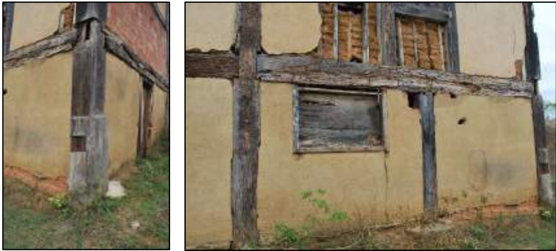
Figura 3.4.2.2.5.2 – Peças de madeira e janela com encaixes de outras estruturas construtivas.
