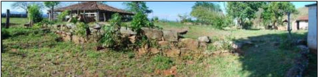
Figura 3.4.2.4.15.8 – Muro de arrimo do terreiro.
