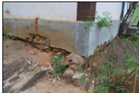
Figura 3.4.2.5.3.3 – Aspectos construtivos. A edificação se encontra sobre um afloramento rochosos e blocos de pedra foram utilizados no alicerce.
