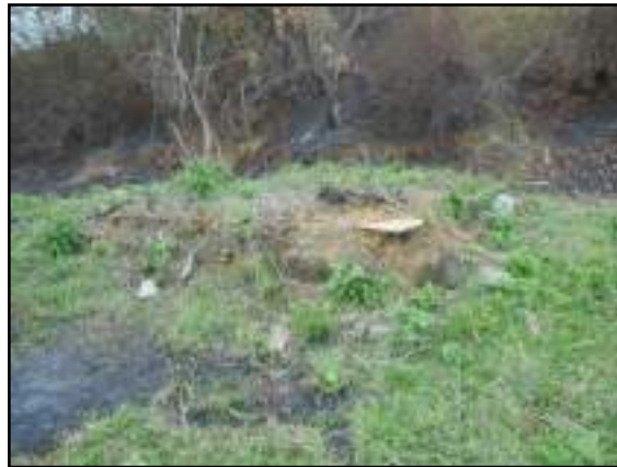
Figura 3.4.1.2.11.5 – Vista dos restos da edificação.
