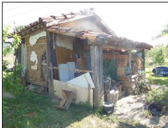
Figura 3.4.2.4.7.1– Edificação antiga da AIC 10. Coordenadas UTM 790987 E, 7594883 N.
