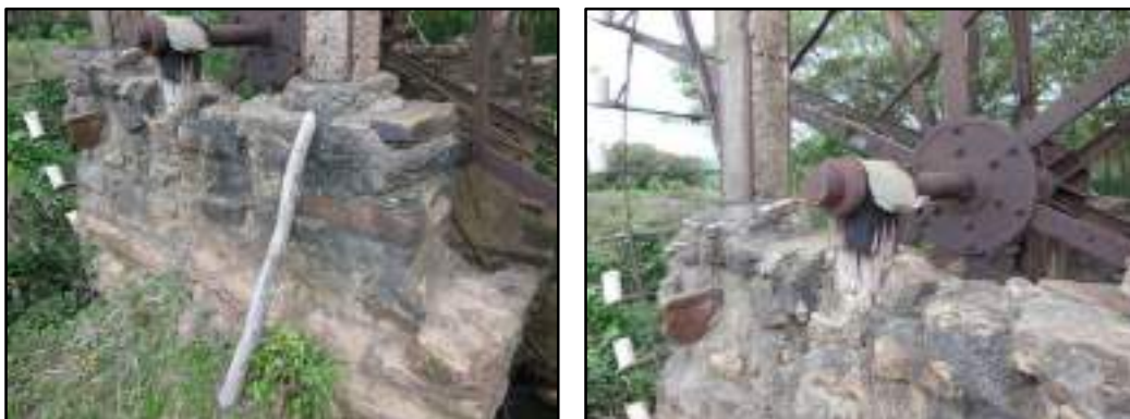
Figura 3.4.2.1.1.2 – Base da roda d'água feita com blocos rochosos. Coordenadas UTM 773421 E, 7593715 N.
