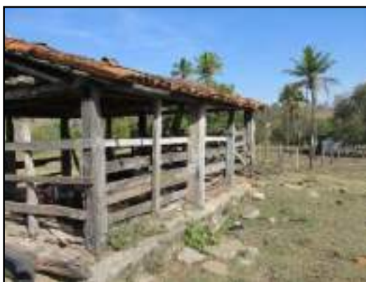
Figura 3.4.1.3.22.6 – Detalhe do curral e residência antiga ao fundo.
