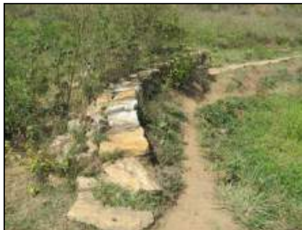
Figura 3.4.1.2.11.4 – Detalhe da barragem.
