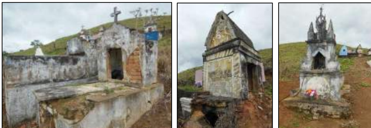
Figura 3.4.2.2.4.4 – Túmulos construídos com tijolos maciços. Coordenadas UTM 786821 E, 7599051 N.
