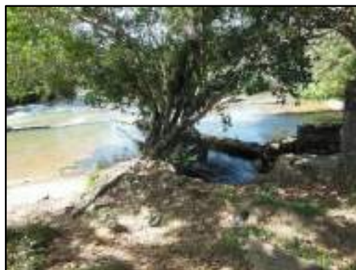
Figura 3.4.2.4.6.3 – Desvio do curso d'água na área da roda d'água. Coordenadas UTM 780046 E, 7594676 N.
