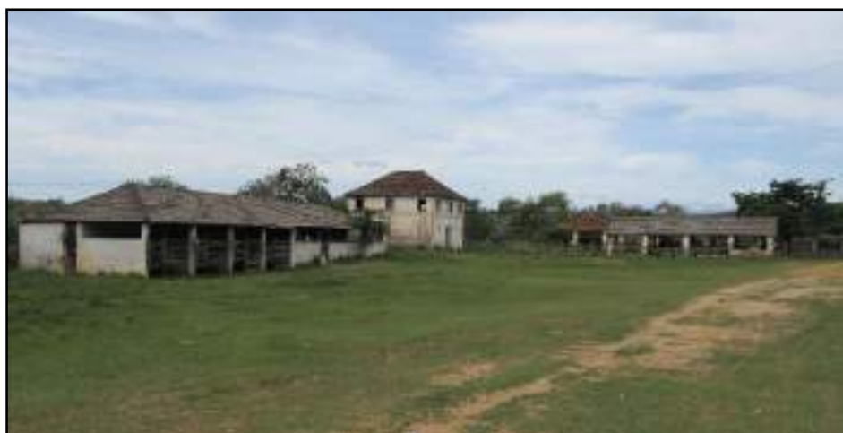
Figura 3.4.2.5.7.5 – Edificações da sede da fazenda Cachoeira Alegre. Coordenadas UTM 794645 E, 7597650 N.
