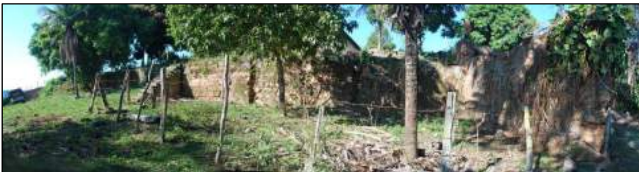
Figura 3.4.2.4.15.1 – Estrutura de pedras da entrada da sede da AIC 40. Coordenadas UTM 785463 E, 7595434 N.
