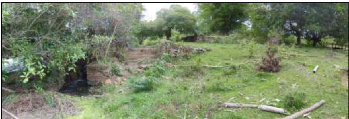
Figura 3.4.2.2.2.5 – Estruturas de pedras da roda d'água e plataforma de pedras acima. Coordenadas UTM 782517 E, 7599834 N.
