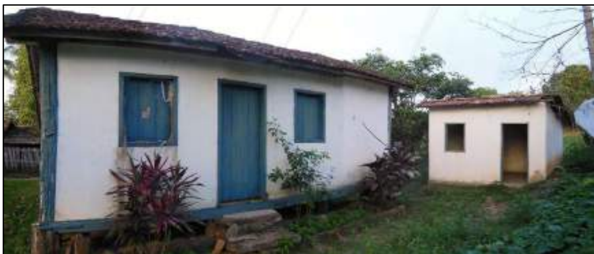
Figura 3.4.2.5.4.2 – Vista da edificação. Coordenadas UTM 790107 E, 7599230 N.
