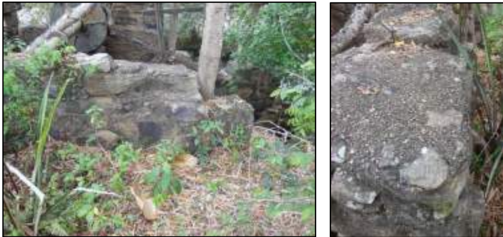
Figura 3.4.2.1.3.3 – Estrutura de sustentação da roda d'água. Coordenadas UTM 77762 E, 7594172 N.
