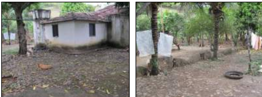
Figura 3.4.1.3.23.5 – Casa recente e calçamento de pedras. Coordenadas UTM 792693 E, 7602904 N.
