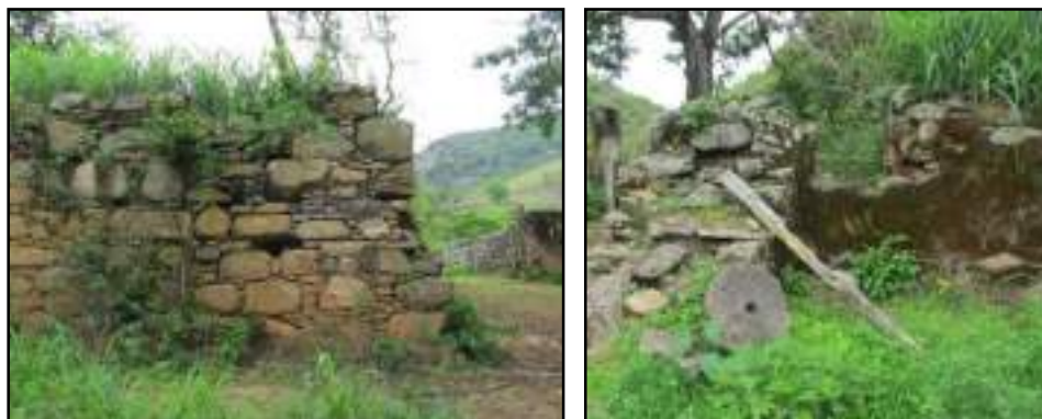
Figura 3.4.1.4.15.6 – Detalhe das estruturas construtivas e pedra de moinho.
