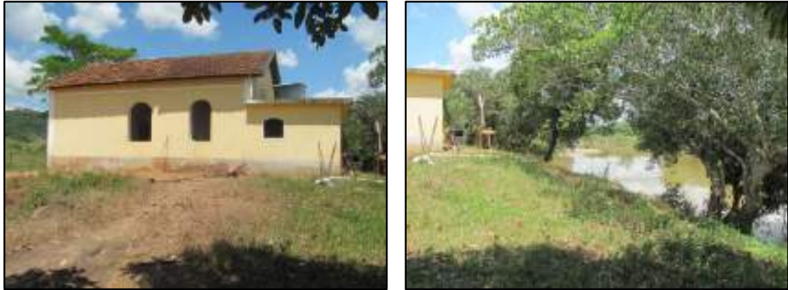
Figura 3.4.2.4.13.3 – Lateral da edificação e rio Paraíba do Sul.
