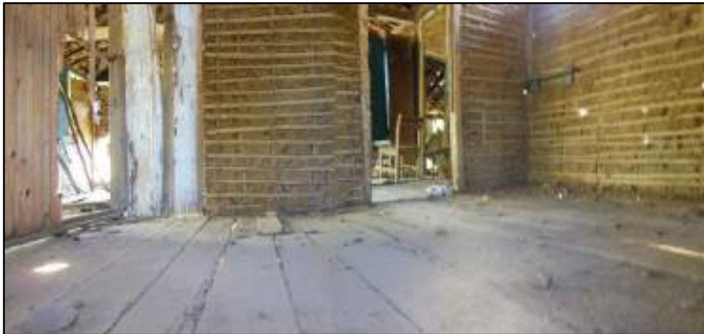
Figura 3.4.2.4.9.4 – Interior da edificação com assoalho de madeira. Coordenadas UTM 781549 E, 7595446 N.
