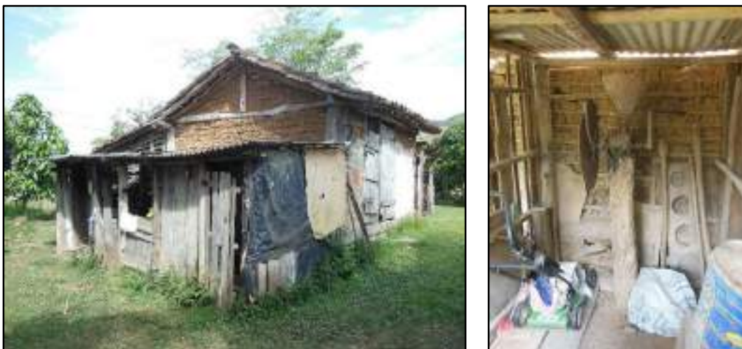
Figura 3.4.2.4.10.3 – Edificação de pau-a-pique utilizada para guardar materiais. No centro e a direita, registra-se um moedor de café e uma trempe de fogão.
