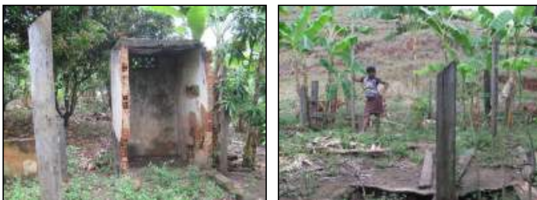
Figura 3.4.1.3.23.7 – Vista da área posterior da sede rural com construções mais recentes. Coordenadas UTM 792711 E, 7602964 N.
