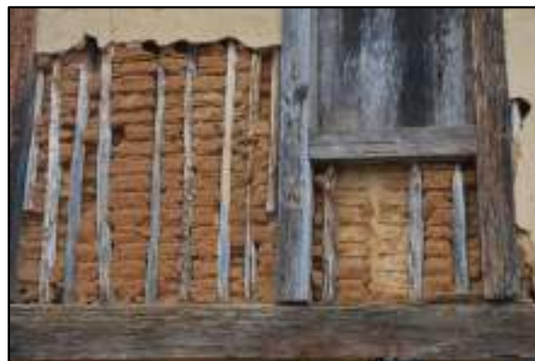
Figura 3.4.2.2.5.1 – Detalhe da parede de pau-a-pique.
