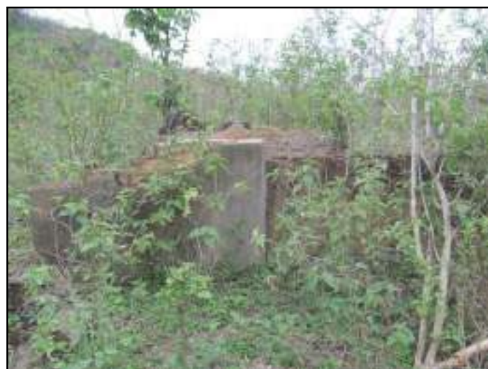
Figura 3.4.1.2.14.2 – Antiga edificação. Coordenadas UTM 786251 E, 7601233 N
