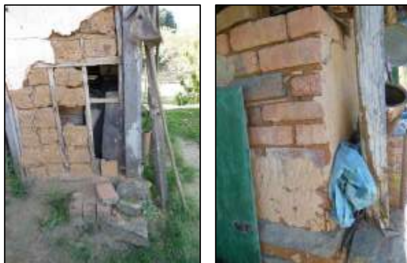
Figura 3.4.2.4.7.2 – Detalhes da edificação com estrutura de pau-a-pique e tijolos maciços. Coordenadas UTM 790987 E, 7594883 N.
