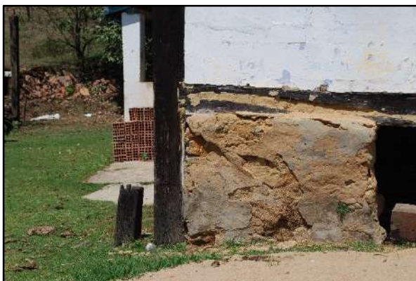
Figura 3.4.2.2.6.5 – Detalhe das estruturas de sustentação da sede em rocha e argamassa similar a saibro.
