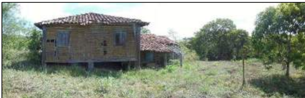
Figura 3.4.2.4.9.2 – Edificação de pau-a-pique. Coordenadas UTM 781549 E, 7595446 N.
