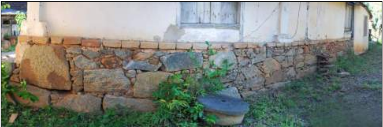
Figura 3.4.2.4.15.7 – Detalhe do alicerce de pedras.
