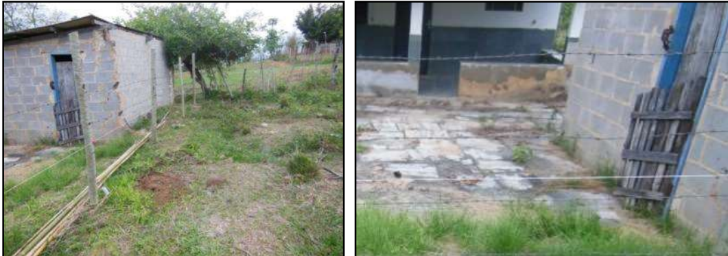
Figura 3.4.1.1.2.3 – Edificação recente de blocos de concreto e detalhe de piso de pedras.
