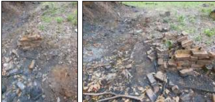
Figura 3.4.1.2.11.6 – Detalhe dos alicerces da edificação.
