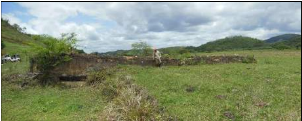
Figura 3.4.1.4.13.7 – Muro lateral esquerdo, face externa.
