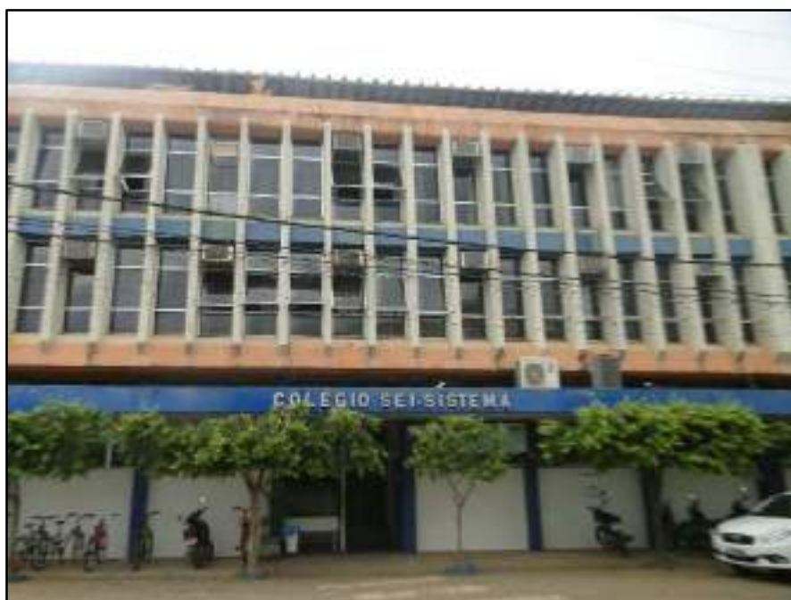
Figura 3.5.5.1 – Fachada do SEI. Sede de Itaocara, RJ.
