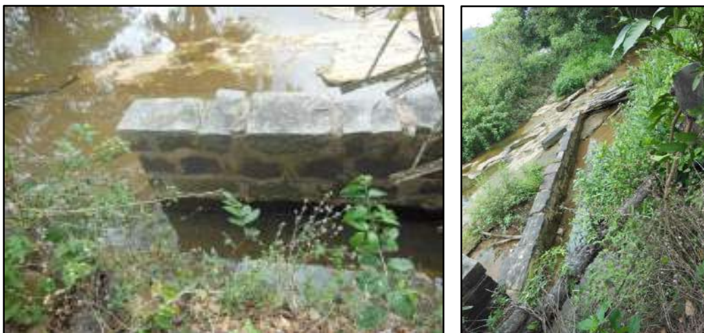
Figura 3.4.2.1.2.3 – Muretas de desvio da água do rio Paraíba do Sul. Coordenadas UTM 776400 E, 7593400 N.
