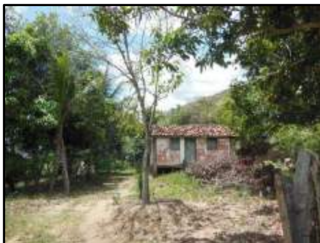
Figura 3.4.2.4.1.1 – Vista geral da AIC 3. Coordenadas UTM 777332 E, 7593041 N.
