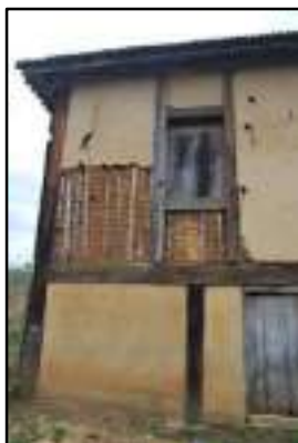
Figura 3.4.2.2.5.1 – Detalhe da parede de pau-a-pique.
