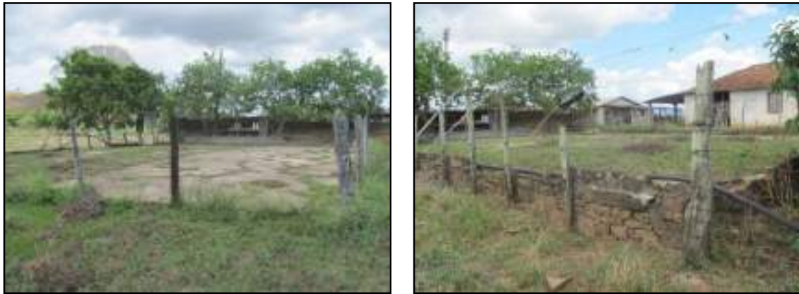
Figura 3.4.2.5.8.3 – Calçamento, a esquerda, e muro de pedras a direita. Ilha Serena. Coordenadas UTM 796565 E, 7596695 N.
