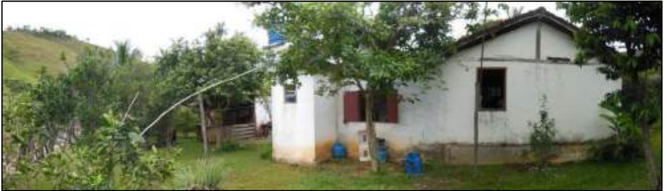
Figura 3.4.2.5.2.3 – Vista lateral direita da edificação principal. Coordenadas UTM 789946 E, 7598203 N.
