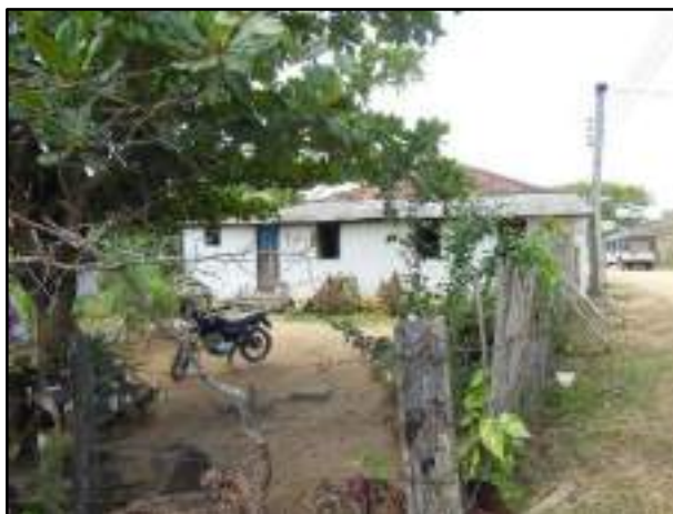
Figura 3.4.2.4.2.1 – Vista da edificação comercial na área do Porto do Tuta. Coordenadas UTM 777527 E, 7593445 N.
