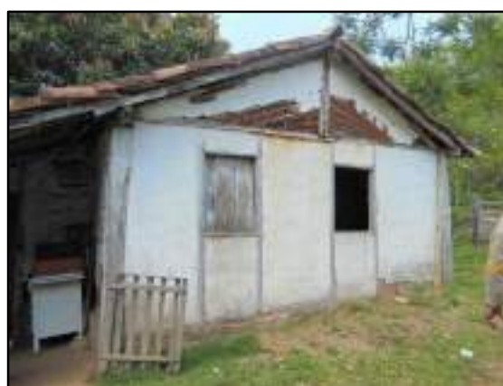
Figura 3.4.2.4.14.1 – Detalhes do telhado e estrutura de pau-a-pique.
