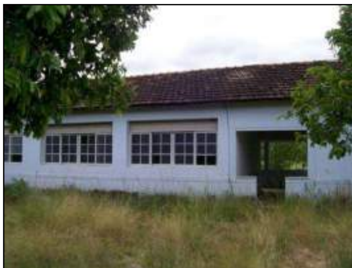
Figura 3.3.10 – Escola desativada. Coordenadas UTM 796900 E, 7597700 N.
