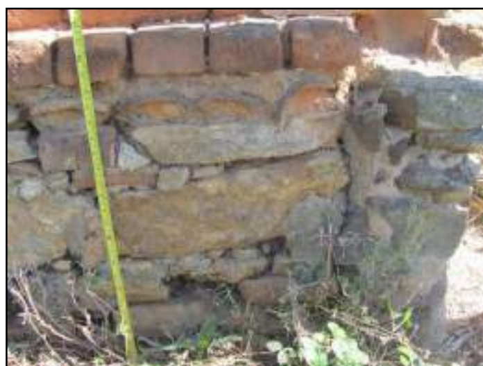
Figura 3.4.2.5.7.8 – Detalhe do alicerce do armazém com inclusão de fragmentos de telha. Coordenadas UTM 794645 E, 7597650 N.
