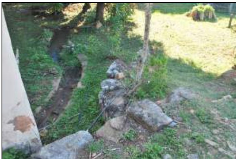
Figura 3.4.2.4.15.9 – Drenagem ao lado do terreiro.
