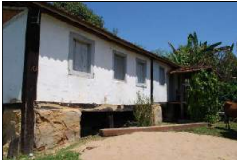
Figura 3.4.2.2.6.4 – Vista da parte frontal da sede.
