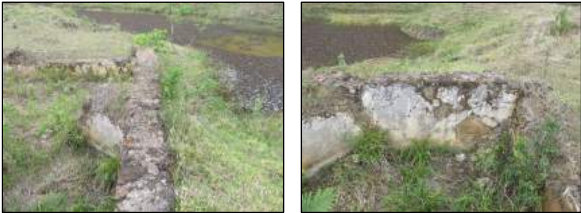
Figura 3.4.1.3.7.6 – Muro de contenção. Coordenadas UTM 791876 E, 7601651 N.
