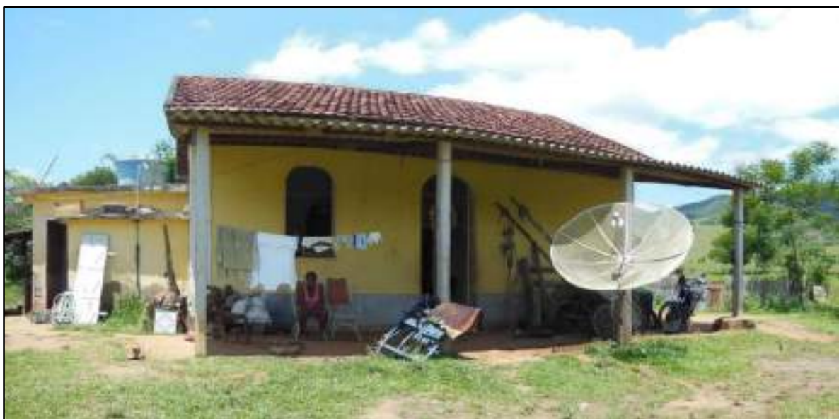
Figura 3.4.2.4.13.2 – Lateral da edificação. Coordenadas UTM 784223 E, 7596523 N.
