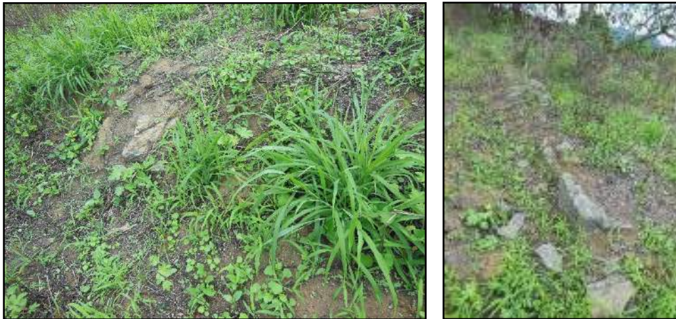
Figura 3.4.1.3.11.8 – Detalhes dos alicerces da edificação antiga.
