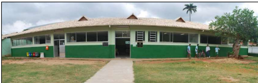
Figura 3.5.4.6 – Fachada da E.M. Manoel Marcelino de Paula. Localidade de São Sebastião do Paraiba, Cantagalo, RJ.
