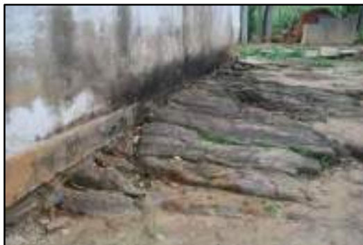
Figura 3.4.2.5.3.3 – Aspectos construtivos. A edificação se encontra sobre um afloramento rochosos e blocos de pedra foram utilizados no alicerce.
