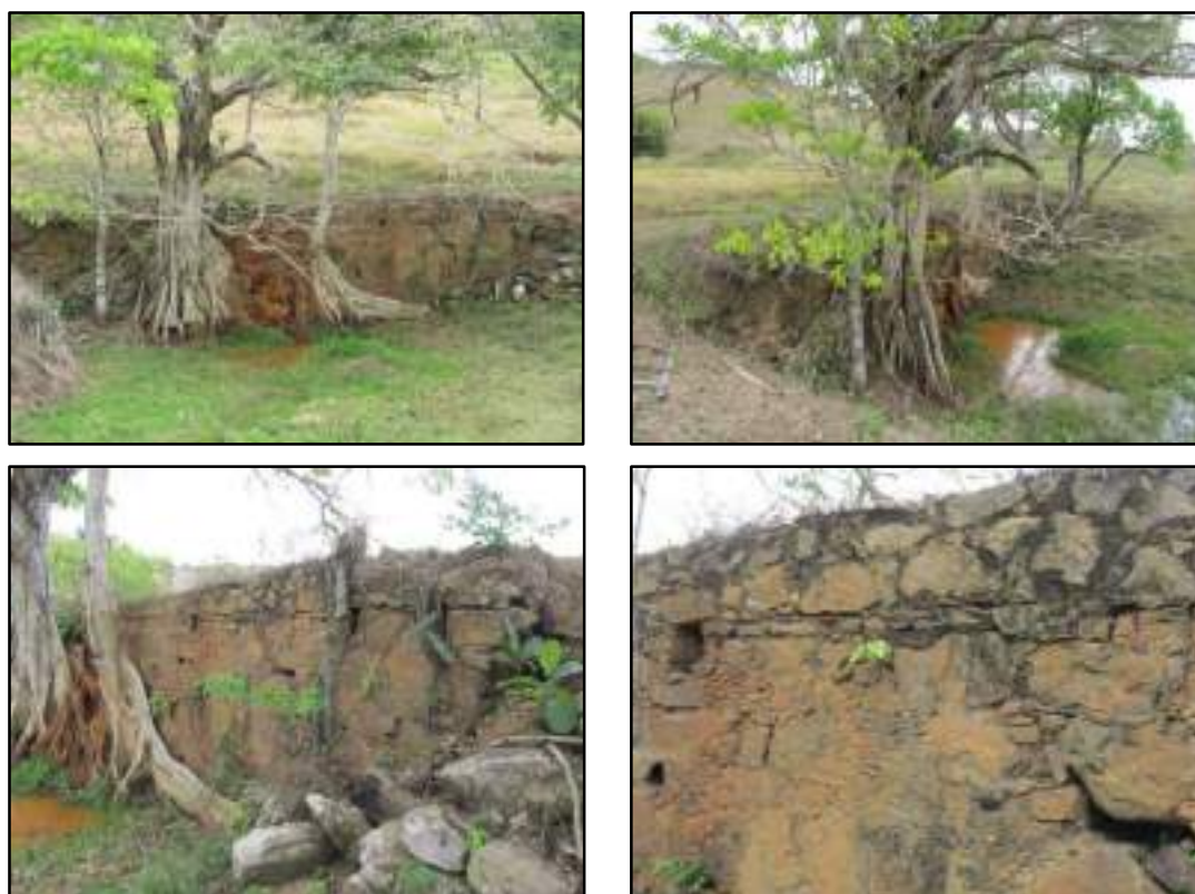
Figura 3.4.1.3.7.4 – Barragem de pedras e acesso a antiga propriedade rural. Coordenadas UTM 791817 E, 7601654 N.
