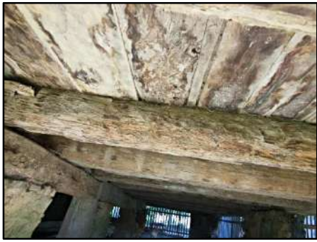
Figura 3.4.2.5.1.3 – Parte posterior da edificação e detalhe das peças de madeira reutilizadas. Coordenadas UTM 787718 E, 7597807 N.
