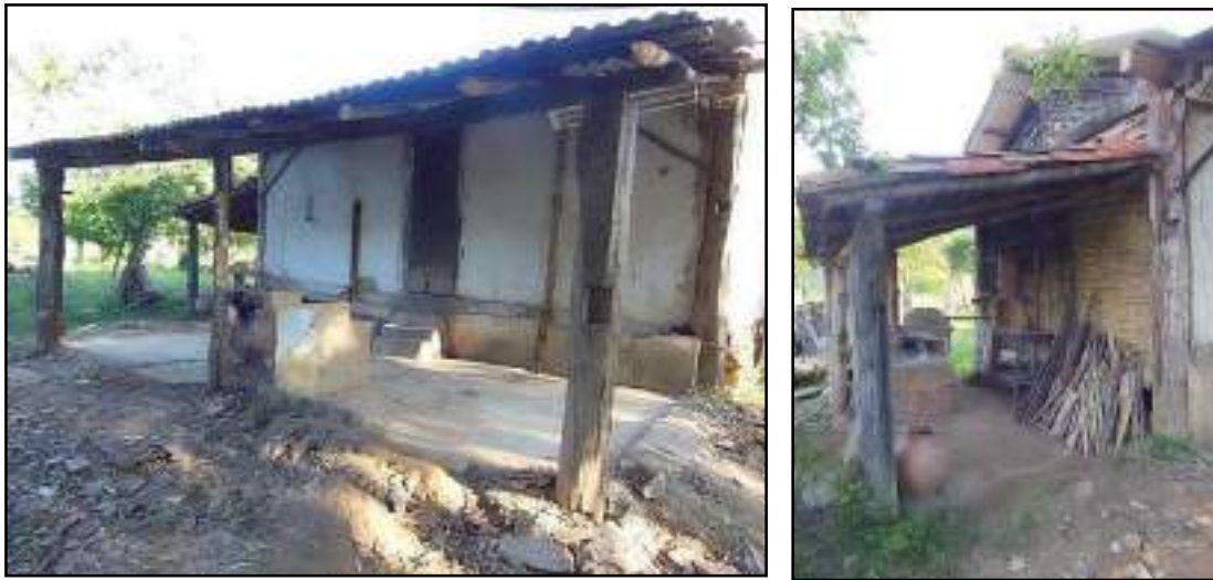
Figura 3.4.1.4.1.4 – Parte posterior e lateral da edificação. Nesta foto aparece o fogão e piso de cimento na parte posterior.
