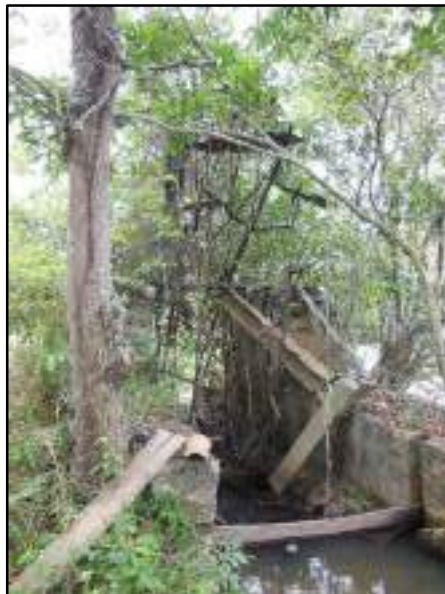
Figura 3.4.2.2.2.2 – Roda d'água. Coordenadas UTM 782517 E, 7599834 N.
