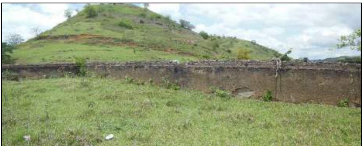
Figura 3.4.1.4.13.8 – Face interna dos muros do cemitério.
